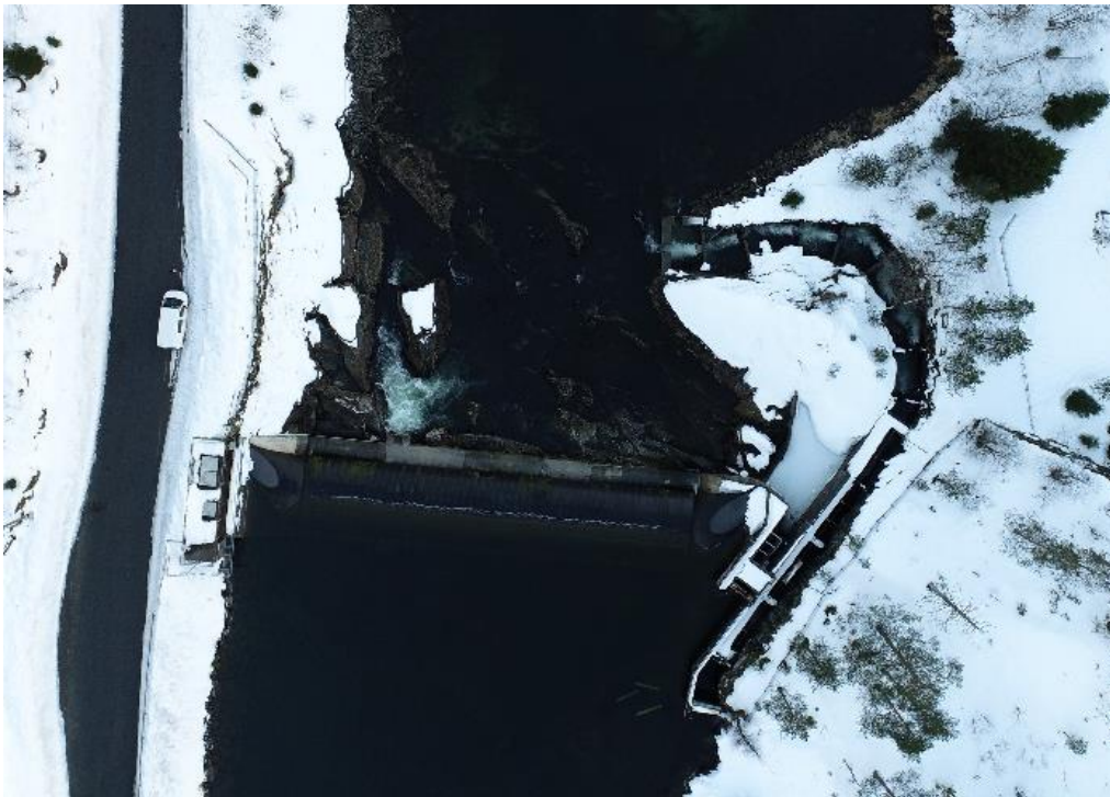
Gummidammen og fisketrappen ved Almelid. Vannføringen i restfeltet styres via et inntak i gummidammen.
