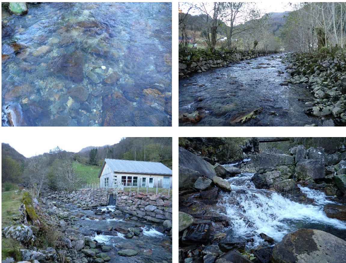
Figur 26. Glattstrøm med grovt substrat og kun spredte forekomster av gytegrus (oppe t.v.), forbygd og trolig kanalisert elvestrekning nederst i elva, med glissen kantvegetasjon (oppe t.h.), kraftverksutløp (nede t.v.) og naturlig temporært vandringshinder (nede t.h.)
