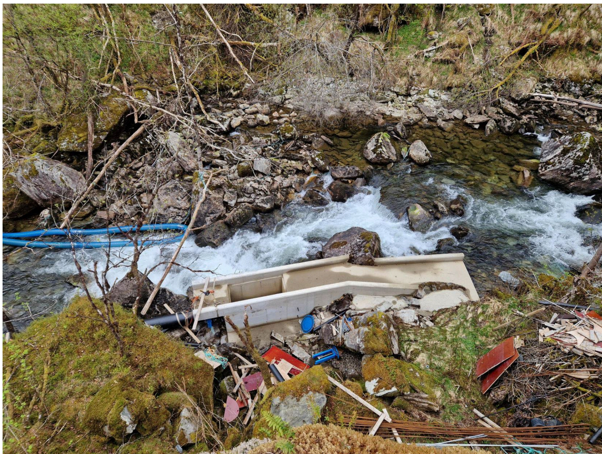
Figur 35. Bygging av inntak til mikro kraftverk i nedre del av Eidselva (bilde tatt 29.04.2024).
