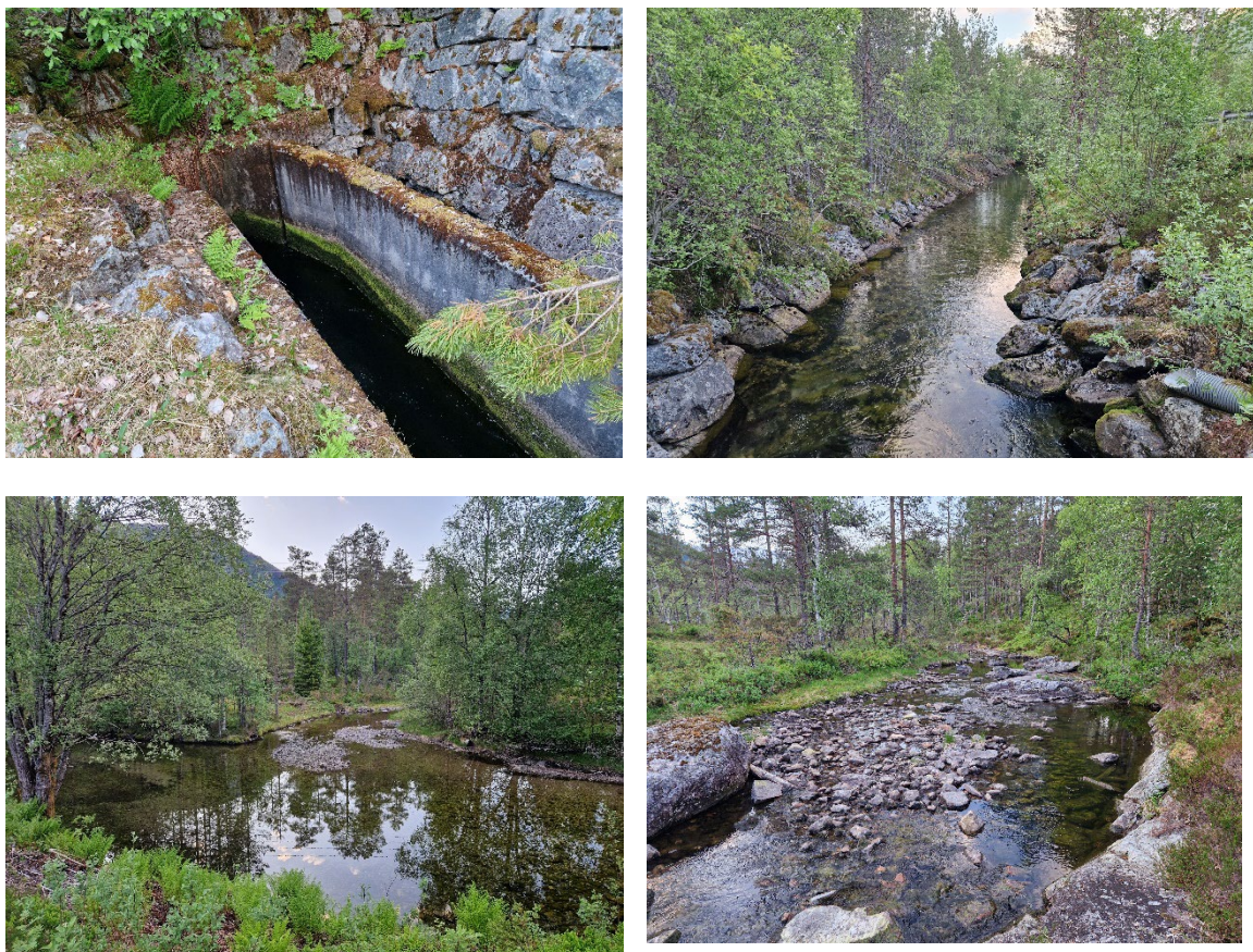
Figur 52. Kraftverksutløpet til Skogheim kraftverk (oppe t.v.), kraftverkskanal med noe gytegrus sett nedover (oppe t.h.), samløp mellom fraført strekning og kraftverkskanal (nede t.v.) og fraført strekning med stein som dominerende substrat og lite vann (nede t.h.)
