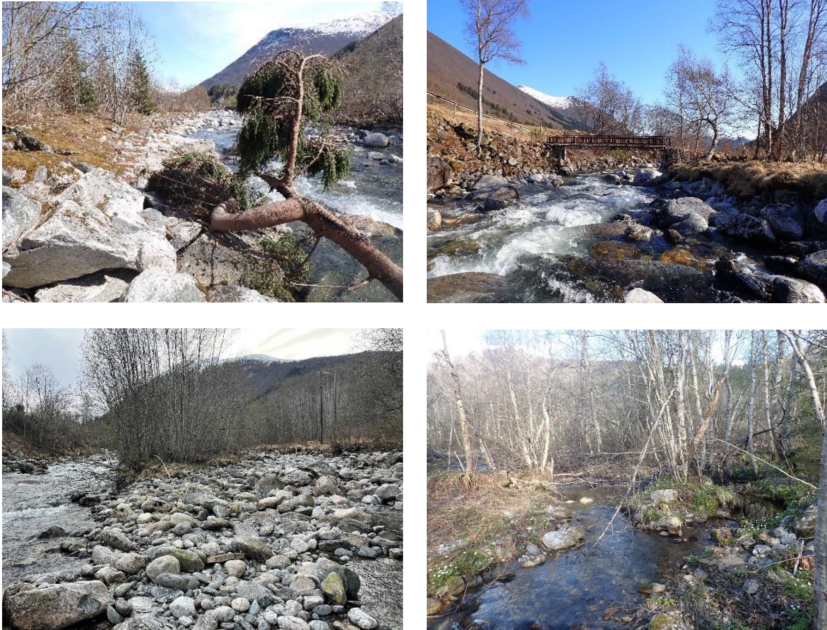
Figur 15. Eksempler på forbygninger (oppe t.v. og t.h.), øy og naturlig sideløp (nede t.v.) og gjenåpnet sideløp ved Moen (nede t.h. – også vist lengst øst på kartet i Figur 14 ).
