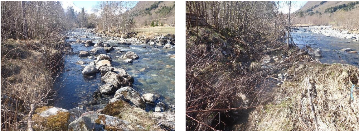
Figur 32. Bune som leder vann mot rørintak til sideløpet ved Øygarden (t.v.) og punkt hvor man kan grave bort litt av elvebredden for å slippe vann inn i nedre del av sideløpet (t.h.).
