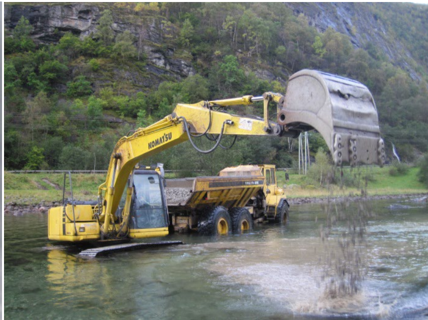
En teleripper kan brukes for å løsne opp hardpakket elvebunn, slik at det blir mer skjul for ungfisk.
