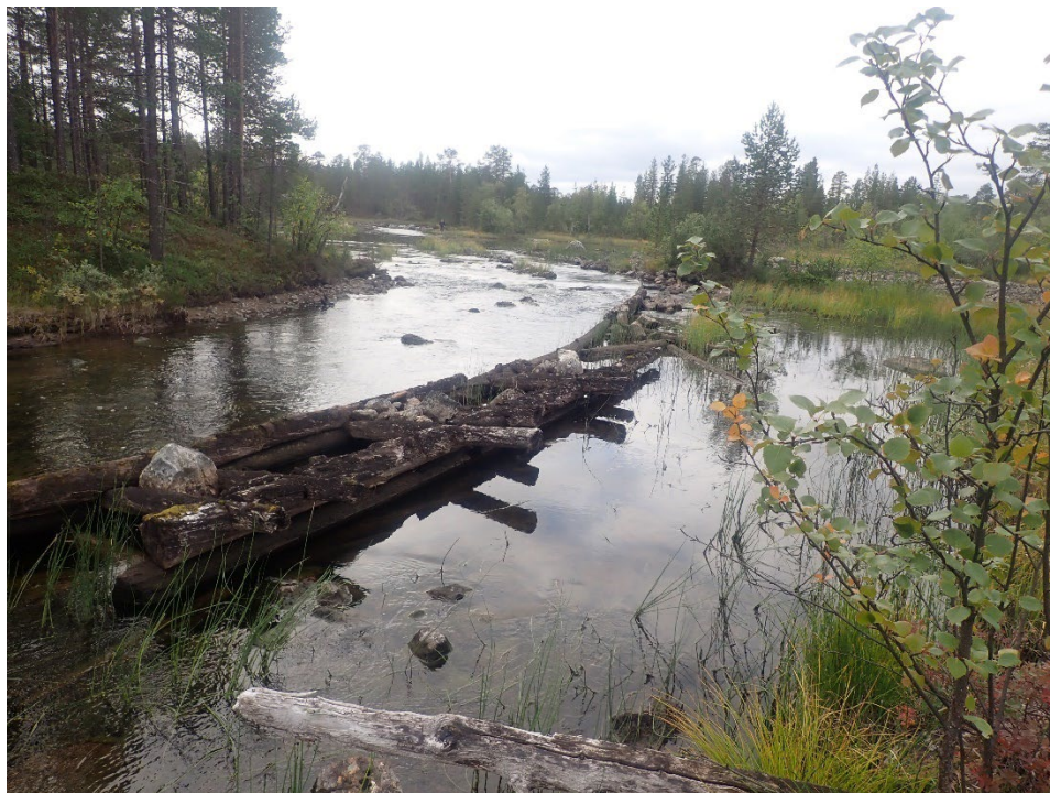
Flere steder ble det observert tømmerrenner i elva.
