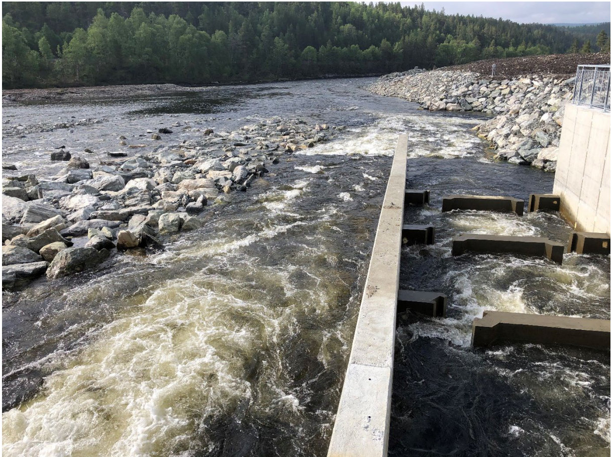
Fiskepassasje forbi Tolga kraftverk. Kombinasjon av dobbeltspaltetrapp (5 m 3 /s) og rampe ved lav vannføring (3 m 3 /s), og over hele terskelbredde ved høy vannføring gir fisken forskjellige muligheter for oppvandring, noe som kan være nødvendig i vassdrag med høy artsdiversitet. Regulant: Hafslund Eco/Opplandskraft, Prosjekterende: Norconsult i samarbeid med NINA Lillehammer. (Foto: Norconsult)
