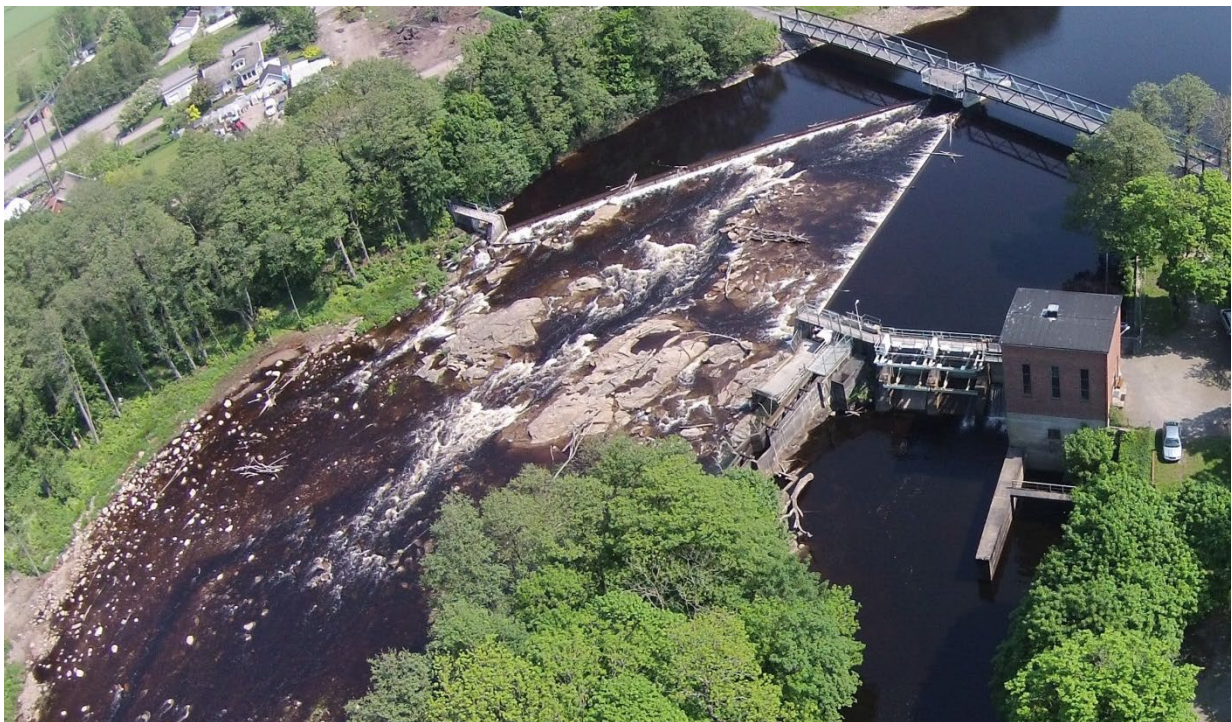
Naturtypisk omløp ved Herting kraftverk i Ätran (Sverige). Omløpet har minst 11 m 3 /s og brukes både til opp og nedvandring av fisk. (Foto: Fiskevårdsteknik AB).
