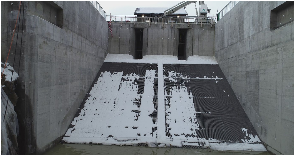
30° alfa-rist med 15 mm lysåpning og 2 fiskeavledere i Tolga kraftverk. Slukeevne kraftverk 60 m 3 /s, avledere 1-3 m 3 /s hver. Regulant: Hafslund Eco/Opplandskraft, Prosjekterende: Norconsult i samarbeid med NINA Lillehammer. (Foto: Lars Bendixby)
