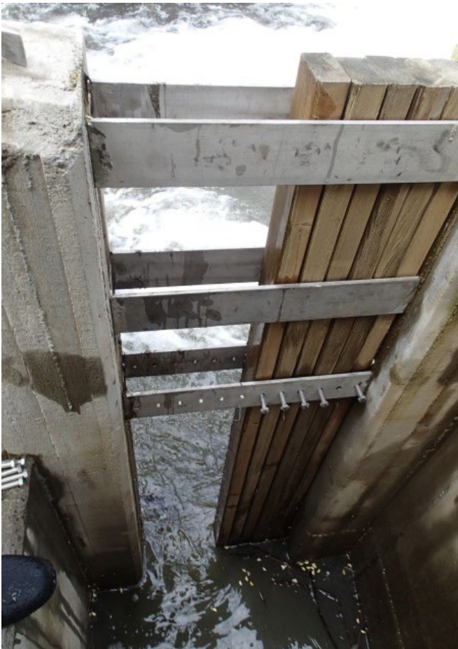
Nålestengsel for finjustering av vannføring inn i omløp
