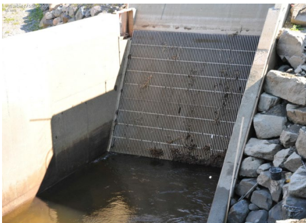
Inntaksvaregrind med fluktåpninger (bilde venstre side, Foto: Frode Kroglund) og skjematisk tegning (høyre)
