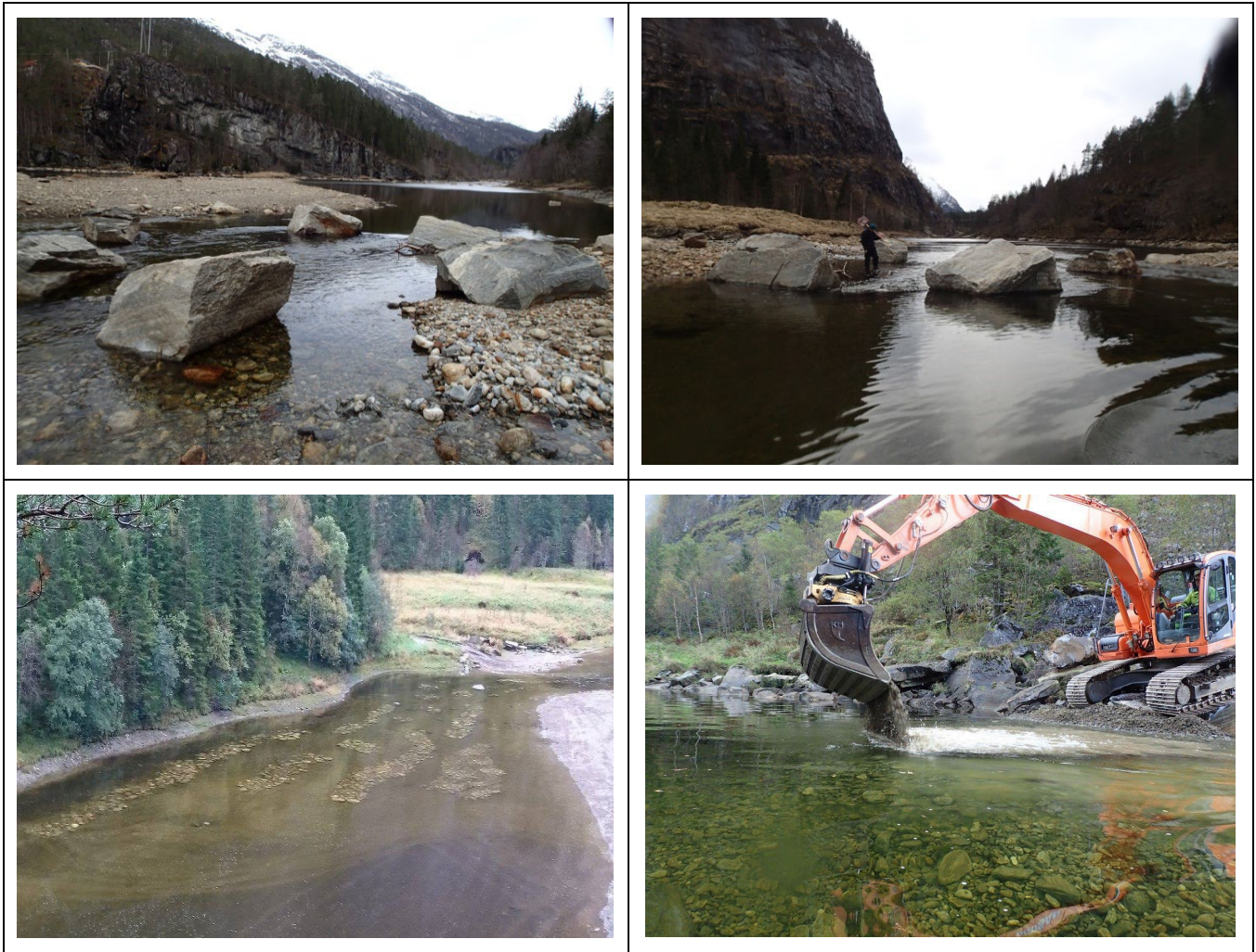
Figur 4. Midt i strekningen var det et smalere sund med egnede forhold for gyting. Noen av de store blokkene ble flyttet for å bedre gytemulighetene på dette området. Steinrekkene ble lagt ut oppstrøms sundet og danner hulrom for ungfisk i et område som bar preg av å være et dårlig oppvekstområde. Disse gir også skjul for voksenfisk. Gytegrus ble lagt ut i det området hvor terskelen lå tidligere og området er i dag egnet for gyting.
