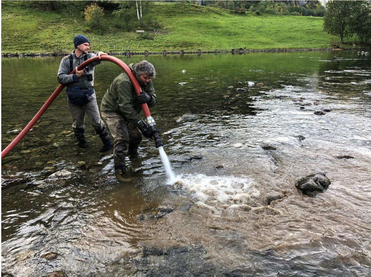
Figur 8. Elvebunnen i regulerte elver har ofte et armeringslag med gov stein i en matriks av fine sedimenter på elvebunnen. I Aurlandselva er det utført forsøk med å spyle ut finsedimentene manuelt. Foto: G. Velle.
