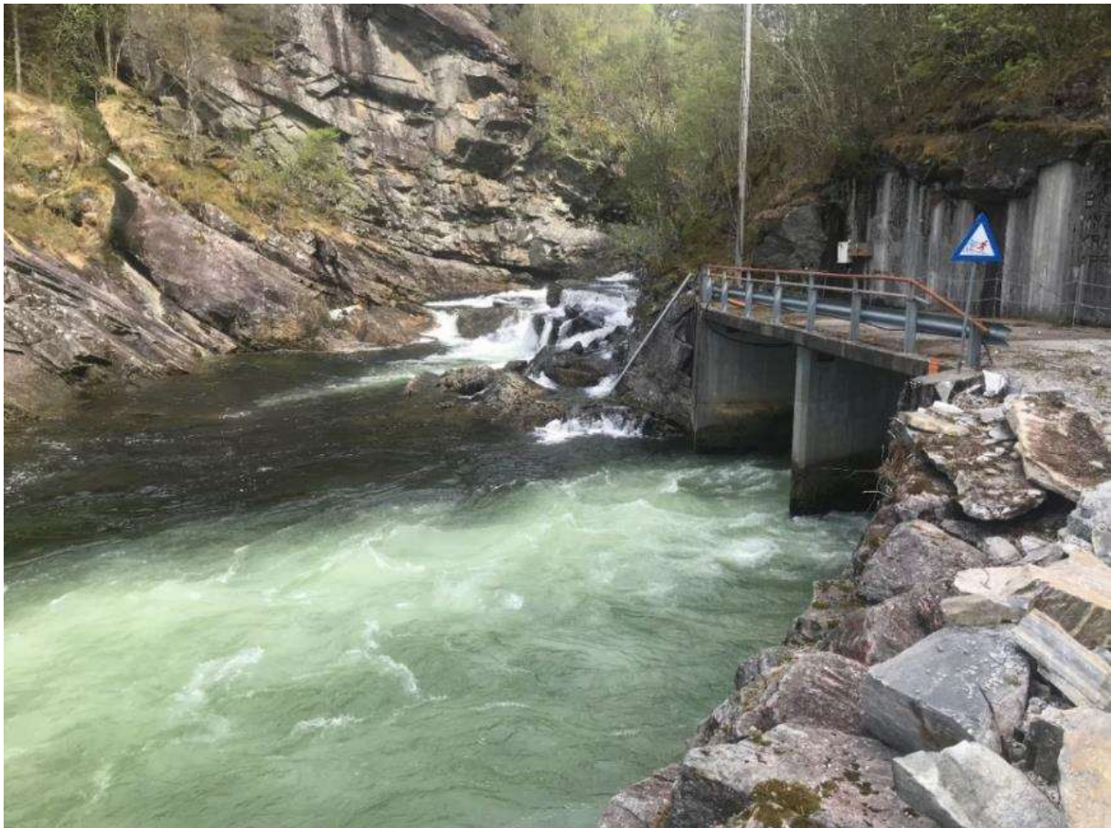
Figur 11. Gassovermettet vann fra utløpet av et kraftverk i Ekso i Eksingedalen får blakket vann når bobler felles ut av vannet. Vann fra restfeltet er ikke blakket eller overmettet med gass. Foto: Eirik Straume Normann.
