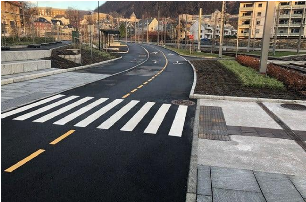
Figur 7 Sykkelstamvegen Kilde: Statens Vegvesen
