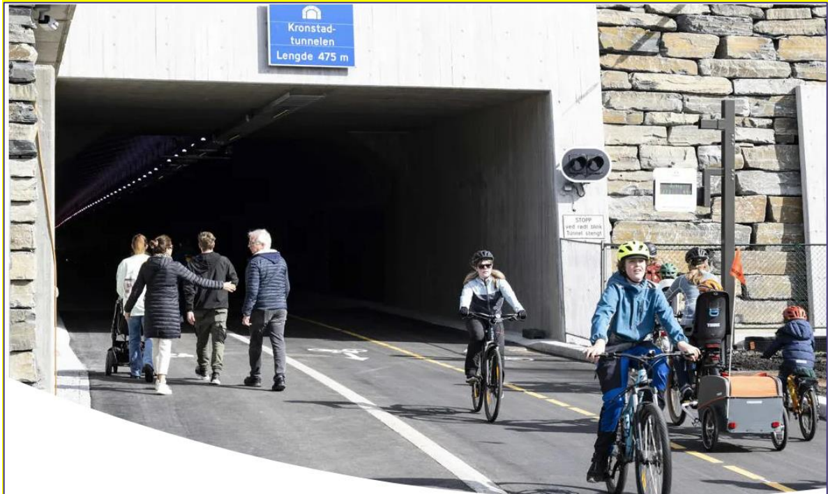
Figur 6 Sykkelvegen – Kronstad-tunnelen Kilde: Statens Vegvesen
