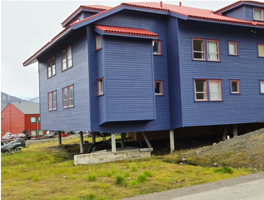
Bilde 5 Bolig fundamentert på pæler
