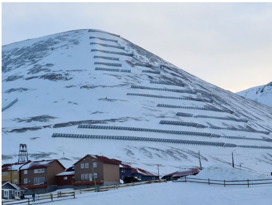
Bilde 1 Skredsikring, støtteforbygning i Sukkertoppen.
