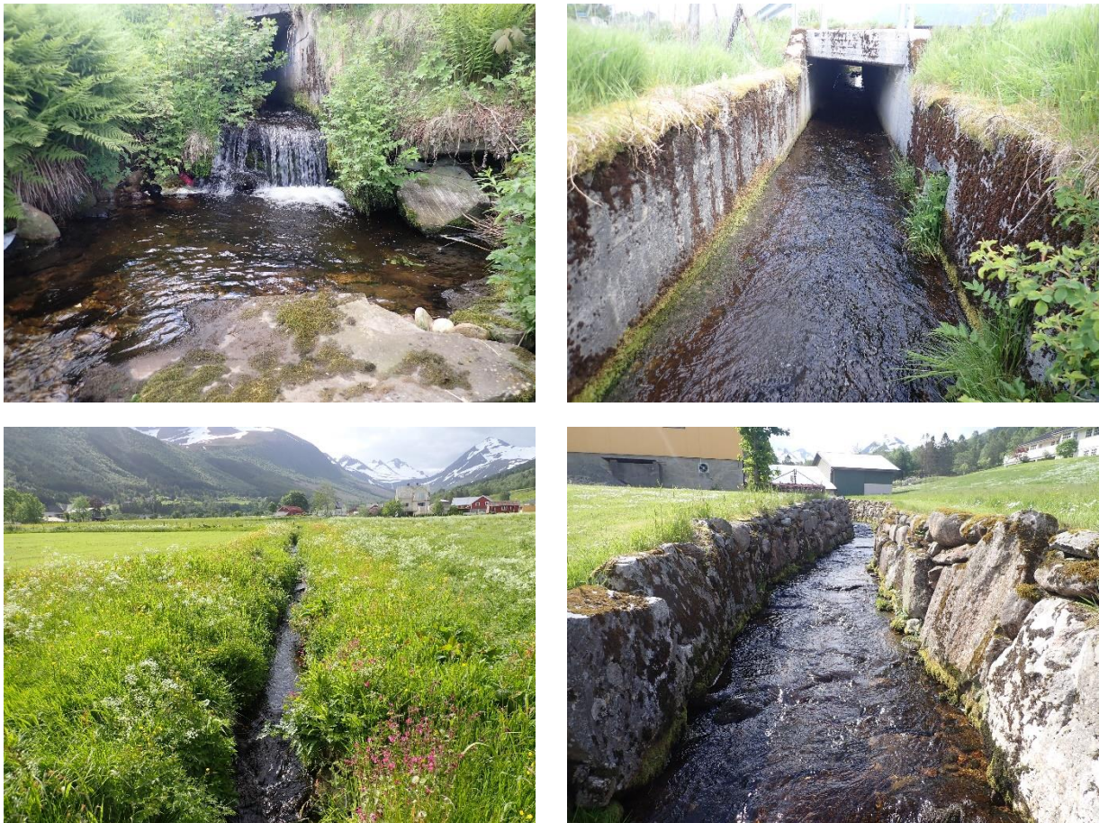
Figur 8. Kokelva. Kulvert under E39 sett nedenfra (oppe t.v.), betongrenne mellom de to nederste kulvertene (oppe t.h.), gyteområde uten kantvegetasjon (nede t.v.) og kanalisert parti med bunnplastring av flat stein (nede t.h.).
