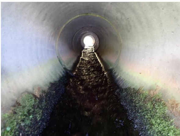
Figur 19. Gyteområde med høy fisketetthet i nedre del av Ljoselva (oppe t.v.), grøftpreget parti mellom de to lange rørene (oppe t.h.), 17 m langt rør hvor det anbefales å montere fleksiterskler eller å fjerne røret (nede t.v.) og bratt kanalisering i øvre del av bekken (nede t.h.).
