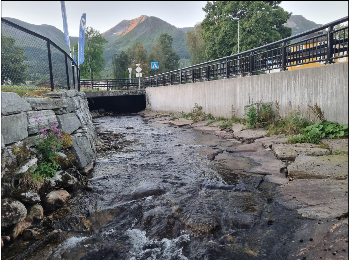
Figur 30. Bunnplastring like nedstrøms samløp mellom Vikelva og Skytjeåa.
