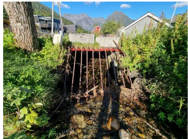
Figur 92. Kunstig permanent vandringshinder i øvre del (oppe t.v.), forbygd og kanalisert strekning (oppe t.h.), forbygd og bunnplastret strekning helt nederst (nede t.v.) og kulvert som dekker 80 m i nedre del av Strupen (nede t.h.).
