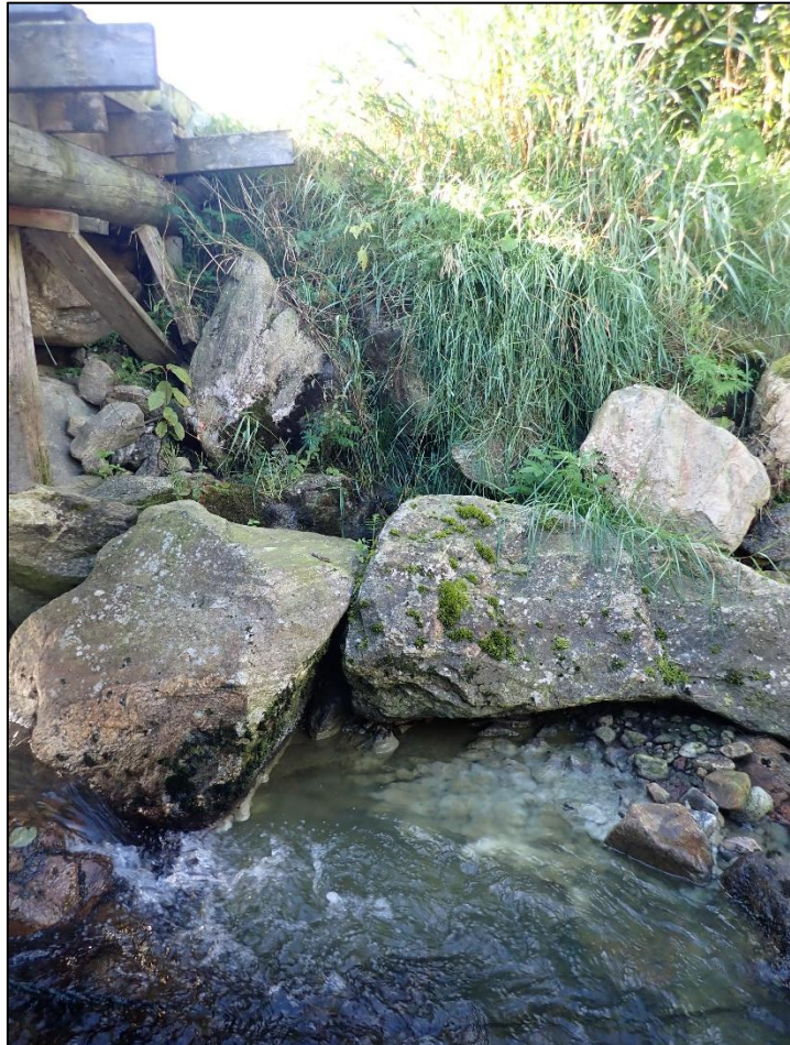
Figur 48. Utslippspunkt ved trebro over Kliåa. Fra dette punktet og nedstrøms var det svært mye lammehaler i elven.
