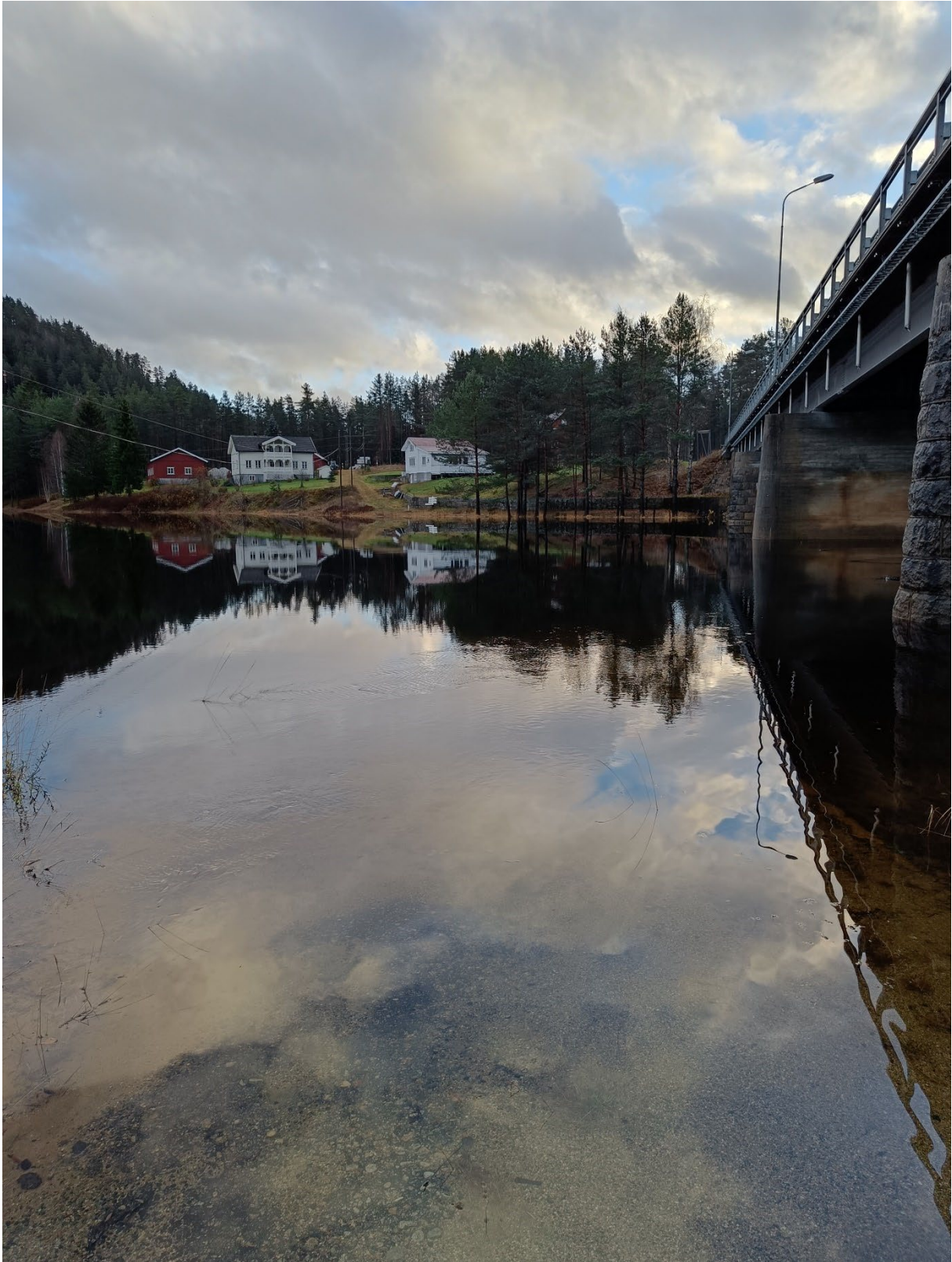
Stasjon N08. Haugsjåsund bro
