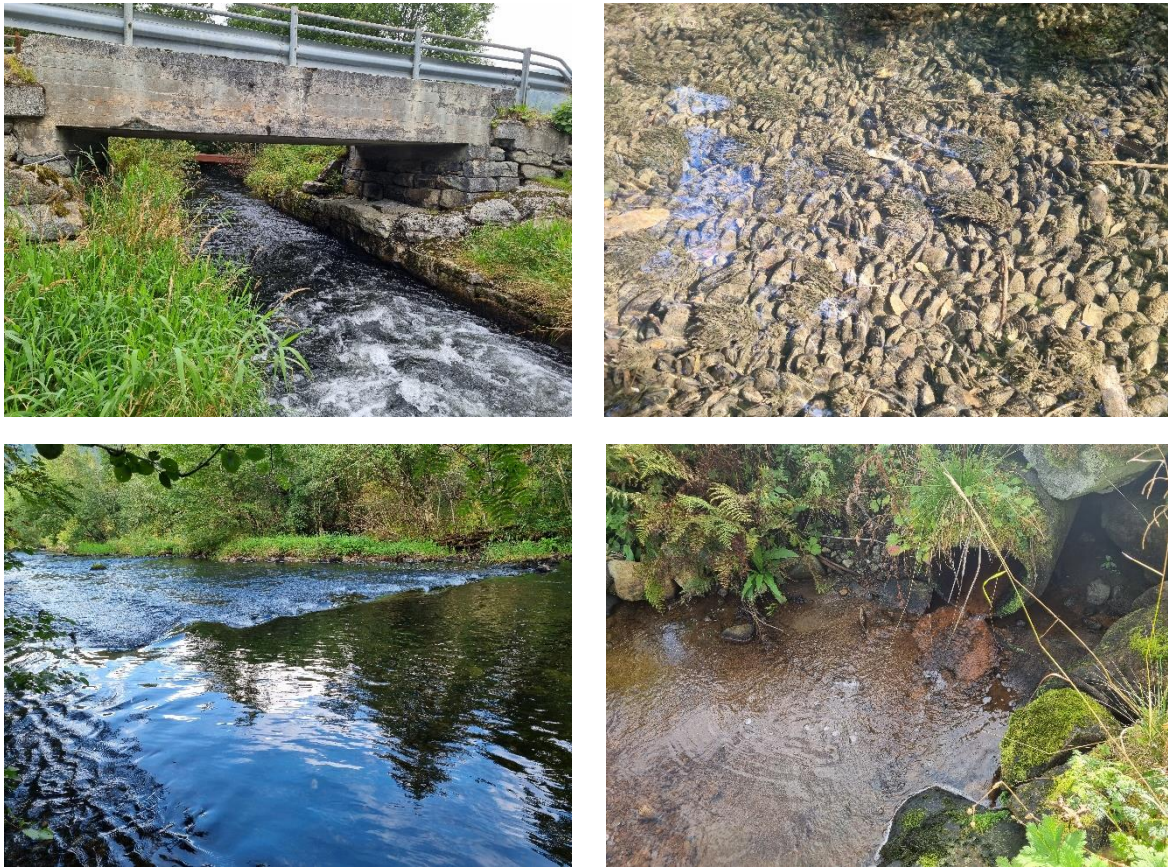
Figur 18. Kanalisert elveløp ved utløpet av Vatnevatnet (oppe t.v.), elvemusling i et sideløp (oppe t.h.), terskel i nedre del (nede t.v.) og utløpet til sideelv som er rørlagt (nede t.v. og nede t.h.).
