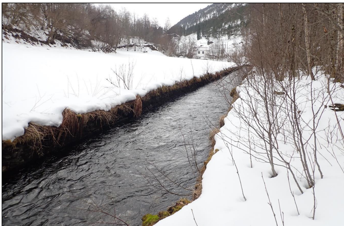
Figur 19.3. Utløpskanalen fra Kolfossen kraftverk. Bildet er tatt i april 2021.
