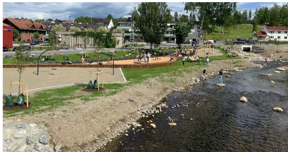
Utvidelse av elva til flomsikring med flomsone brukt som elvepark i Brandbu/Gran kommune (Foto: Gran kommune) 5
