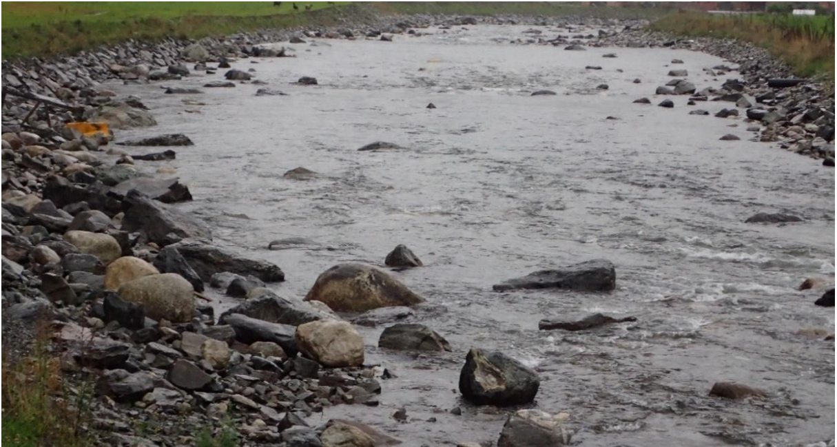
Figur 22. Tradisjonell erosjonssikring med glatt plastring (øvre bilde) og tilbaketrukket erosjonssikring med mer naturtypiske elvebredder (nedre bilde Flåm 2017).
