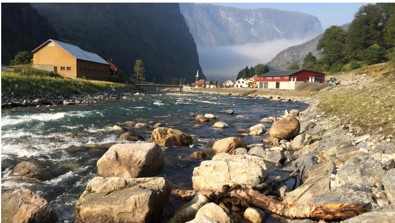
Figur 24. Flåmselvi ovenfor Flåm kirke. Bosetting krever erosjonssikring med stabil plastring langs yttersvingen. Foran plastringfoten ble det etablert en variert elvebredd med naturtypiske steinblokker og rullestein som gir habitat for fisk og sikrer plastringfoten ytterligere mot erosjon.
