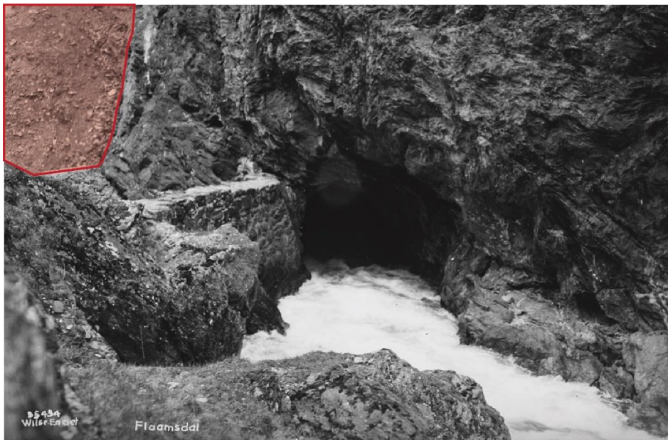
Figur 57. Tunnel for elven forbi Flåmsbanen ved Holten, ca. 1940. Bildet tyder på at jernbanedammen kan bestå av løsmasser. Kilde: nasjonalbibliothek/public domain
