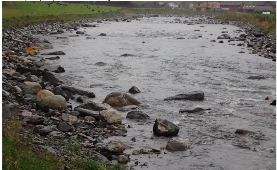
Steinutlegg foran plastring i Flåmselva før etablering av kantvegetasjon
