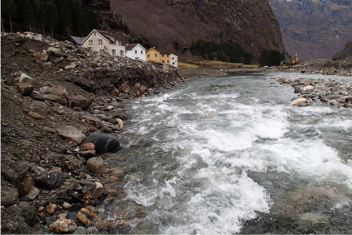
Figur 14. Erosjon etter 2014-flommen i Flåmselva nedenfor Flåm bro. Erosjon og morfodynamikk forårsaket skadene (Bilde: Tore Wiers).
