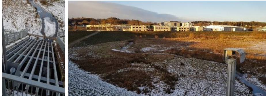
Eksempel fordrøyningsbasseng og spalteformet utløp i Raaba/Østerrrike ved normal vannføring.
