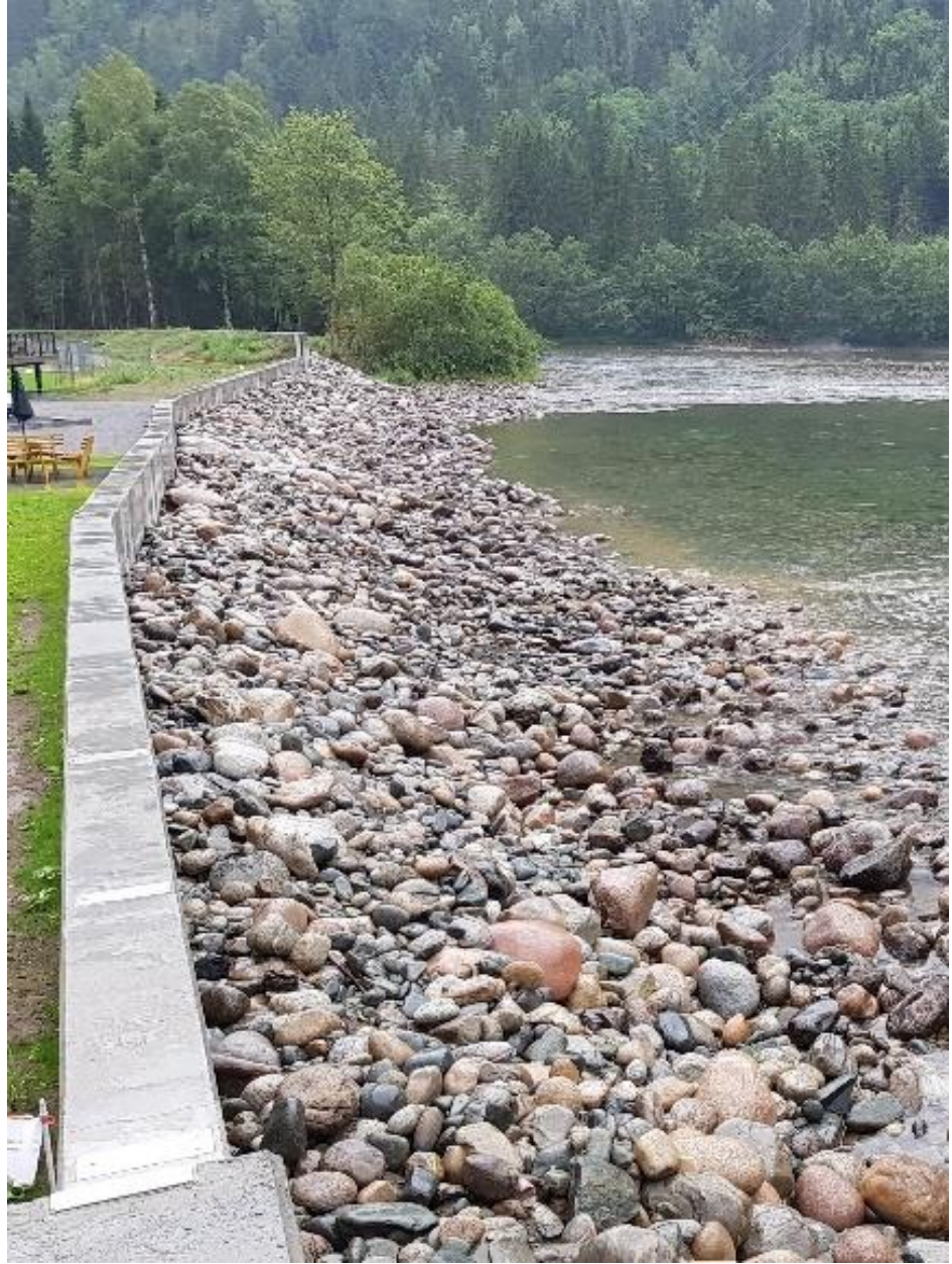
Flommur med mulighet for mobil påbygging av ekstra elementer før flommer (Dalen i Tokke kommune)
