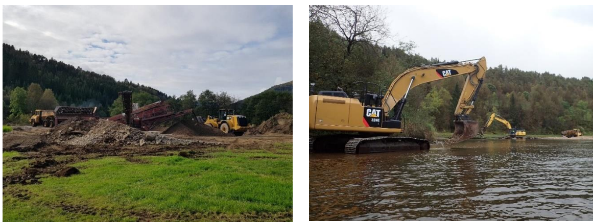
Figur 123. Bilder tatt under arbeidet. Venstre: Utgravde masser siktes i mobilt sikteanlegg. Høyre: Maskiner graver ut finsedimenter og legger tilbake ferdig siktede sedimenter.
