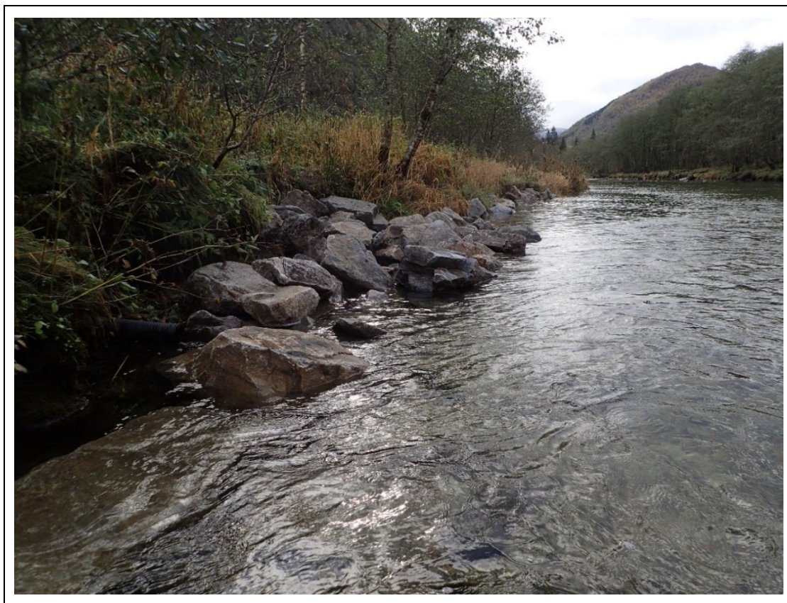
Blokker i elvekant for å danne skjul for fisk.
