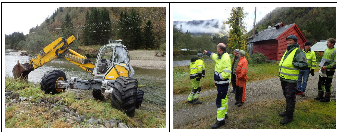
Menzi muck (venstre) ble benyttet til deler av utlegging av stein og blokk grunnet mye vann. En gjennomgang med grunneiere under gjennomføringen av tiltakene var viktig.
