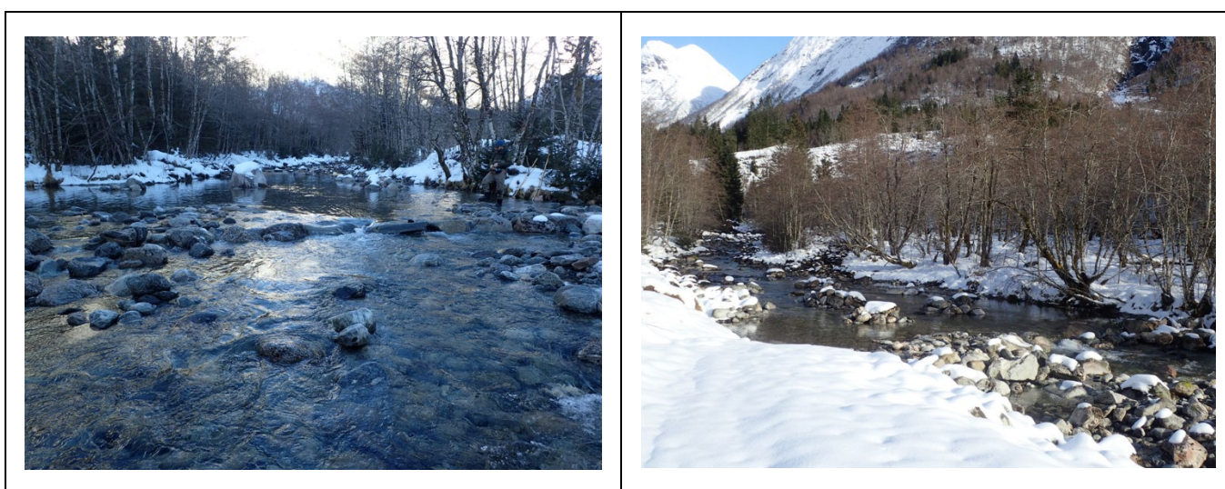
Figur 13. For å sikre den utlagte gytegrusen mot utspyling ble det lagt ut store steiner i området nedenfor gytegrusen. Det ble i tillegg laget en lavvannsrenne for å sikre god vanngjennomstrømning og vandringsmuligheter ved lav til middels vannføring. I tillegg ble det lagt ut steiner og blokker for å stabilisere gytegrusen og for å øke den hydromorfologiske variasjonen i det etablerte dypområdet.
