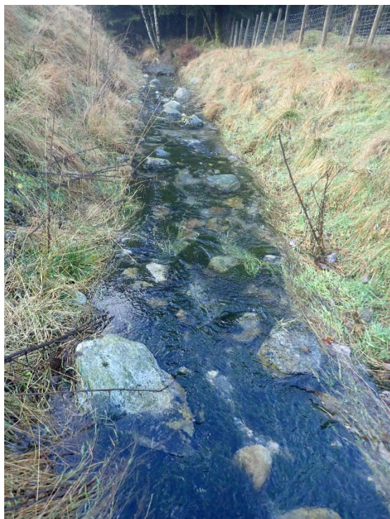
I den øvre delen av Rabbagrovi er bunnen rensket opp og det er lagt ut grus og steiner (venstre bilde). Det er mulig å forlenge dette tiltaket videre opp i Rabbagrovi (høyre bilde).
