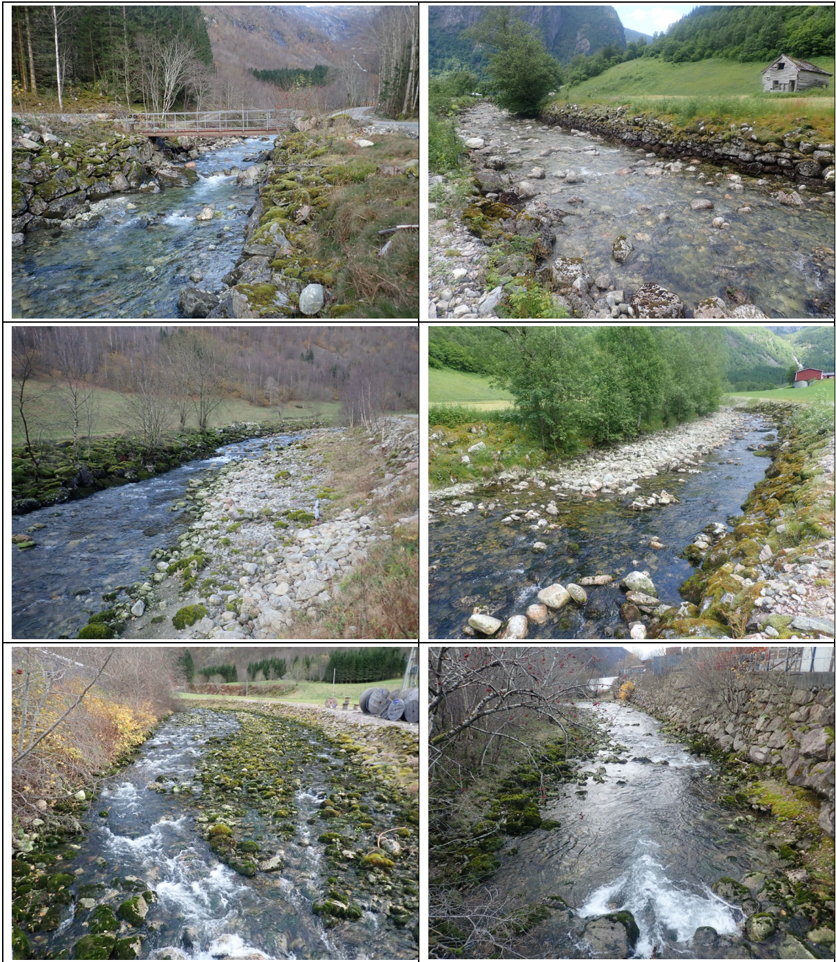
Figur 7. Strekning fra gangbro til utløp av Østerbøelva. Øverst ser en gangbro med terskelkulp og strekningen nedstrøms som er bred, men vanddekket og med en slags cellestruktur. Bilder i midten viser deler av strekningen hvor det er aktuelt å etablere noen celleterskler og enkeltkulper, nede til venstre vises breitt parti med stabil bunn hvor det er mulig å etablere kulp. Nederst til høyre er det bilde av to terskler som allerede er etablert, og som fungerer hensiktsmessig.
