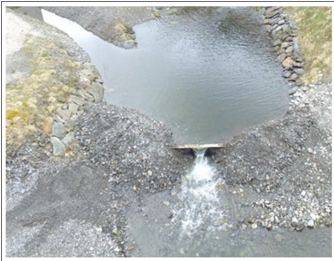
Provisorisk dam nedstrøms Dam Refsdal og terskel i dammen for å kunne justere vannføringen i restfeltet i Vikja ved kartleggingen med drone.
