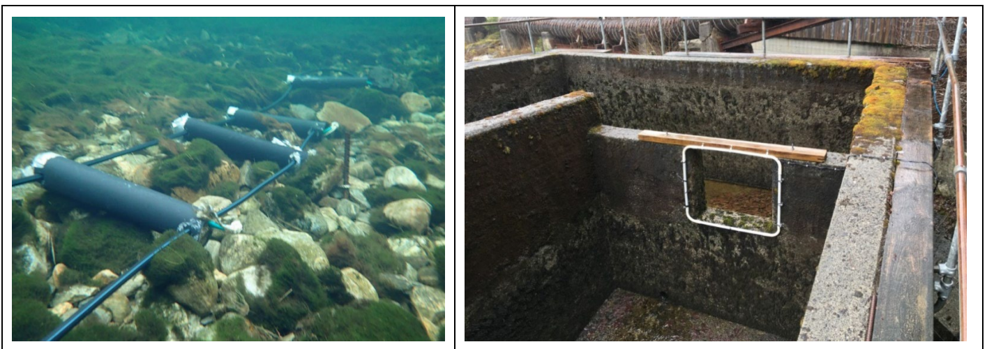
Venstre bilde viser bunnantenne ved Modalstunellen. Høyre bilde viser antenne montert rundt åpningen i fisketrappen ved Hellandsfoss som registrerer PIT-merkede fisk som svømmer opp og ned trappen.
