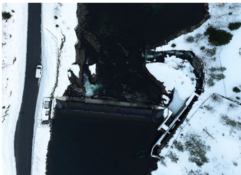
Gummidammen og fisketrappen ved Almelid. Vannføringen i restfeltet styres via et inntak i gummidammen.
