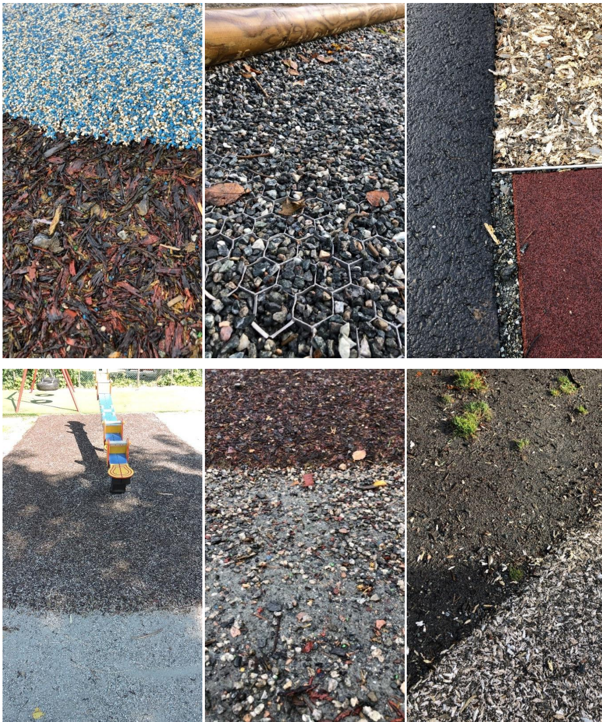
Figur 3.9. Eksempler på fallunderlag. Fra øverst fra venstre: Gummibark; gressarmering; asfalt, gummibark og gummi heller sammen; nederst: sand og grus inntil fallunderlag med slitasje og synlig spredning av gummibark og playtop underlag. Foto: NORCE
