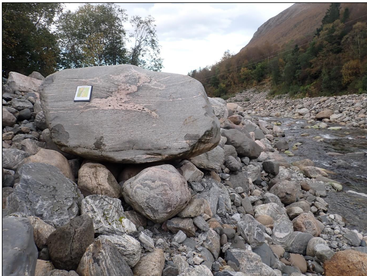
Figur 15. Eksempel på løse voller av usortert stein, inkludert store steinblokker, som ble gravd ut av elveløpet etter flommen i 2016. Bildet er tatt ca. 200 m nedstrøms Erdal bru.
