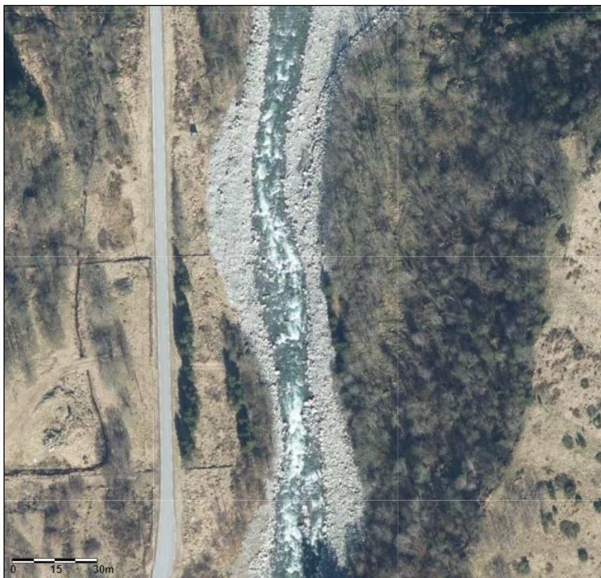
Figur 6. Eksempel på gravearbeidet som ble gjort etter 2016-flommen, like oppstrøms Tverrelva. En smal dypål er gravd ut, og de utgravde massene lagt som høye voller langs elvebreddene. Flyfoto fra 2019 hentet fra norgebilder.no .
