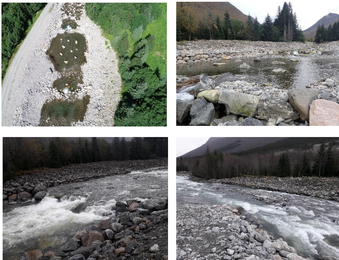
Figur 12. Gyteområde ved Erdal bru, etablert av elveeierlaget sommeren 2020. De øverste bildene viser situasjonen 12. juli (venstre) og 1. oktober (høyre) 2021. Nede til venstre: Bilde tatt 15. oktober 2021, dagen etter at en flom ødela terskelen og fylte mye av gyteområdet med grus. Dette ble raskt utbedret, men en ny flom i januar 2022 fylte på nytt gyteområdet med løsmasser (nede til høyre). De to nederste bildene er tatt av Idar Barstad.
