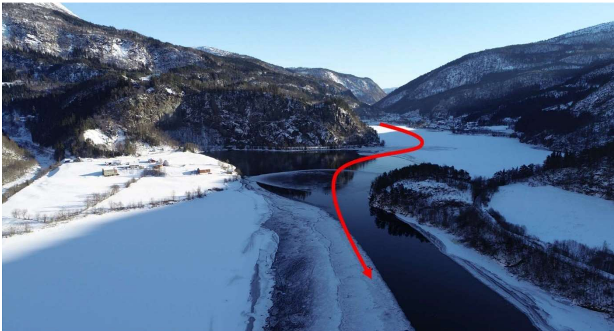
Figur 3. 10. Bilde av utløpet av kraftverket vinteren 2021. Her kan man enkelt se at overflatevannet fra kraftverket påvirker temperaturen og dermed islegging av vannet rundt kraftverket og ved Fadenes. Rød pil viser hvordan laksesmolten må passere influensområdet til kraftverket. Hentet fra Vollset m.fl. 2021b.
