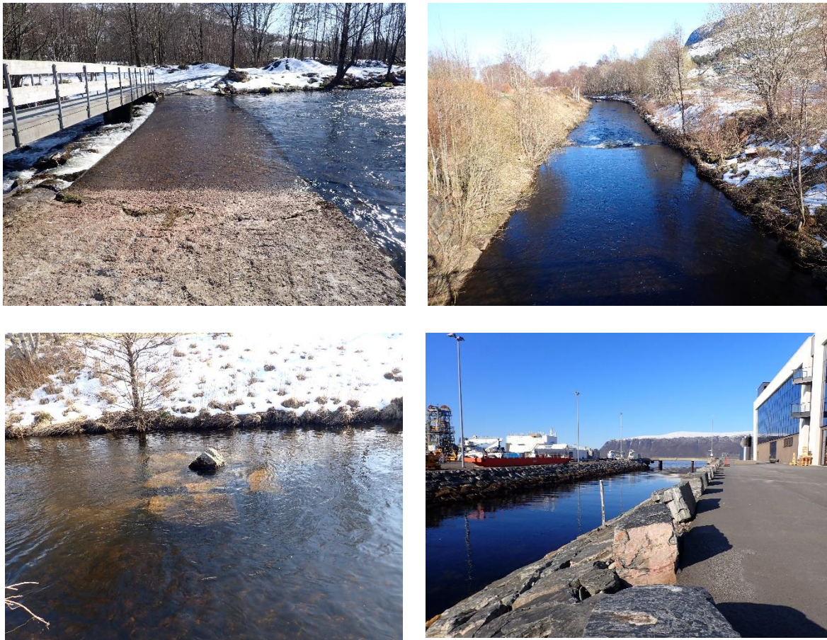
Figur 11. Betongterskel øverst i Hareidselva (oppe t.v.), kanalisert strekning i midtre del av Hareidselva (oppe t.h.), steingruppe som habitatforbedrende tiltak (nede t.v.) og utosen til Hareidselva i industriområde (nede t.h.).
