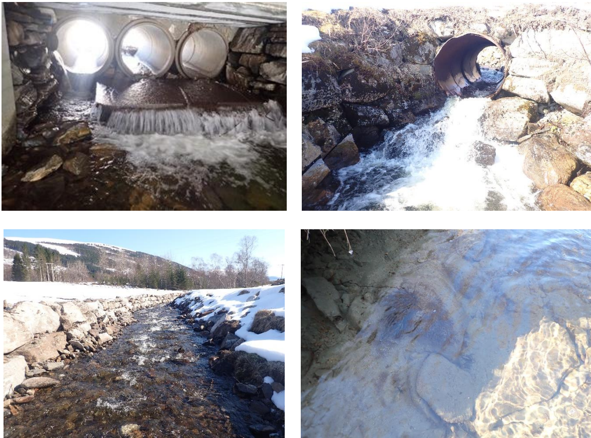
Figur 25. Kunstig temporært vandringshinder i Riseelva under vei (oppe t.v.) og kunstig temporært vandringshinder i Dyfteelva (oppe t.h.). Nyetablert forbygning langs Dyfteelva på Øvre Rise (nede t.v.) og finsedimenter i elvebunnen nedstrøms samme forbygning (nede t.h.).
