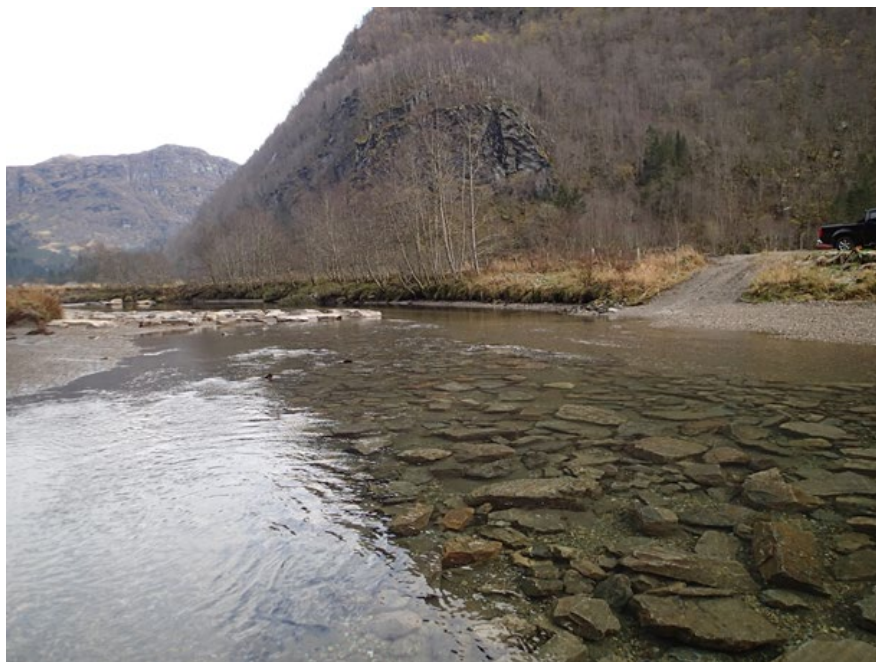
Blokker festet i elvebunnen samt ledebune/strømsetter øverst i bildet med gyteområde i glattstrømmen til høyre for ledebunen.
