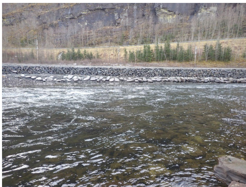
Forbygning langsmed elvekanten for å sikre jernbanen.
