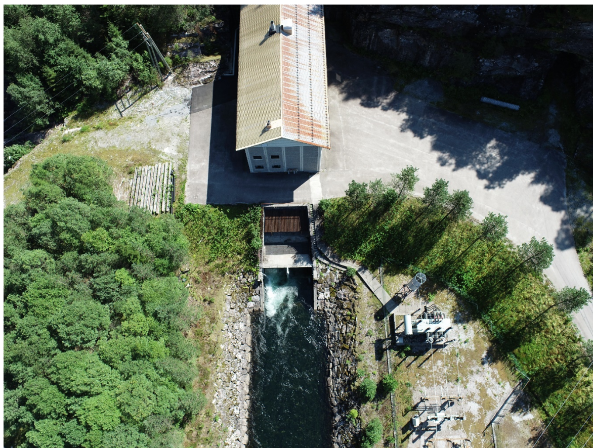
Hellandsfoss kraftverk (BKK) sitt utløp.
