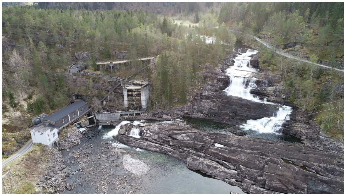
Hellandsfossen med Modalen kraftverk og fisketrappen
