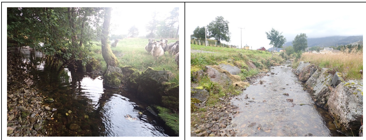
Venstre: Fint eksempel på at heterogen steinsetting og trær fungerer som erosjonssikring. Dette gir bedre elvemiljø enn vertikale forbygninger. Høyre: Kanalisering og manglende kantvegetasjon langs det største gyteområdet i sideelven Kvernhuselva.
