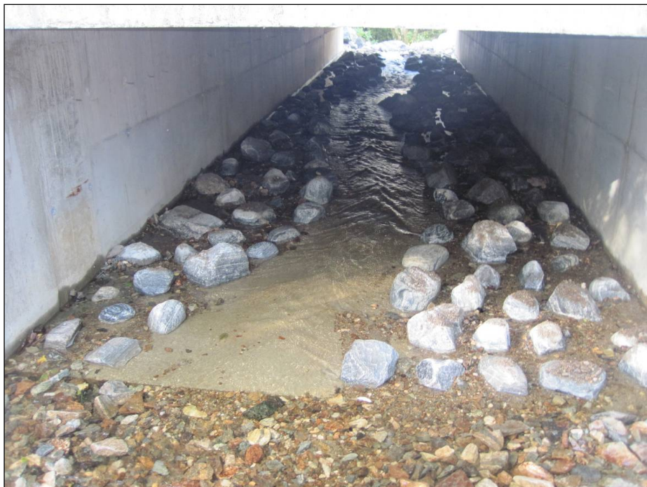
Figur 7. Bildet viser ny kulvert etablert i Apeltunvassdraget som ble sanert av Bergen kommune og som nå er passerbar for fisk igjen. Dette er et eksempel på et enkelt tiltak i kulvert med betongbunn. Etablering av strukturer, i dette tilfelle som steiner og dypvannsrenne, kan være nok for å sikre vandringsveien for fisk. Andre strukturer kan være ledebuner og terskler med lavvannsrenne.
