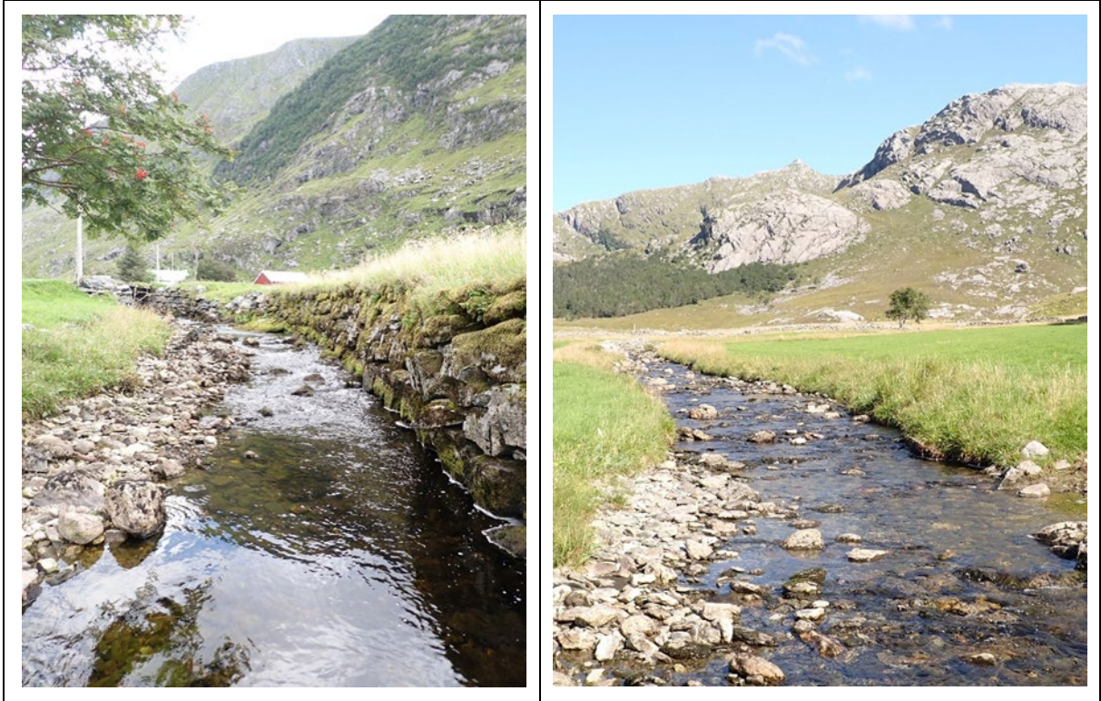
Forbygning bakkemur (t.v) og skjult forbygning under gressbanker (t.h) i Dalevassdraget. Bildene illustrerer også mangel på kantvegetasjon langs vassdraget.
