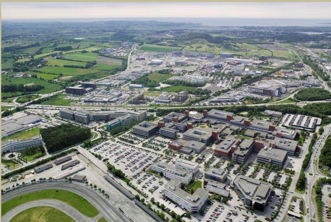
Forus ligger på begge sidene av motorveien Stavanger-Sandnes og kan deles i fire deler (nordvest, nordøst, sørvest og sørøst), bildet viser deler av Forus sørøst og sørvest med Statoils hovedbygg midt i bildet. Bilde: Forus næringspark AS
