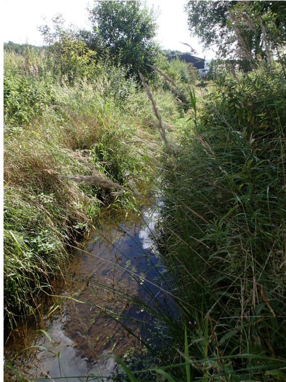
Oversiktsbilde fra stasjonen i Foruskanalen Vest.
