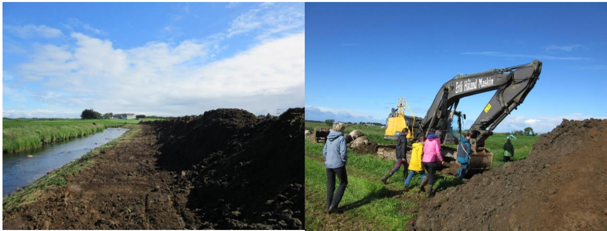
Figur 8.5. Fra mudringsprosjektet i Håelva. Jordvullen langs kanten stammer antakelig fra utvidelsen av vassdraget, siden selve mudringen egentlig var såkalt ripping, uten å ta opp massene, men isteden skal de «løses» og transporteres videre nedover vassdraget. Foto: Eva Skarbøvik.
