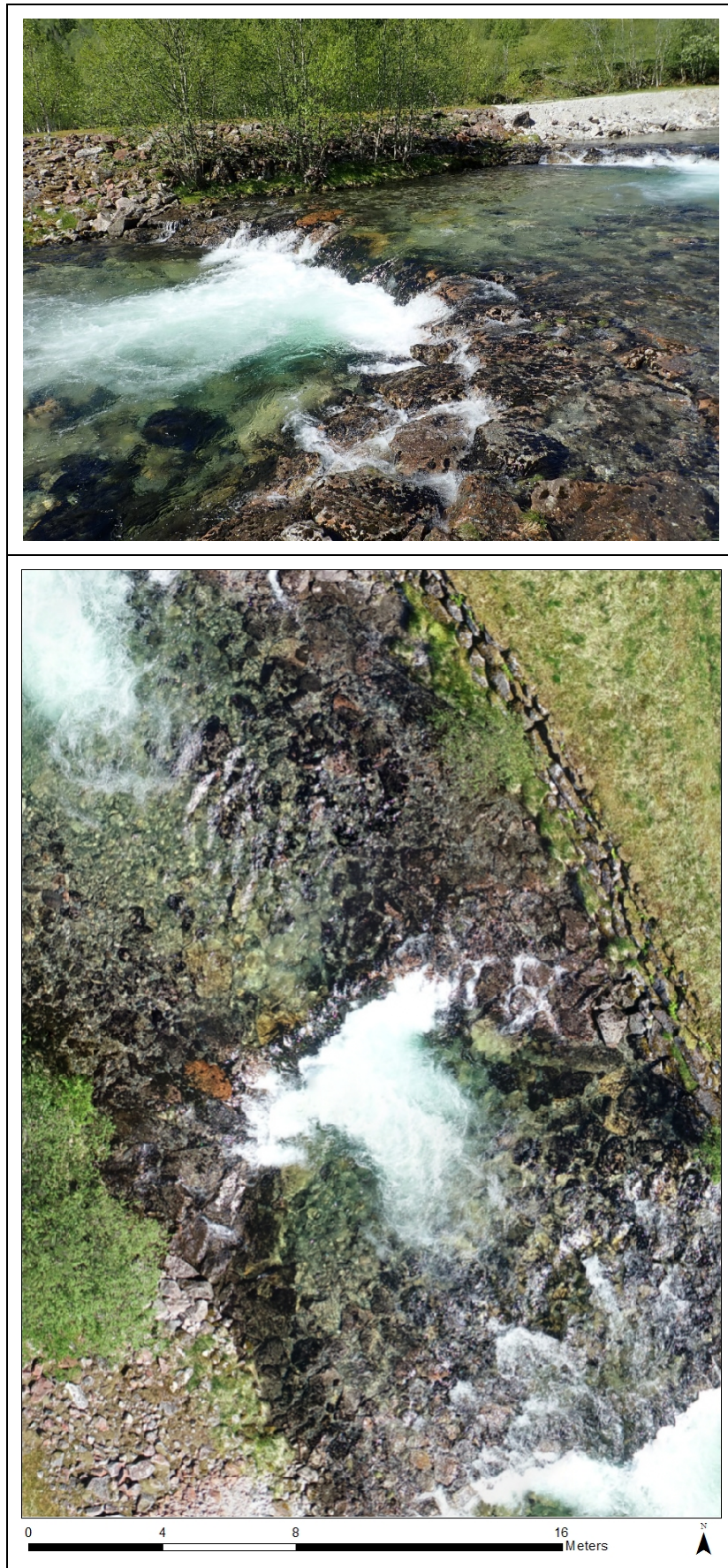
Figur 18. Terskel 19 bør få en dypere lavvannsrenne i midten.
