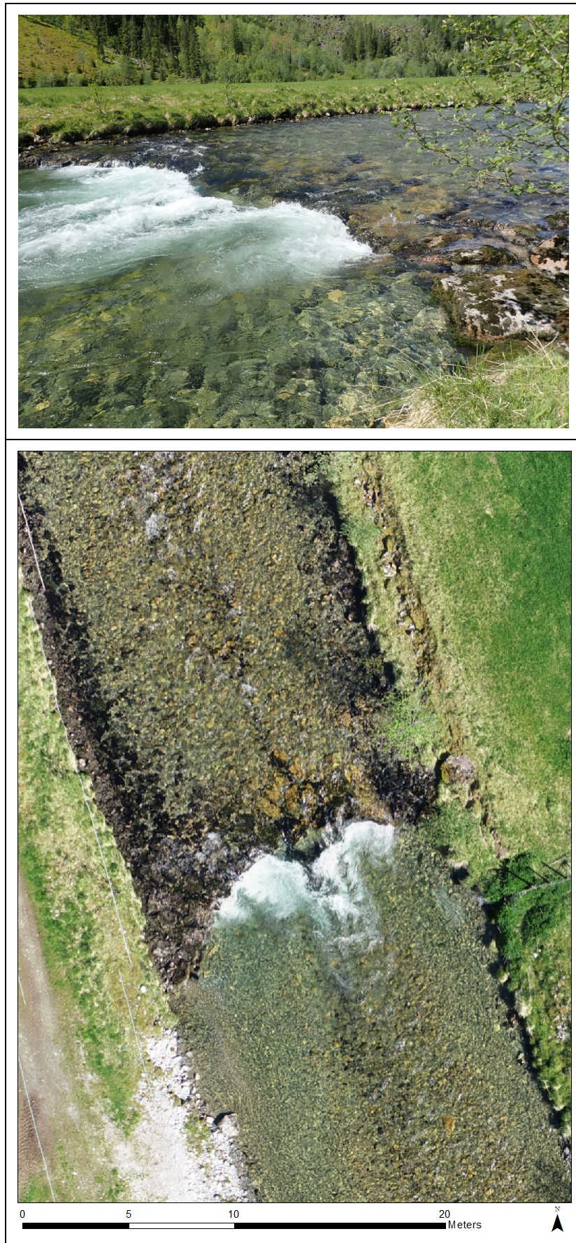
Figur 12. Terskel 13 bør løses helt opp og det bør legges ut flere blokkgrupper nedstrøms terskelen.
