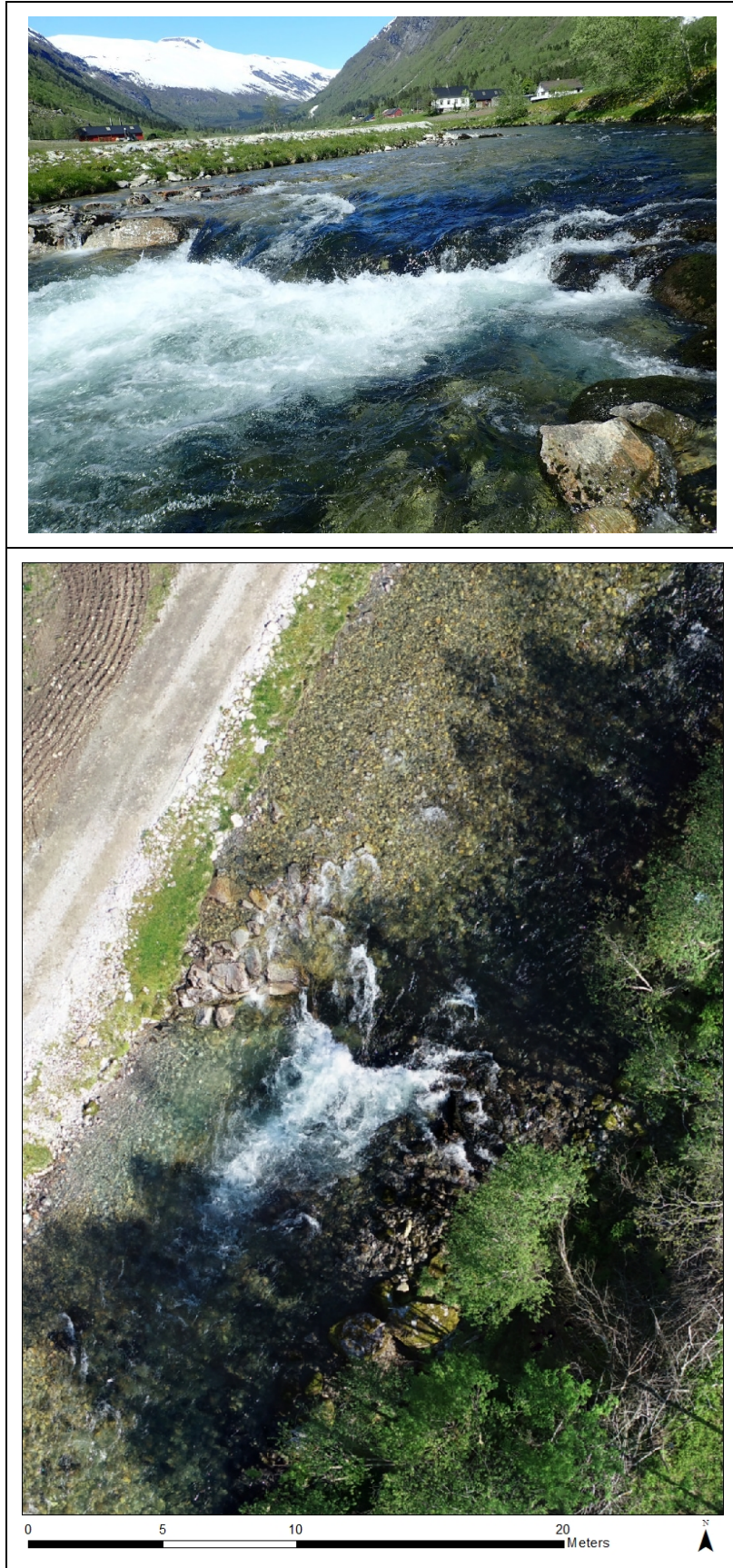
Figur 5. Terskel 6 bør løses helt opp og det bør legges ut flere blokkgrupper nedstrøms terskelen. To, tre blokker i østre elvekant kan være igjen som ledebune.
