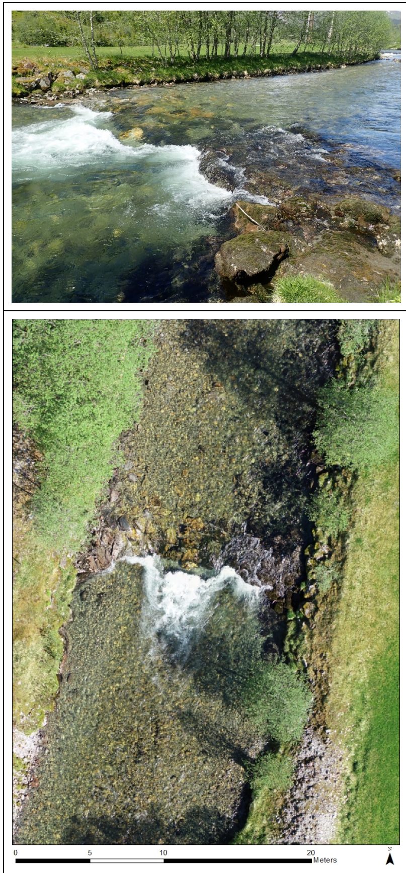
Figur 10. Terskel 11 bør løses helt opp og det bør legges ut flere blokkgrupper nedstrøms terskelen. To, tre blokker i østre elvekant kan være igjen som en ledebune.
