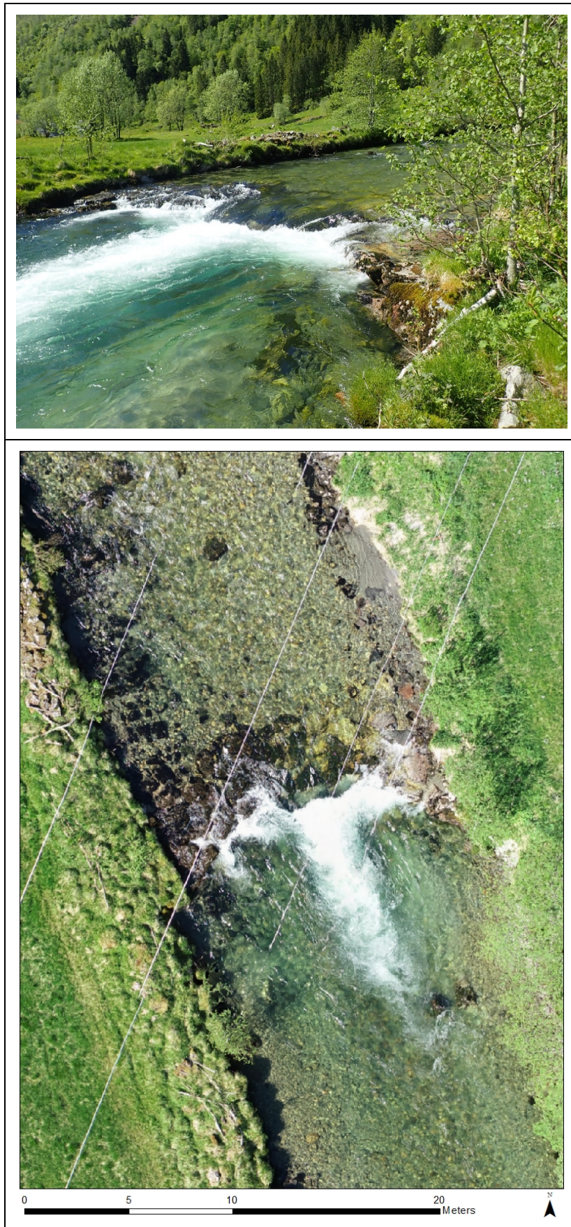
Figur 3. Terskel 4 bør få en dypere lavvannsrenne i midten og det bør legges ut flere blokkgrupper nedstrøms terskelen for å dempe vannhastigheten.
