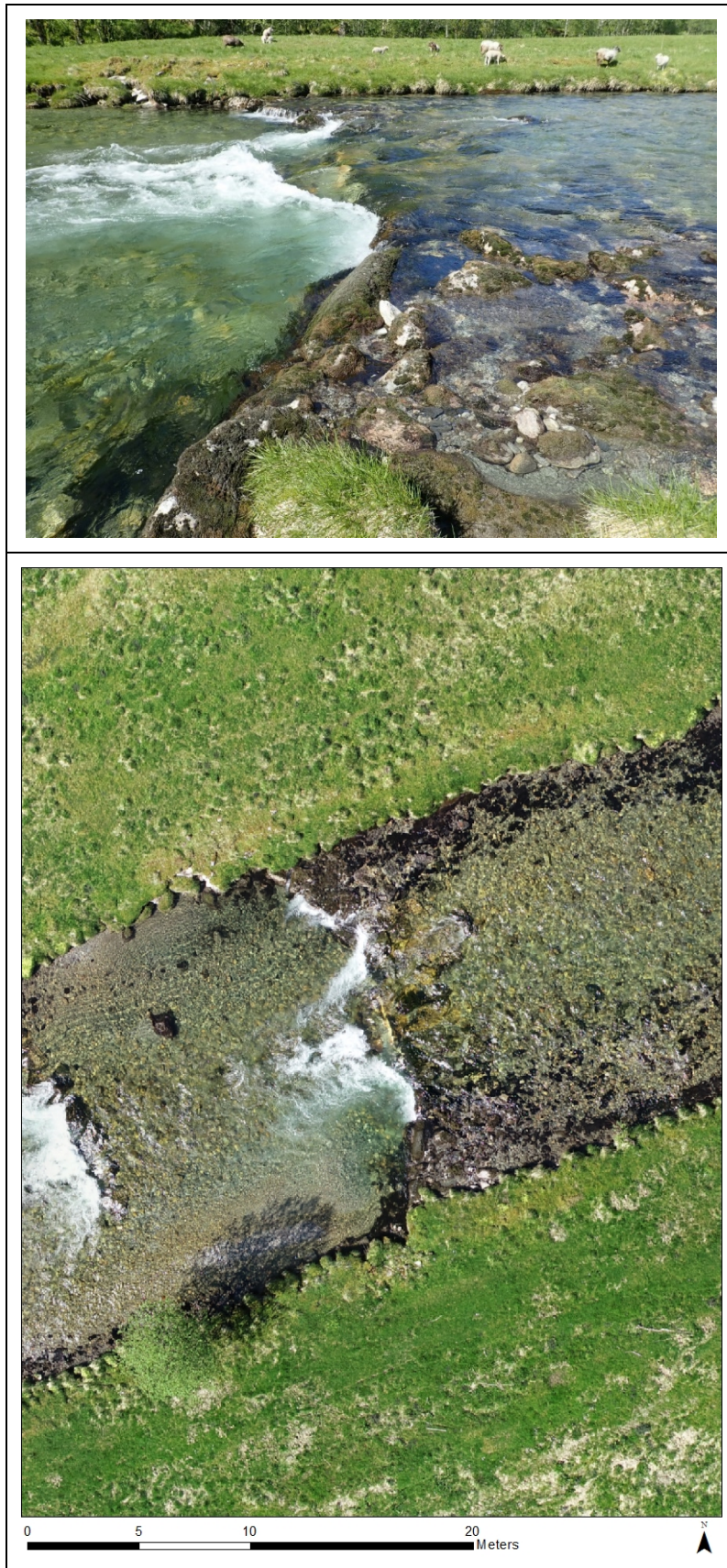
Figur 4. Terskel 5 bør løses helt opp og blokkene brukes til å etablere blokkgrupper og enkeltstående blokker for å dempe vannhastigheten. To, tre blokker i sørlige elvekant kan være igjen som ledebune.
