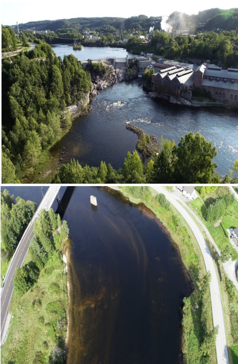
Otra med vandringshinder ved kraftstasjonen og flatere parti nedstrøms fylkesveibrua ved Oksåsen med tydelige gytegroper i elvebunnen.
