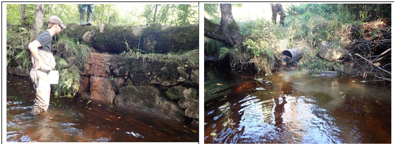
Figur 43. Utslipp i Høiebekken. Venstre: I øvre halvdel av bekken ble det observert to steder hvor det sivet ut vann med ukjent innhold. Høyre: Like oppstrøms jernbanebroen kom det ut vann fra en nærliggende byggeplass som innehold store mengder grå finsedimenter som dannet en haug like nedstrøms røret.
