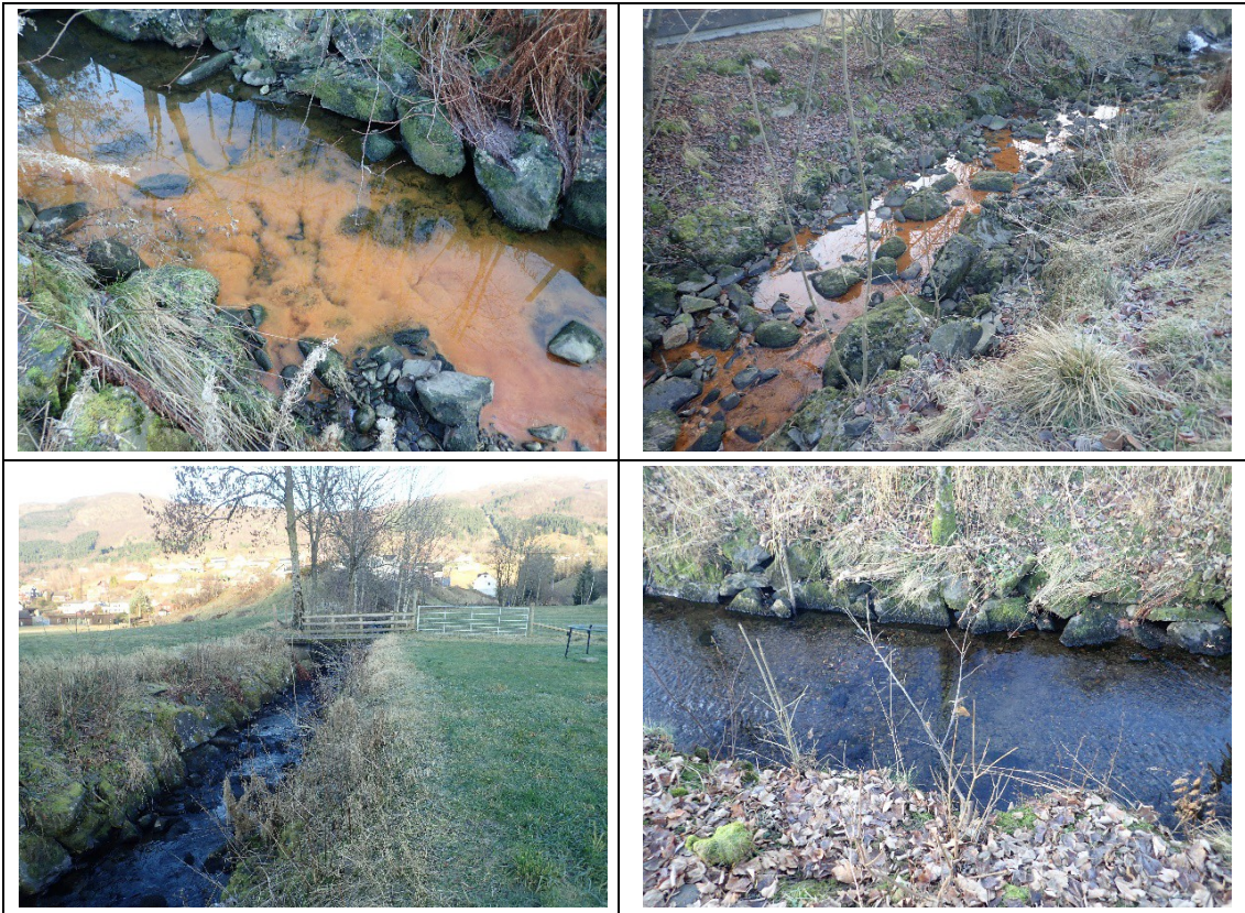
Figur 33. Eksempelbilder av inngrep i Prestabekken. Øverst: Utslippspunktet hvor det siver ut et oransjebrunt materiale som brer seg nedover bekken. Nederst: Utrettete partier med fjernet/reduert kantvegetasjon og erosjonssikring.
