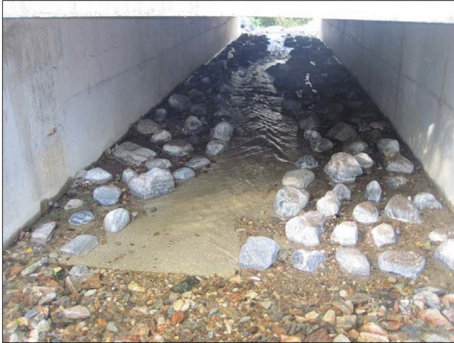
Figur 71. Bildet viser ny kulvert etablert i Apeltunvassdraget som ble sanert av Bergen kommune og som nå er passerbar for fisk igjen. Dette er et eksempel på et enkelt tiltak i kulvert med betongbunn. Etablering av strukturer, i dette tilfelle som steiner og dypvannsrenne, kan være nok for å sikre vandringsveien for fisk. Andre strukturer kan være ledebuner og terskler med lavvannsrenne.
