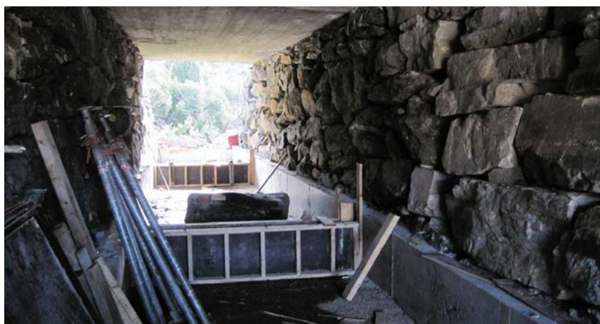
Figur 69. Bildet fra bygging av ny veikulvert ved en bekk i Sotra, Hordaland våren 2010. Her støpes det tverrvegg for å lette oppvandringsen for fisk.
