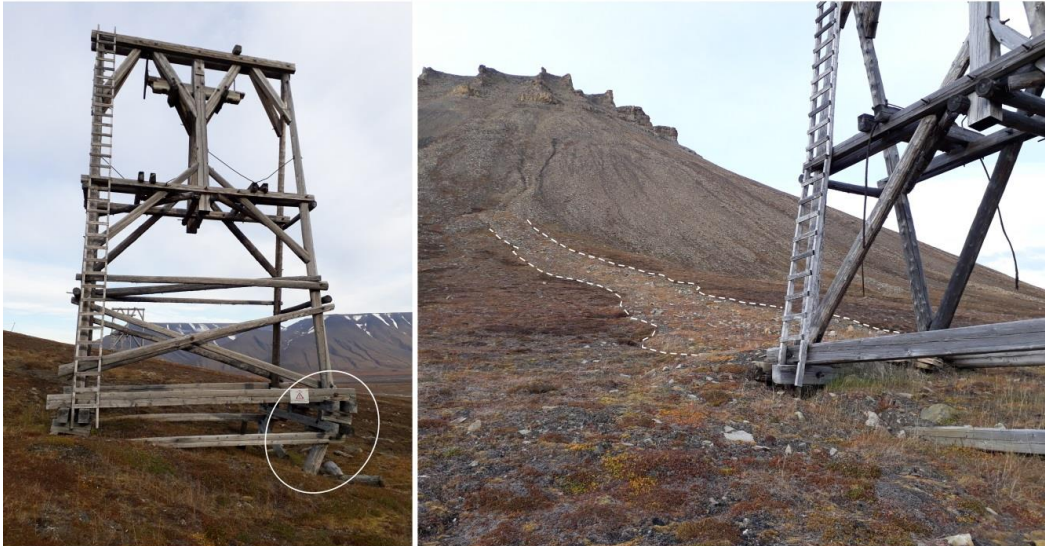
Figur 28: Til venstre: Taubanebukke i Endalen som er utsatt for jordsig. Til høyre: Taubanebukke i Endalen som er utsatt for jord- og sørpeskredaktivitet.
