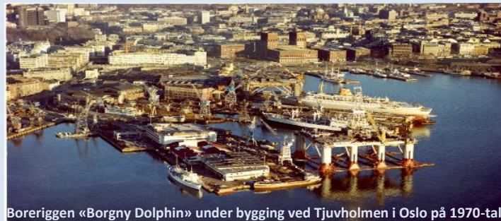
Boreriggen «Borgny Dolphin» under bygging ved Tjuvholmen i Oslo på 1970-tallet
