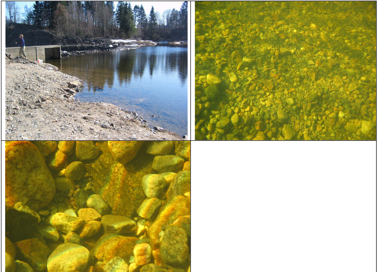
Midterste grusutlegg oppstrøms terskel ved Strubru. Bilde oppe til høyre viser flate med utlagt grus og bilde nederst til venstre viser lakserogn gytt i den utlagte grusen.
