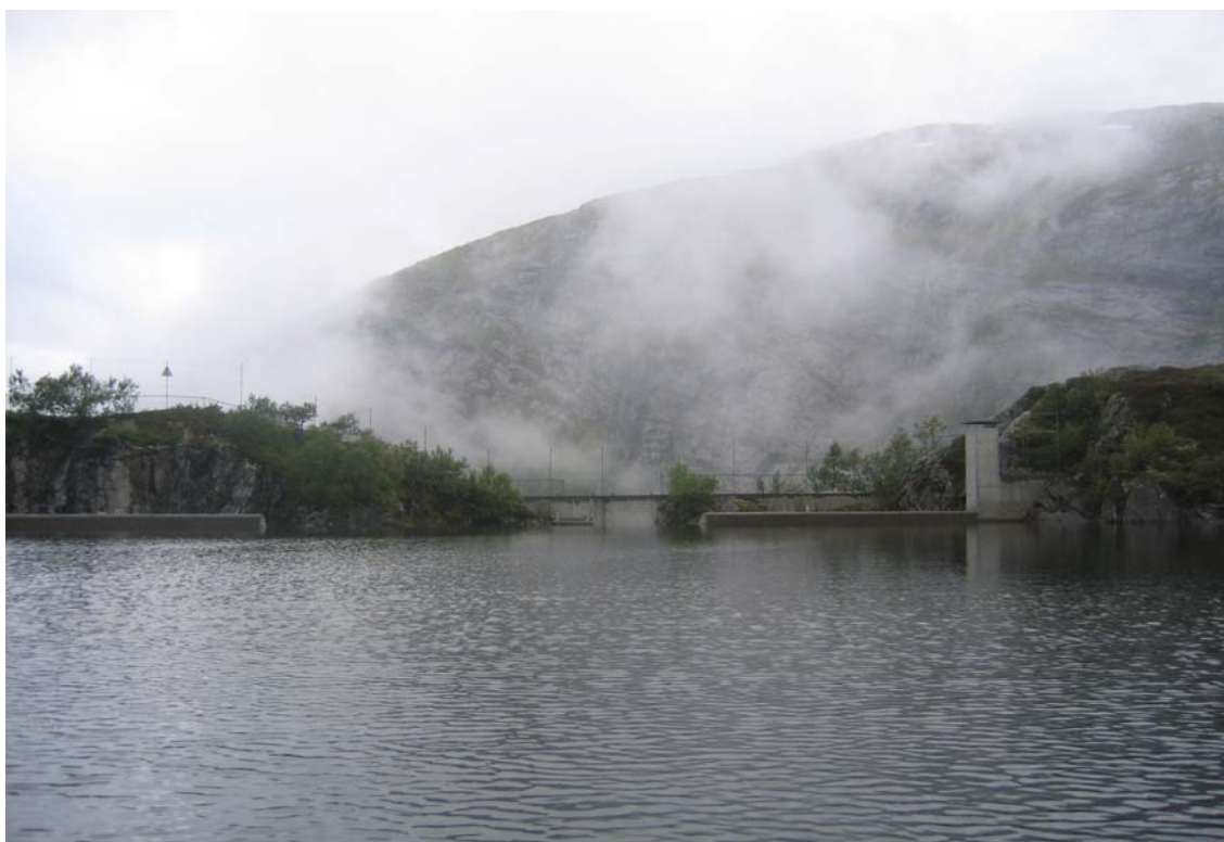
Figur 2. Stølsvatnet var fullt under prøvofisket 27-28 august 2007. Demningen med overløpet sees midt på bildet.
