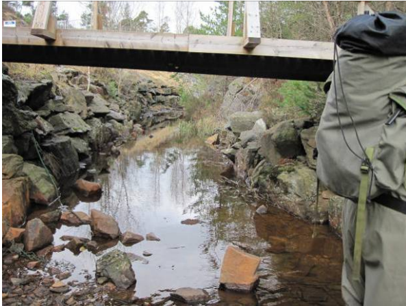
Figur 226 Nedenfor demningen er Polllelven steinsatt og delvis rettet ut.
