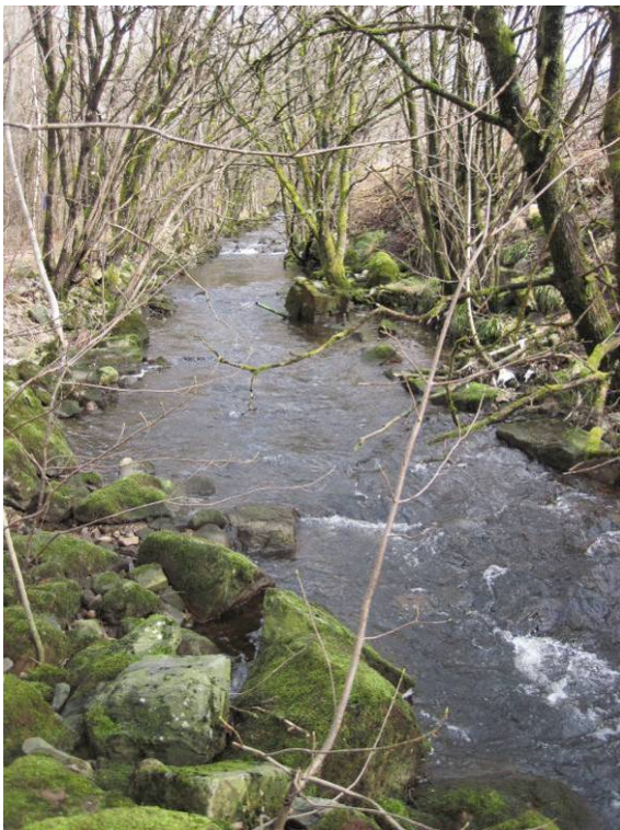
Figur 28 Et eksempel for en heterogen steinsetting med kantvegetasjon som gir både erosjonssikring og høy fisketetthet, fra Sælenavassdraget.
