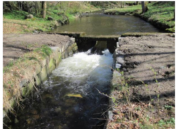
i Figur 89 Strekingen nederst er kanalisert eller steinsatt.
