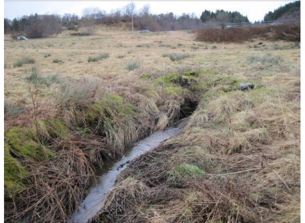
Figur 151 Bekken forsvinner i et 250 lang rør under Fleslandsveien. Bekkelukkingen vurderes som vandringshinder.
