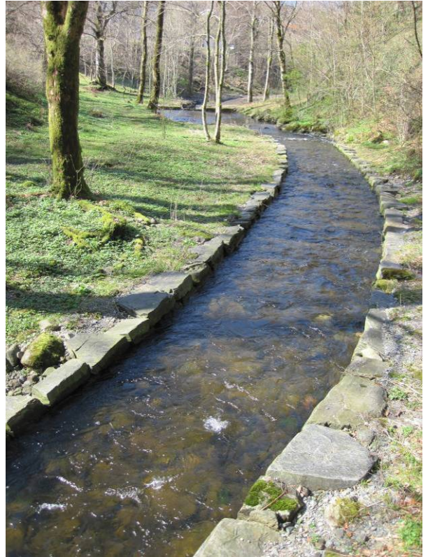
Figur 91 Kanalisert stryk ovenfor med reduserte habitatforhold og miljøstatus.
