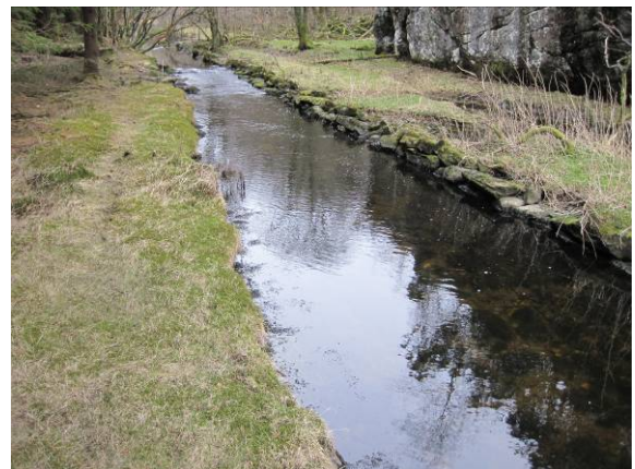
Figur 260 Kanalisert elv mellom Bosvatnet og Eikhammervatnet. med steinsatte bredder
