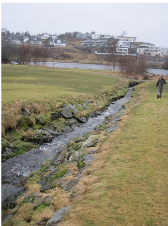
Figur 148 Steinsatt og utrettet stryk ovenfor Skeievannet.
