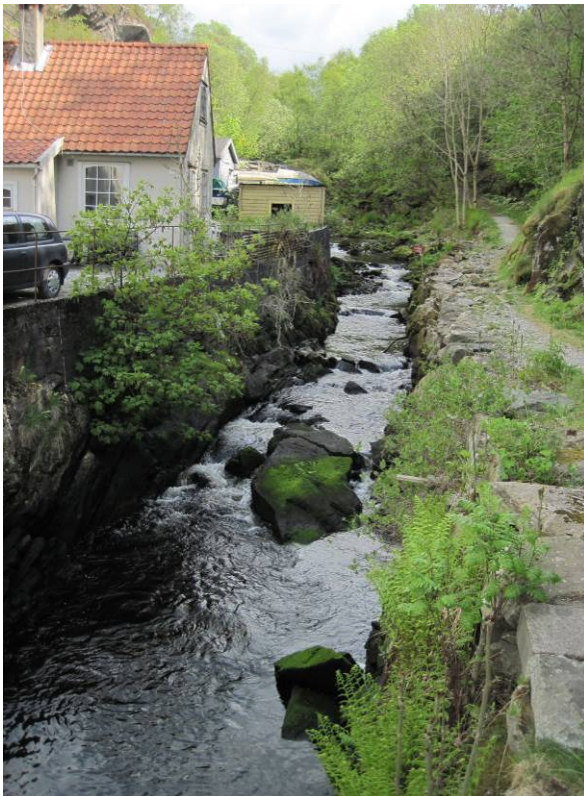
Figur 82 Kanalisert stryk ovenfor munningen. Areal og sideerosjon er redusert men elvens bunn har fortsatt høy morfologisk mangfold.
