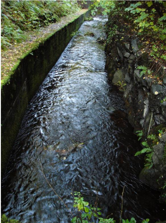
Figur 43 Utløp av kulvert nedenfor Apeltunvannet
