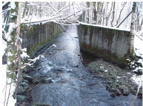
Figur 42 Betongkanalen langs riksvei 580.
