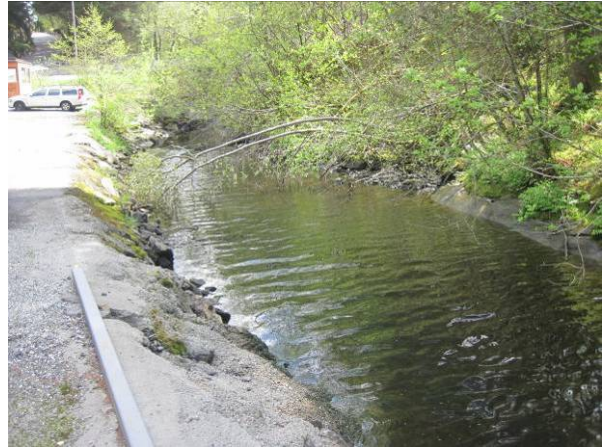
Figur 99 Stryket nederst er steinsatt på østsiden, kantvegetasjon er fjernet.
