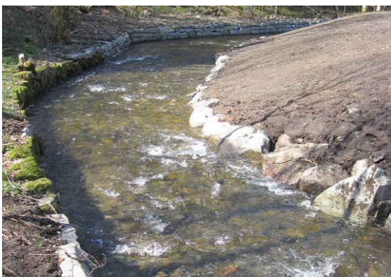
Figur 6 Steinsatt stryk i Gravidalselven: Morfologi – 3, substrat – 3, vegetasjon – 1.
