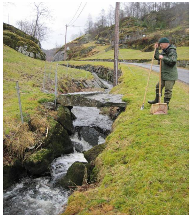
Figur 205 Langs veien er bekken forbygget med en mur.
