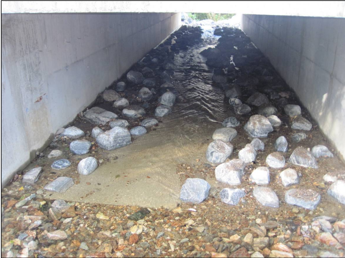
Figur 24 Ny kulvert i Apeltunvassdraget som ble sanert av Bergen kommune og som nå er passerbar for fisk.
