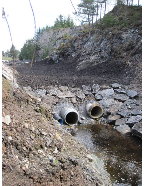
Figur 294 Øvre del av Skjoldåni er lagt i rør. Under kartleggingen i 2010 ble bekkelukkingen utvidet eller rehabilitert.
