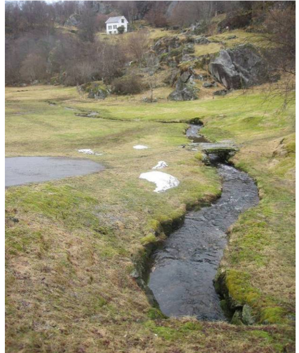
Figur 203 Strekningene som ikke er kanalisert har høyt mangfold innen substrat og morfologi. Kantvegetasjon er fjernet nesten langs hele vassdraget.
