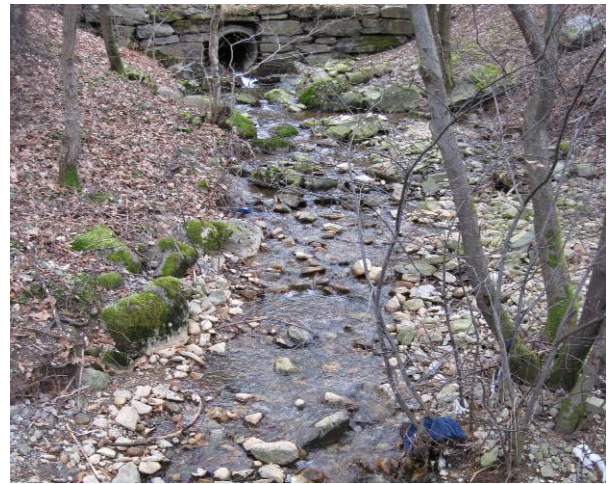
Figur 135 Ovenfor kulverten mot Løvstakken finnes et 20 m lang stryk med gode habitatforhold før neste kulvert begynner
