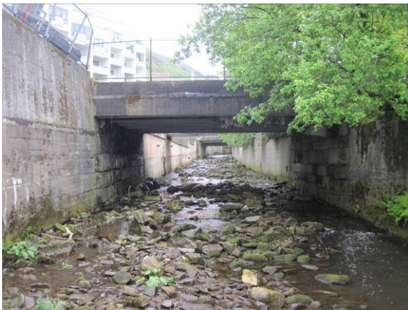
Figur 122 Redusert vannføring fører til redusert vanndekket areal i det brede elvefaret. Hele den anadrome delen er kanalisert.
