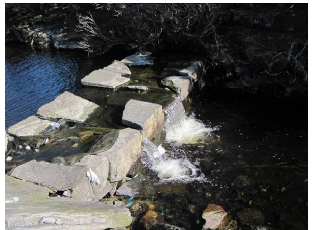
Figur 239 Terskel 50 m ovenfor munning har ikke tilstrekkelig lavvannsrenne er ikke tett og virker i perioder som
