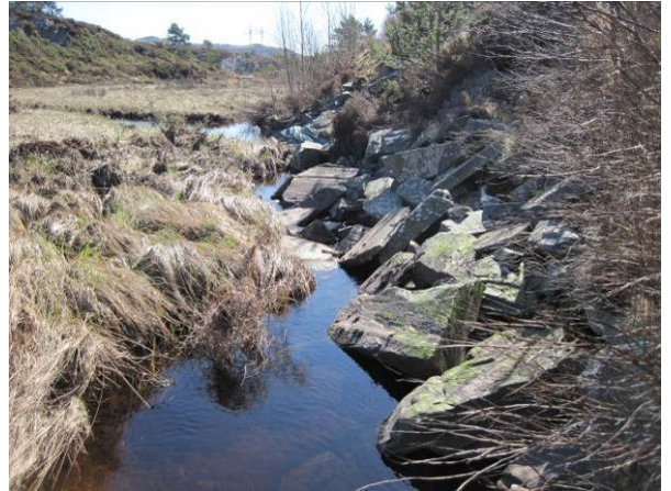
Figur 245 Fylling ved ny boligområde langs Landroveien som dekker neste hele elven.
