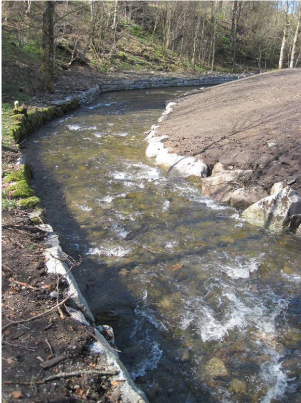
Figur 90 Stryk med mur og steinsetting (delvis nylig utført) som morfologiske inngrep.
