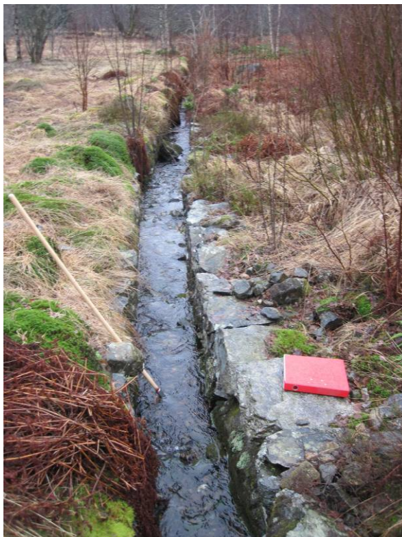
Figur 182 Fra midtre broen og oppover er bekken kanalisert og steinsatt (mur).
