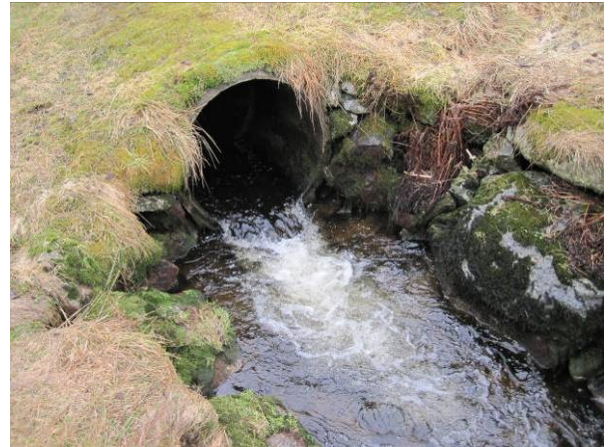
Figur 201 Ovenfor er bekken lagt i rør. Ved lav vannstand kan fisk ikke vandre opp gjennom røret.
