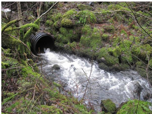
Figur 146 Kulvert under Fleslandveien. Røret vurderes som passerbar for fisk
