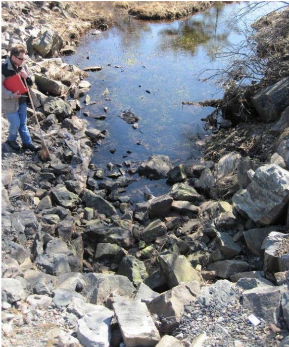
Figur 242 Elven siger fullstendig inn i fylling ved kulvert under Landroveien ved middels og lav vannføring. Fisk kan bare passere ved flom.
