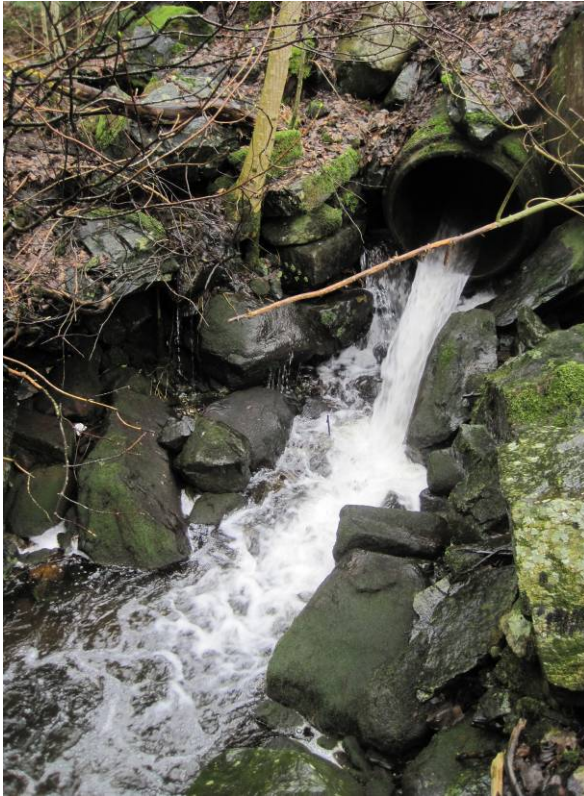
Figur 190 130 m ovenfor munningen stopper en bratt kulvert fiskevandring oppover.
