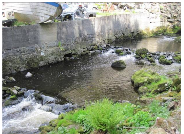
Figur 125 Et eksempel fra Dalevassdraget viser hvordan terskler kan bidra til økt vanndekket areal ved lav vannføring.
