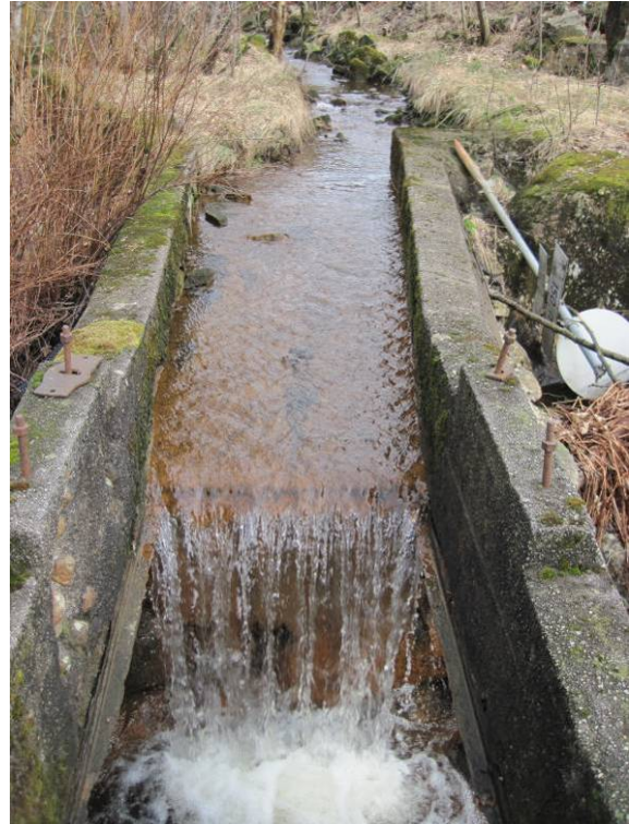
Figur 73 Demning og kanal fra sagbruket er et vandringshinder ved dagens vannføring.
