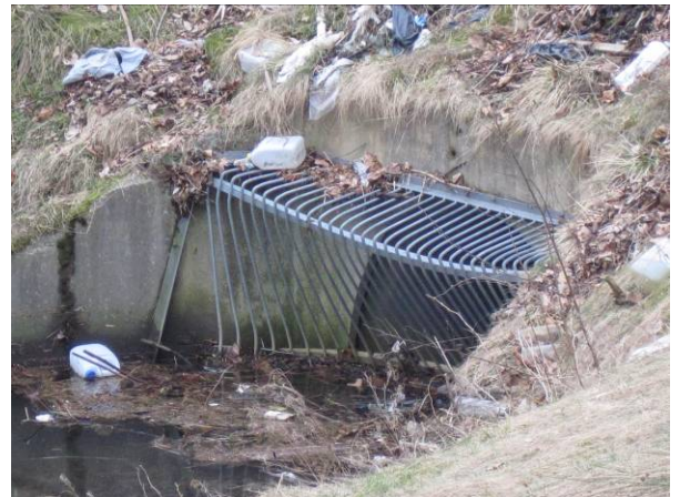
Figur 131 Rist ved innløp til røret.
