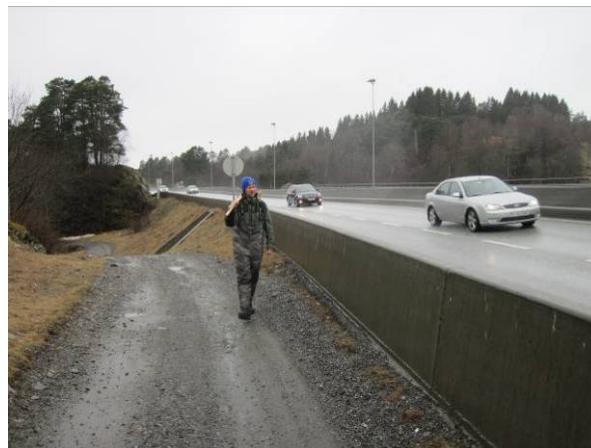
Figur 147 Fleslandveien, her ligger bekken i rør.
