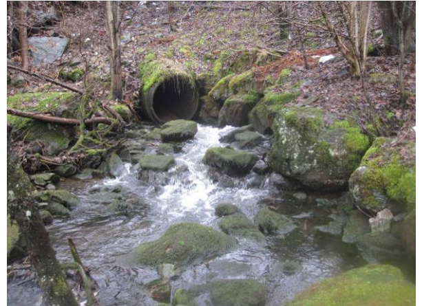
Figur 195 Øvre enden av kartlagt strekning: Bekken forsvinner i et flere hundre meter lang rør.
