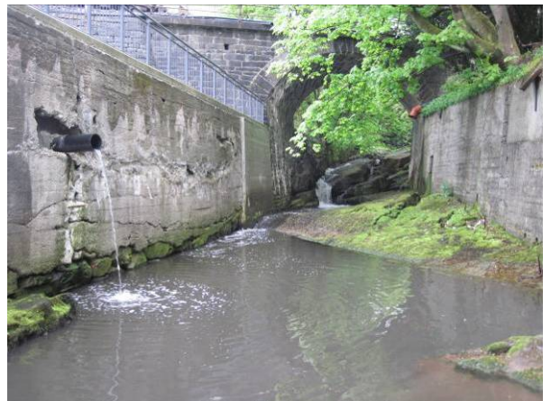
Figur 123 Visuelt synlig forurensing øverst i anadrom strekning.
