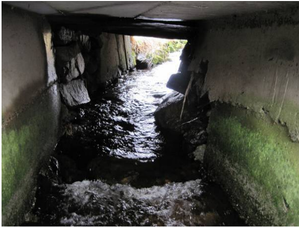
Figur 200 Kulverten under veien er passerbar for fisk.
