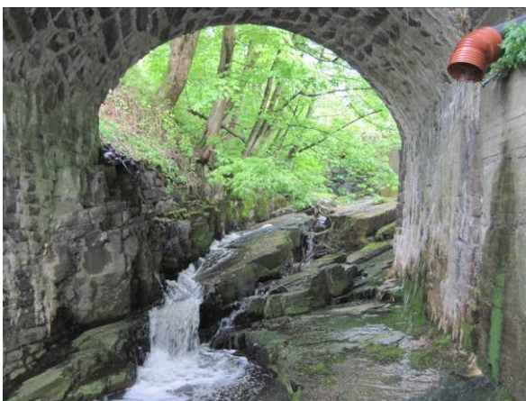
Figur 124 Stryket øverst i vassdrag forsvinner i en kulvert som ikke er passerbar.
