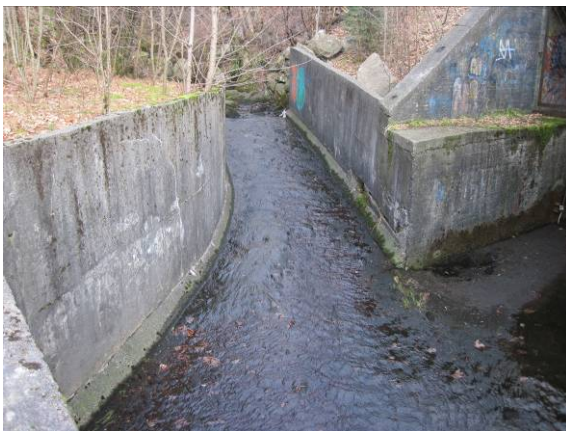
Figur 68 Betongkanal opp mot bekken til Spelhaugen/Lauvåstjørna, til høyre kulvert til Ortuvannet
