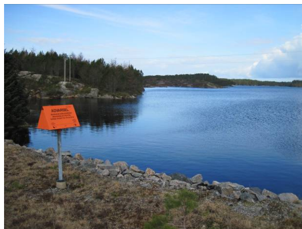
Figur 292 Storavatnet sett fra sør ved Alvheim vassverk.
