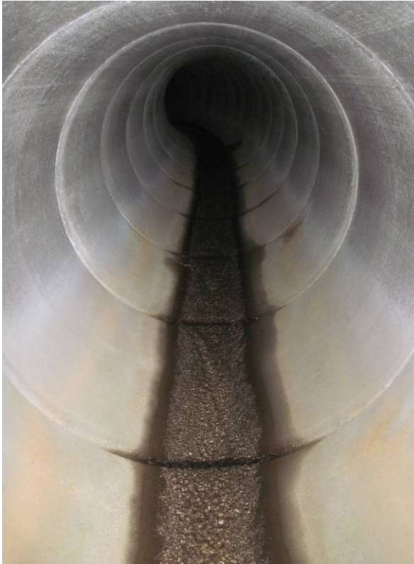
Figur 132 Mesteparten av Fjøsangervassdraget ligger i rør. Bildet er tatt i nederste kulvert.
