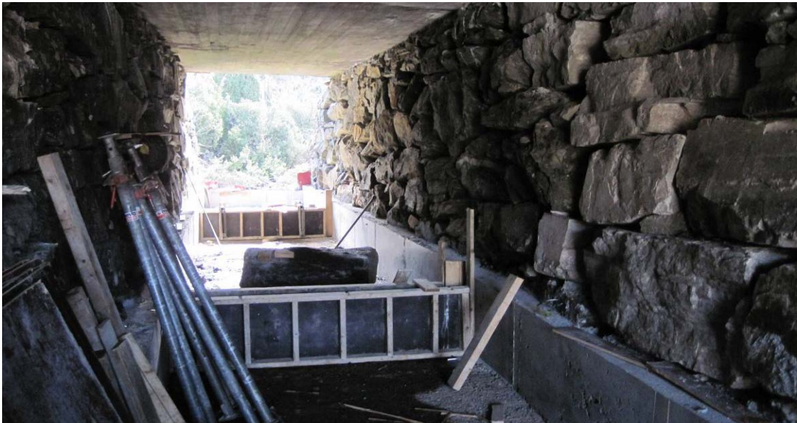
Figur 32 Bildet fra bygging av ny veikulvert (4/2010) ved en bekk i Årvika/Sotra. Her støpes det tverrvegger for å lette oppvandring av fisk (etter innspill fra Tore Samuelson).
