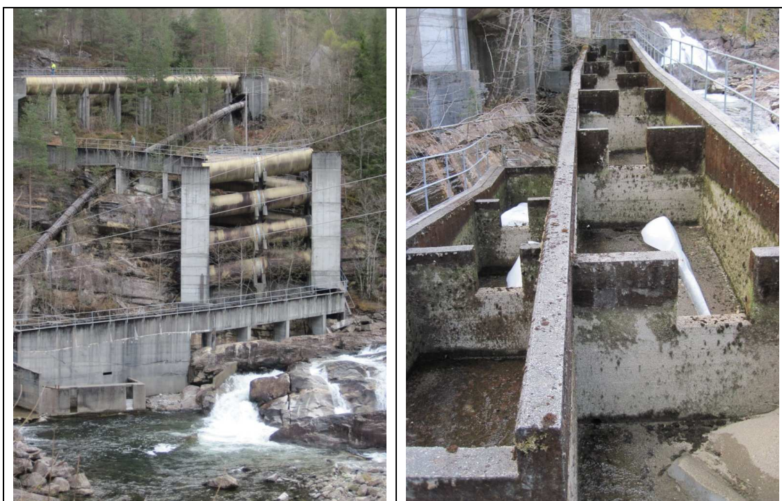
Fisketrappen i Hellandsfossen ble bygget i 1983 og er enestående i sitt slag i Norge. Fisken må vandre opp igjennom en kombinasjon av mange kummer og rør før den når toppen av trappen som ligger 35 meter over inngangen.
