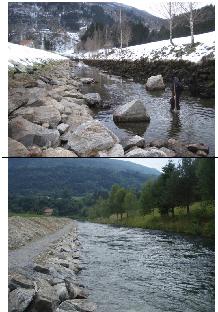
Bilde 3. Det er lett å observere biotopjusteringene i tiltaksområdet i kanalsonen ved lav vannføring, mens justeringene blir helt dekket av vann når Hove kraftstasjon er i drift.
