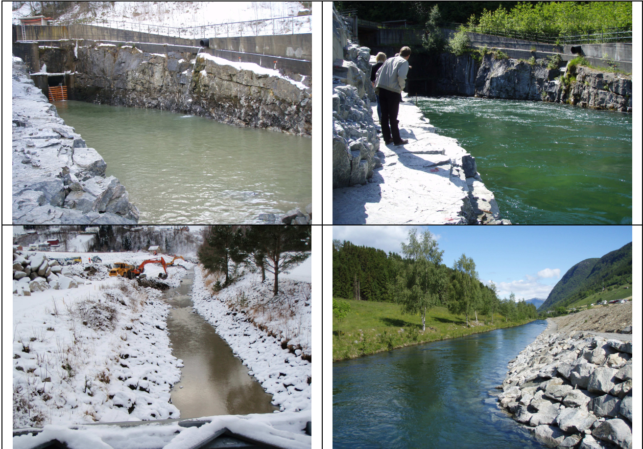
Bilde 1. Bilder til venstre: Anleggsarbeidet (mars 2009) er i gang og Vikja er regulert ned slik at gravemaskinene kommer til. Bilder til høyre: Anleggsarbeidet er ferdig og vannføringen er tilbake til det normale.
