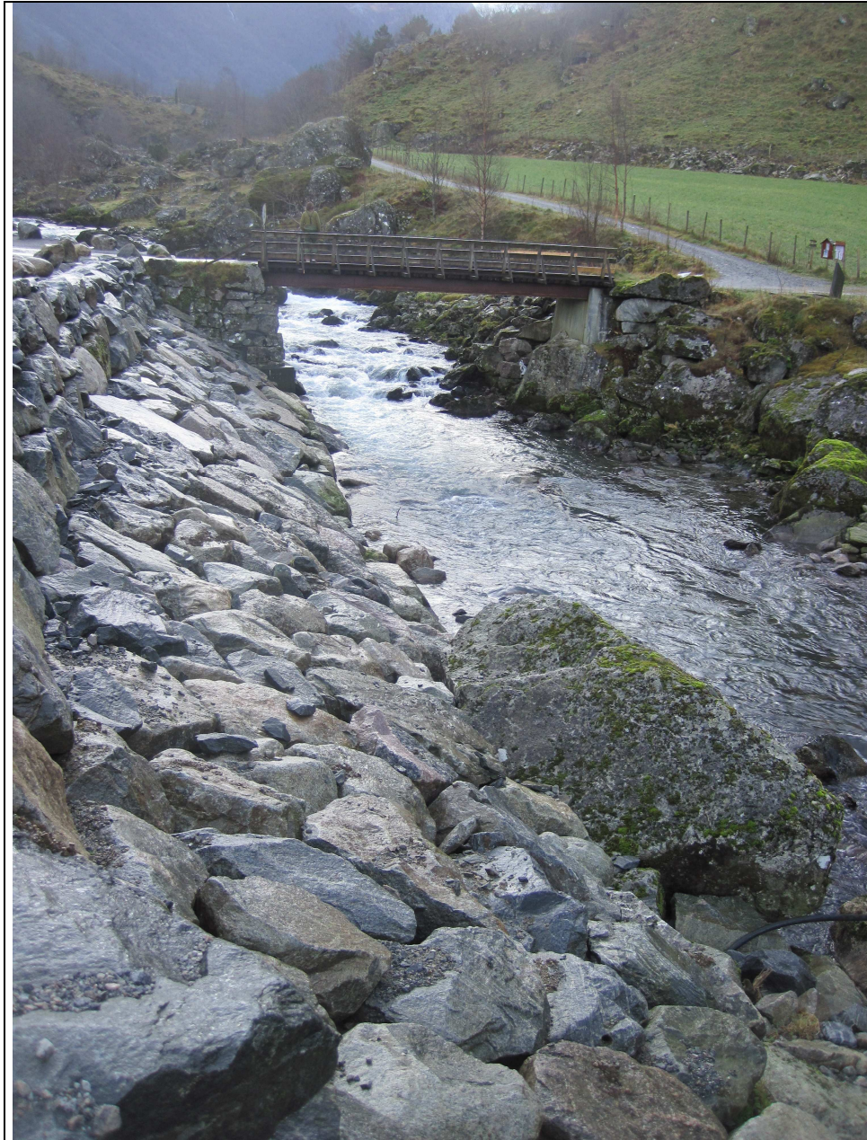
Bilde 8. Ny plastring av elvebredde ved elfiskestasjon 2 i Bondhuselva. Endringene gjorde stasjonen uegnet for elfiske og det ble derfor ikke elfisket her i 2011.
