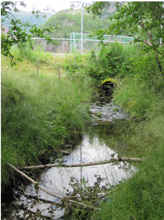
Fig. 6 Øvre enden av Drivo (rør under idrettsbane)
