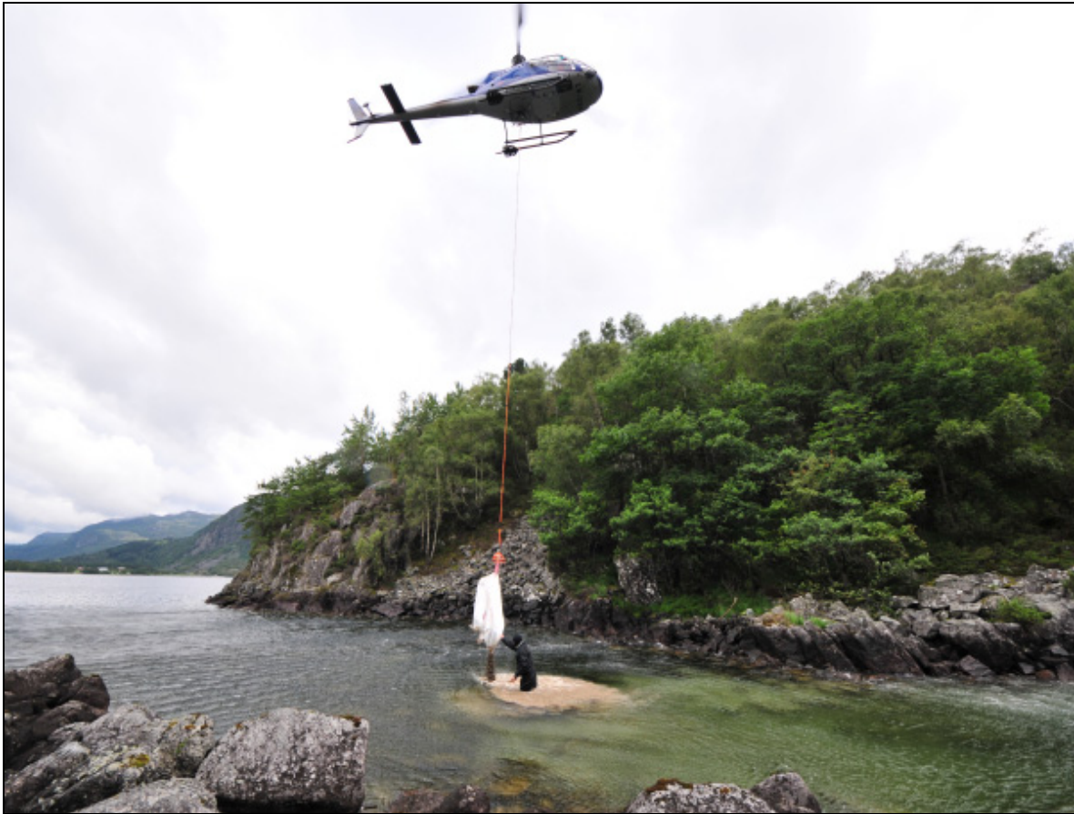
Figur 43: Utlegging av gytegrus i utløpet av Øvre Tysdalsvatnet, 09.08.2011.
