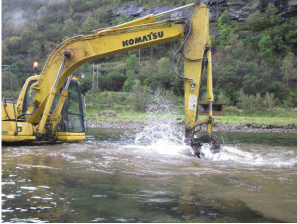
Figur 36 Harving av pakket og fast bunnsstrat (armeringslag) ndf. E 16 bro 2011.
