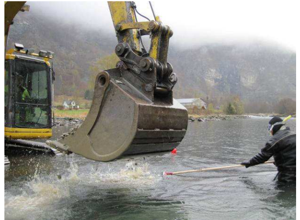
Figur 33 Dykker har utvalgt et egnet sted for grusutlegget og anviser gravemaskinføreren
