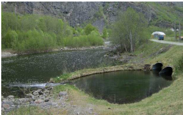
Figur 70 Munning av Tivesja (gjennom kulvert) i Vassbygdelva med kunstig kulp
