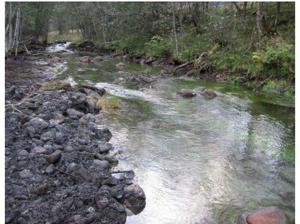
Figur 66 Etter justering av tersklene har vannhastigheten økt, vassdraget har blitt en elv igjen.
