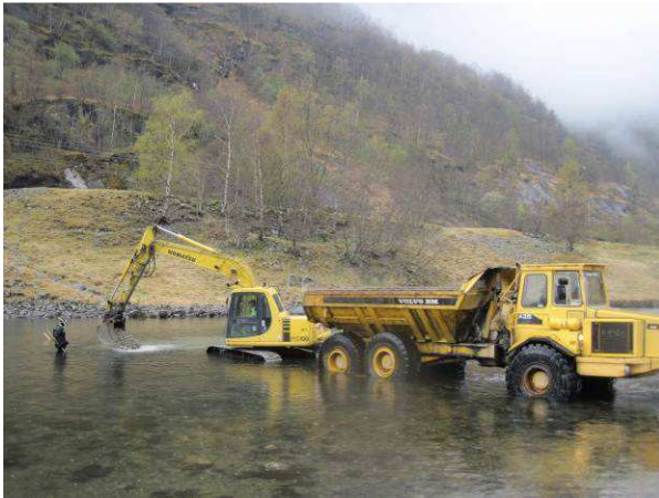
Figur 32 Grusutlegging ved Skaim 2010
