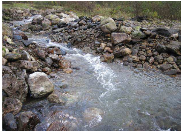
Figur 61 Munningen etter restaurering – passerbart ved alle relevante vannføringer
