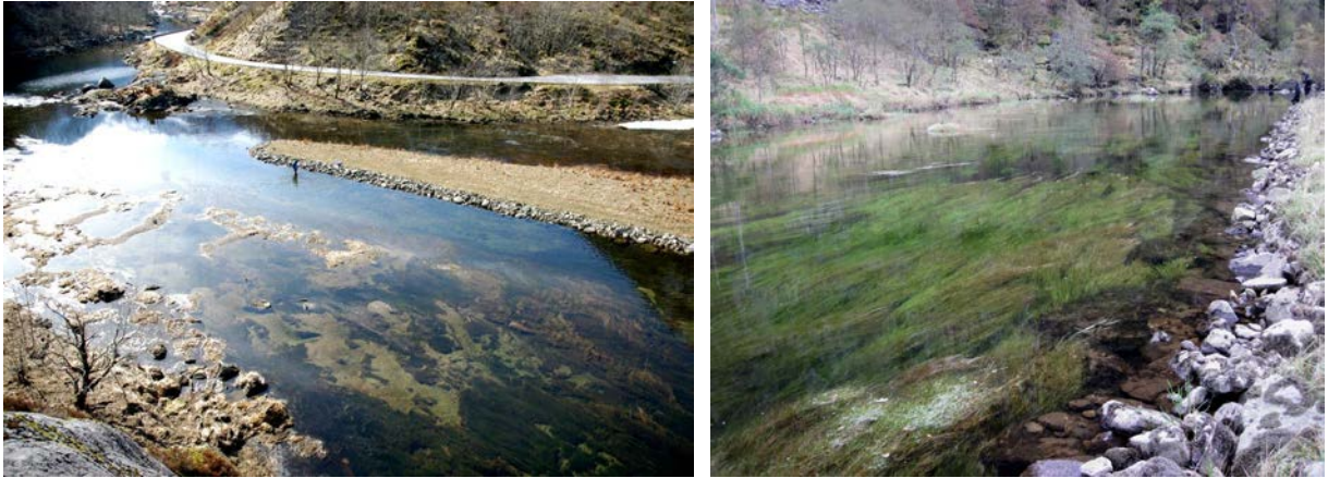
Figur 7. Utløpet av Matrevatnet i Matreelven. Som følge av omfattende begroing av krypsiv ble det laget en ledebune og lagt ut gytegrus i 2001/2002. Bildet til venstre (tatt i 2006) viser tiltaksområdet, og bildet til høyre (tatt høsten 2012) viser at deler av området har grodd kraftig til igjen med krypsiv. Det er imidlertid fortsatt åpne felter hvor det forekommer gyting.
