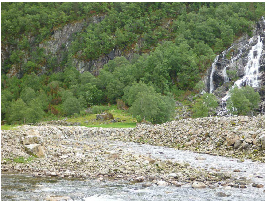
Figur 42 Forbygning langs Torfridbekken.
