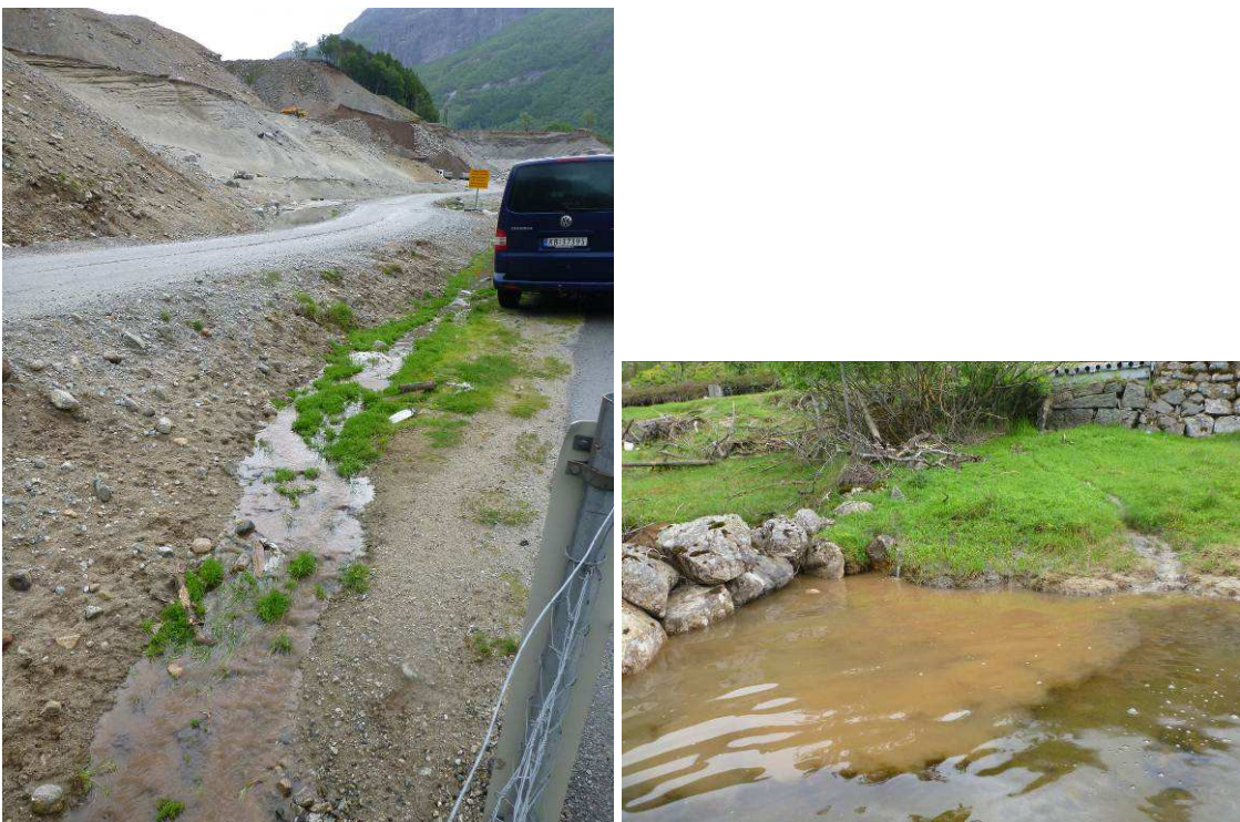
Figur 23 Overvann men sand og svevestoffer fra et grustak på vei til Kjærshølen.
