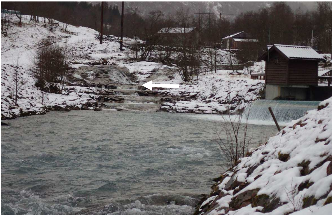
Figur 10 Elvestrekning med habitatvurderinger 1) nedenfor kraftutløpet og 2) i restfeltet (pil i bakgrunnen)
