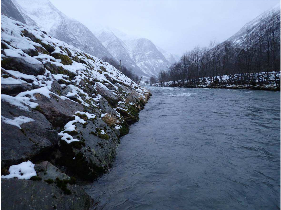
Figur 12 Elvebredden er sikret med en glatt plastring som gir strekningen et kanalaktig preg
