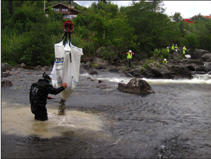
Figur 11: Utlegging av grus i Jørpelandsåna, 27.08.13, nedenfor betongdammen, dvs. mellom nedre og øvre fisketrapp.
