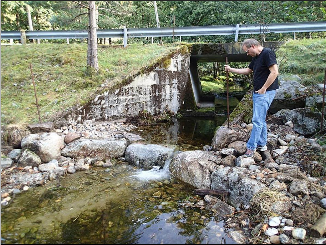
Figur 19: Kulvert i bekk ved Sagjå, etter tiltak.
