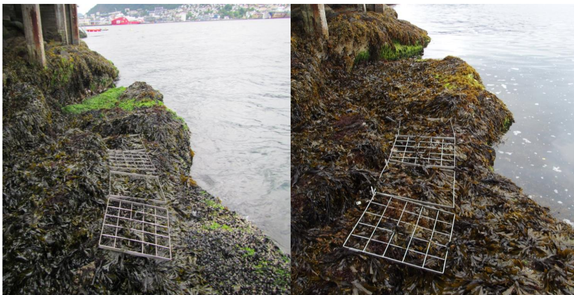
Foto 3.4.3 Oversiktsbilde stasjon By 11. Bildet til venstre er fra 2014 mens bildet til høyre er tatt i 2016.
