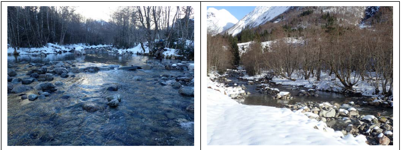
Figur 13. For å sikre den utlagte gytegrusen mot utspyling ble det lagt ut store steiner i området nedenfor gytegrusen. Det ble i tillegg laget en lavvannsrenne for å sikre god vanngjennomstrømning og vandringmuligheter ved lav til middels vannføring. I tillegg ble det lagt ut steiner og blokker for å stabilisere gytegrusen og for å øke den hydromorfologiske variasjonen i det etablerte dypområdet.
