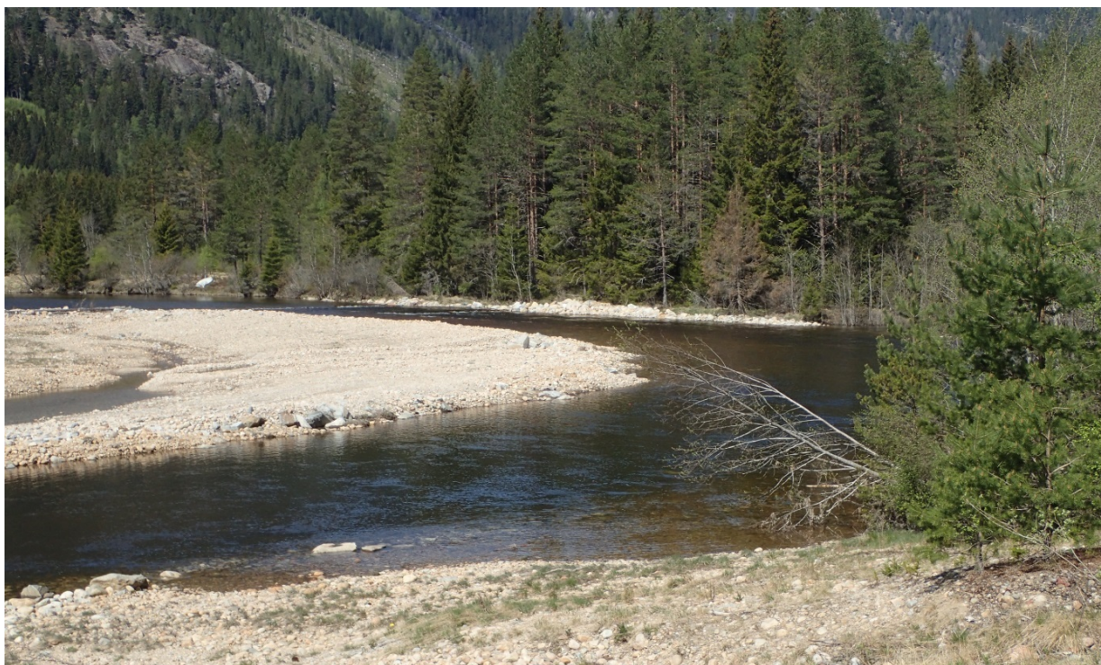
Fig. 35 Omløp kan ha større omfang, f.eks. som her «Blekeløpet» i Otra. Det er 460 m langt, utformet som naturtypisk elveløp av kulp-stryk-type, har dynamisk substrat i erosjonssikre rammer, og 7- 24 m bredde. Q_{\text{dimensjonerende}} er 3-15 \text{m}^3/\text{s} , gradient er 0,002-0,008 (Statens Vegvesen, Agder Energi, Uni Research Miljø LFI, 2012). Kostnader var 2,5 MNOK.
