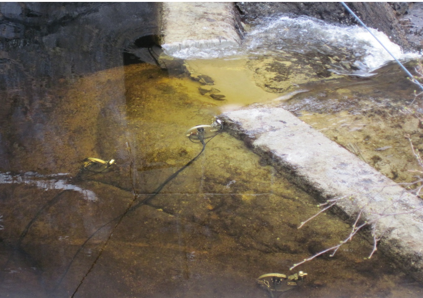
Fluktåpninger er et viktig hjelpemiddel for å få nedvandrende fisk trygt forbi demninger og kraftverk. Her fra demning Tveitofoss kraftverk i Bjoreio, Hordaland.
