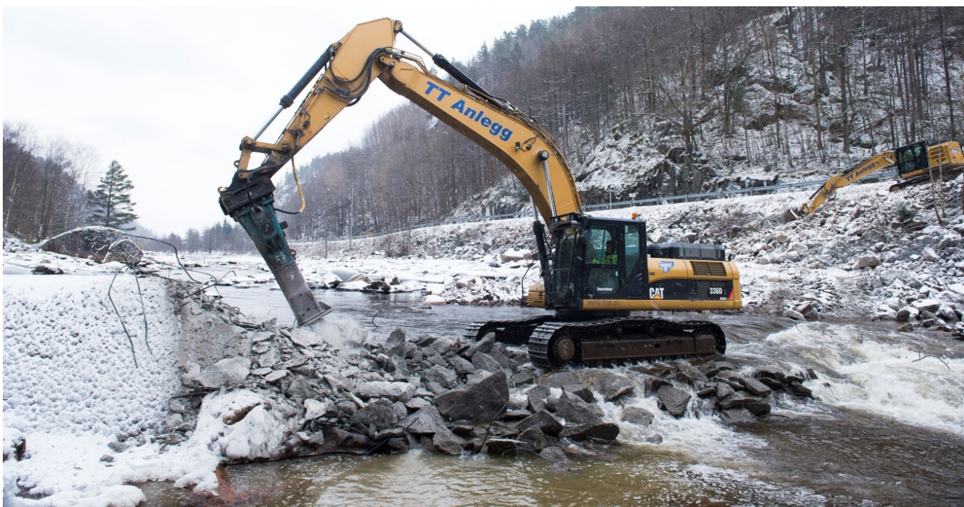
Fig. 14 Fjerning av terskler i Mandalselva 2016. Miljødesign-prosjektet er blant Norges mest omfattende og gjennomføres av Agder Energi sammen med Nina, Sintef, Uni Research Miljø LFI m.fl. Foto: Agder Energi.
