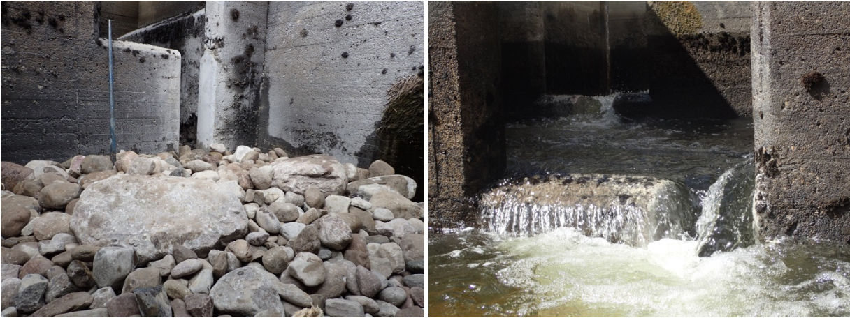
Bilder fra ombygging av kulpetrappen på Høyegga i Glomma til en spaltetrapp i rammen av SafePass-prosjektet (CEDREN, med GLB, Eidsiva Energi, NINA, SINTEF og Uni Research Miljø LFI).
