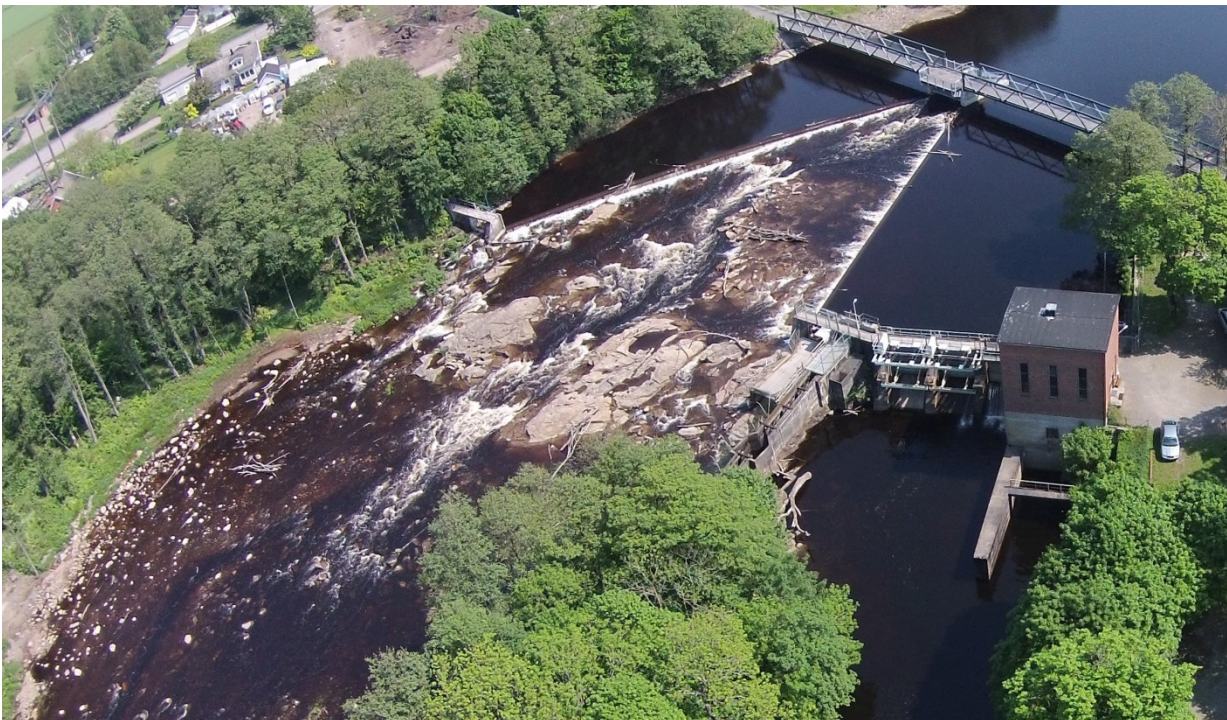
Naturtypisk omløp ved Herting kraftverk i Ätran (Sverige, se også nærmere beskrivelse i kap. 7). Omløpet har minst 11 m 3 /s og brukes både til opp og nedvandring av fisk. (Foto: Fiskevårdsteknik AB)
