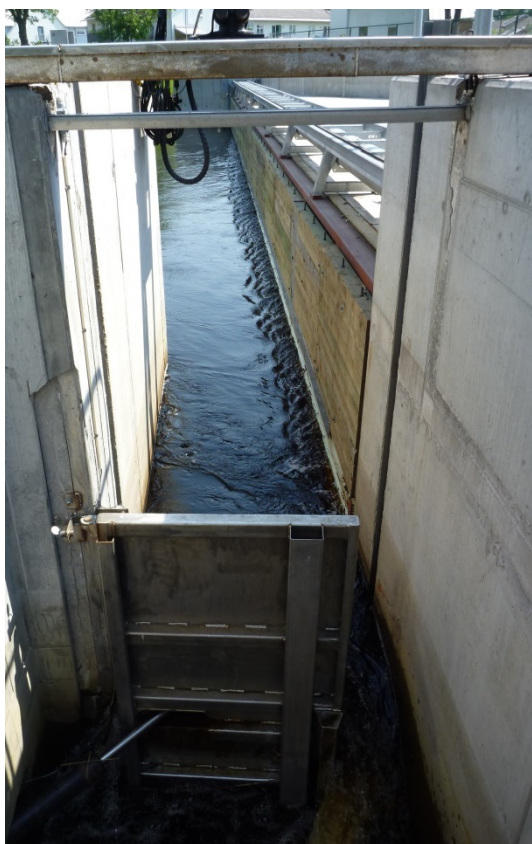
Fig. 142 Fluktåpning med spyleluka (venstre bilde, Foto: Olle Calles) og passasjeeffektivitet [%] for ål, laks og havniøye (få individer) etter tiltaket.
