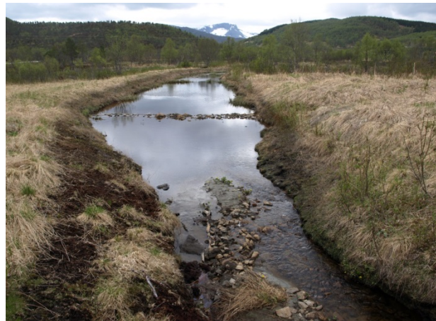
Fig. 117 Venstre bilde: Øvre dukområde med stasjon 2. Her er elvestrengen åpnet gjennom gjengrodde områder ved legging av fiberduk. Oppå duken er det er lagt ut grus og stein for å bedre gyte- og oppvekstforholdene for ørret og skape nye leveområder for et mer variert bunndyrsamfunn (Foto Ballangen Energi AS). Høyre bilde: Nytt sedimenteringsbasseng (fangdam- og våtmarksfilter) nederst i Bruksåskanalen (Foto Fylkesmannen i Nordland).
