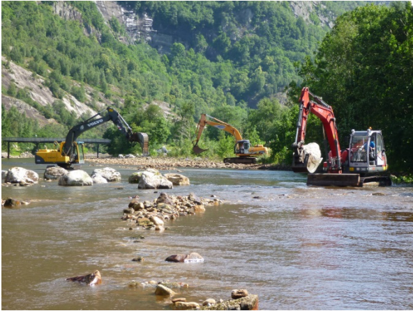
Fig. 79 Bygging av buner satt opp av enkeltstein i nedre deler av elven i 2013
