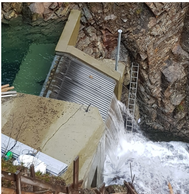
Fig. 46 Coanda inntak i drift ved Byro kraftverk (Odda kommune, Foto: Småkraft AS, profiltegning modifisert etter Bjarte Skår, Brødrene Dahl AS). Pilene illustrerer vannstrømmen, mens en ønsket del av vannet faller gjennom risten, renner resten viderer nedover – inkludert fisk og drivgods
