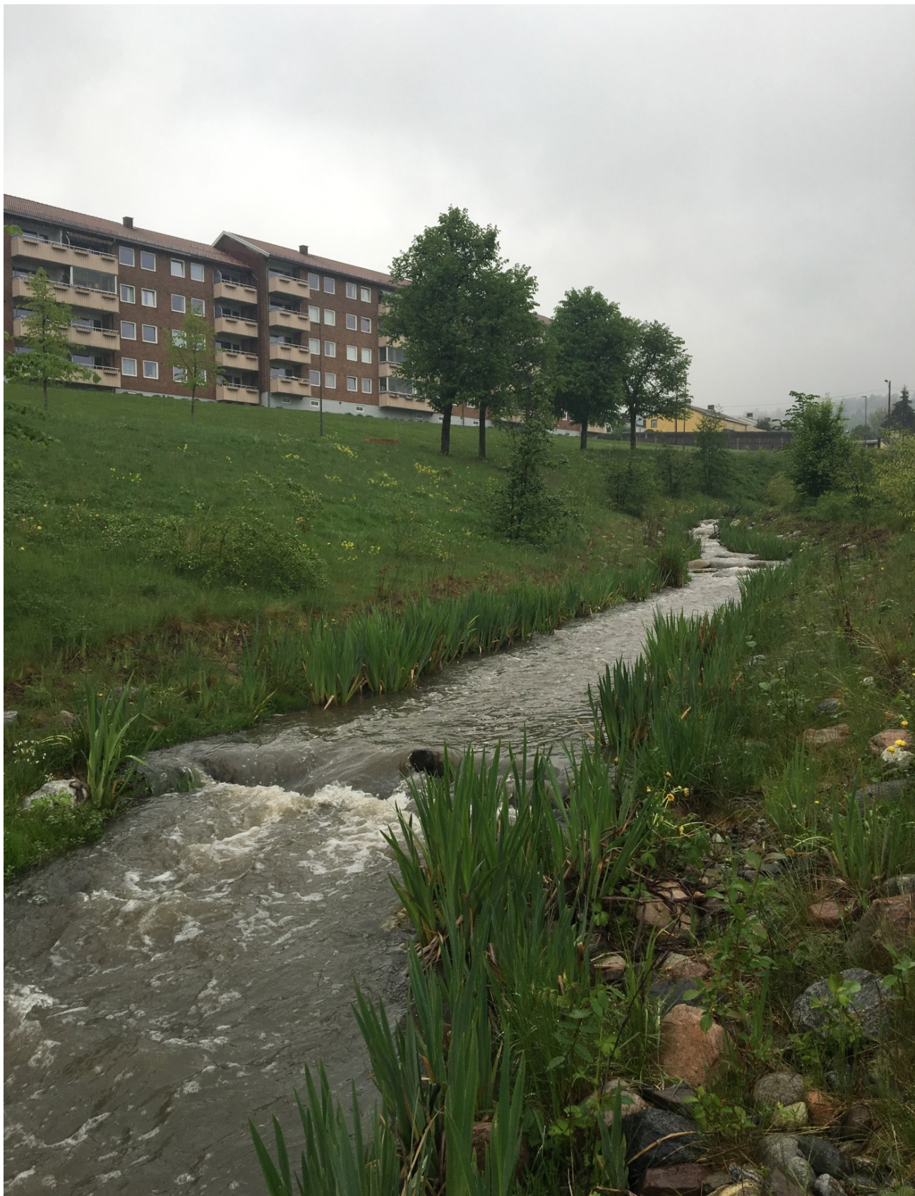
Hovinbekken i Oslo er gjenåpnet gjennom Bjerkedalen park over en strekning på 350 meter. Det er lagt til rette for vandring og opphold for ørret som naturlig hører til i vassdraget. Prosjektet har vunnet Oslo Bys Arkitekturpris i 2015 og pris for Norges beste uterom i 2016. Tiltakshaver Oslo kommune, med Dronninga landskap (bilde: Oslo kommune VAV, med tillatelse fra VAV/Tharan Fergus).
