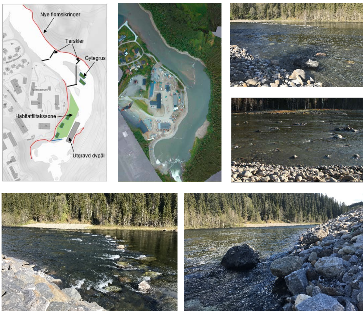
Fig. 130 «Sjøforsløpet» i Røssåga etter gjennomførte tiltak.
