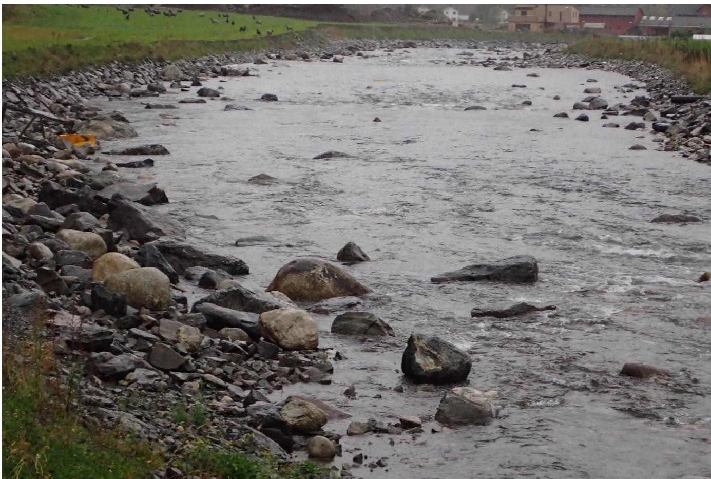
Tradisjonell erosjonikring med glatt plastring (øvre bilde) og tilbaketrukket erosjonssikring med mer naturtypiske elvbredder (nedre bilde Flåm 2017, NVE med Uni Research Miljø LFI).
