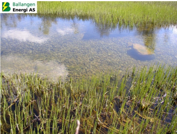
Fig. 117 Venstre bilde: Øvre dukområde med stasjon 2. Her er elvestrengen åpnet gjennom gjengrodde områder ved legging av fiberduk. Oppå duken er det er lagt ut grus og stein for å bedre gyte- og oppvekstforholdene for ørret og skape nye leveområder for et mer variert bunndyrsamfunn (Foto Ballangen Energi AS). Høyre bilde: Nytt sedimenteringsbasseng (fangdam- og våtmarksfilter) nederst i Bruksåskanalen (Foto Fylkesmannen i Nordland).
