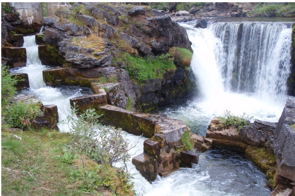
Fig. 39 Klassisk kulpetrapp for laks i Bergebyelva, Finnmark. (Foto: Hans-Petter Fjeldstad)
