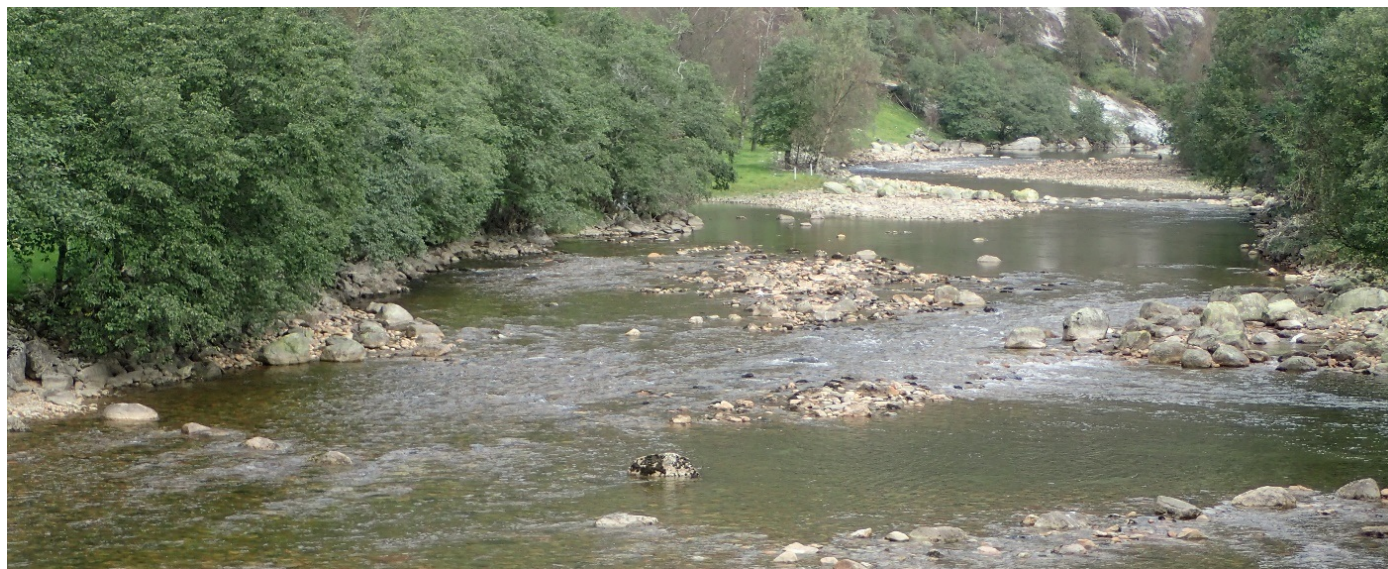
Buner bygget opp av enkeltstein etter naturtypiske forbilder. Buner bidrar til konsentrering av vannstrøm ved lave og mellomstore vannføringer, og de gir økt morfologisk variasjon. Buner brukes også for å konsentrere vannføring ved elv i elv -prinsippet (s. 61). Bildet er fra Frafjordelva 2016.
