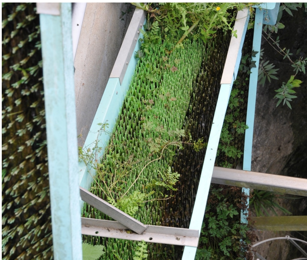
Fig. 40 Ålepassasje ved kraftverk i Frankrike. Her ledes oppvandrende glassål til en rampe fylt med «kunstgress» og vann. Denne og lignende metoder er benyttet ved mange kraftverk i Frankrike, Tyskland, Irland og England. (Foto: Frode Krogglund).
