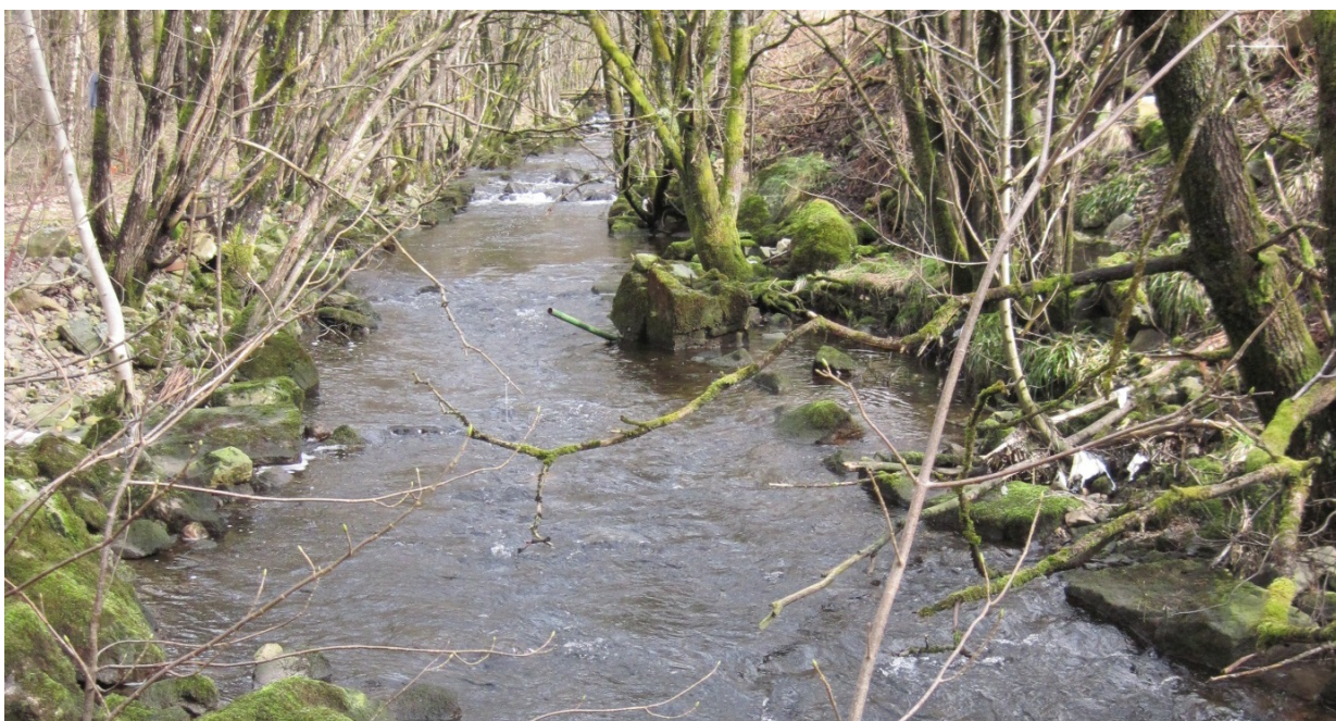
Fig. 67 Denne erosjonssikringen med uregelmessig steinutlegg («steinrøys») og trær i Sælenelven har tålt mange tiår med flommer, og har gitt langt bedre miljøforhold enn glatt plastring eller mur. Sedimentdynamikken er redusert, men det finnes fortsatt skjul, hulrom, røtter og trær langs elvekantene.
