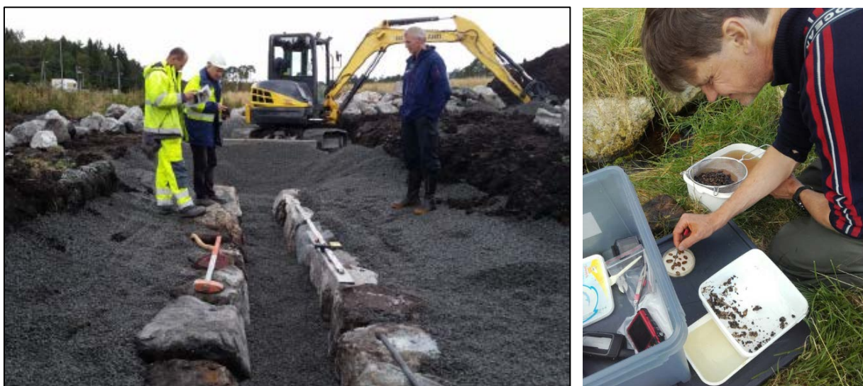
Fig. 138 Tv. Elvemuslingbekken på Haukås ligger omgitt av tykke lag med 8 mm grus. Naturstein stabiliserer kantene. Noe jord legges tilbake på toppen og tilsådd med en gressfrøblanding som får dype røtter. T.h. Steinar Kolås, Rådgivende biologer, konstaterer god vekst på muslingene etter 8 måneder i «nyebekken».
