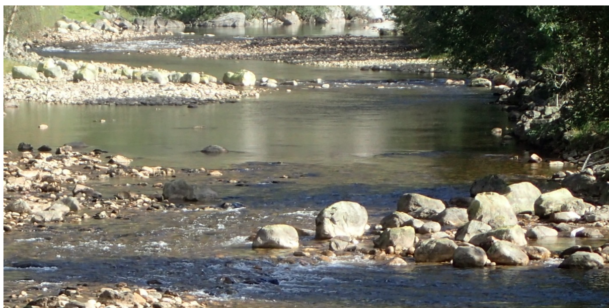
Fig. 34 Buneformete steinutlegg i Frafjordelva, som bidrar til dypål og variasjon i en tidligere homogen del av vassdraget (Stavanger jeger og fiskerforening med Uni Research Miljø LFI).
