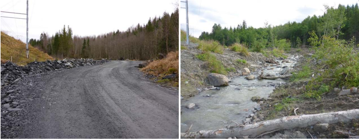
Fig. 122 Bildene er tatt på samme sted. Til venstre under anleggsarbeidet og til høyre like etter at arbeidet er ferdig. Trær og gresstuer ble plantet oppå vekstmassene.
