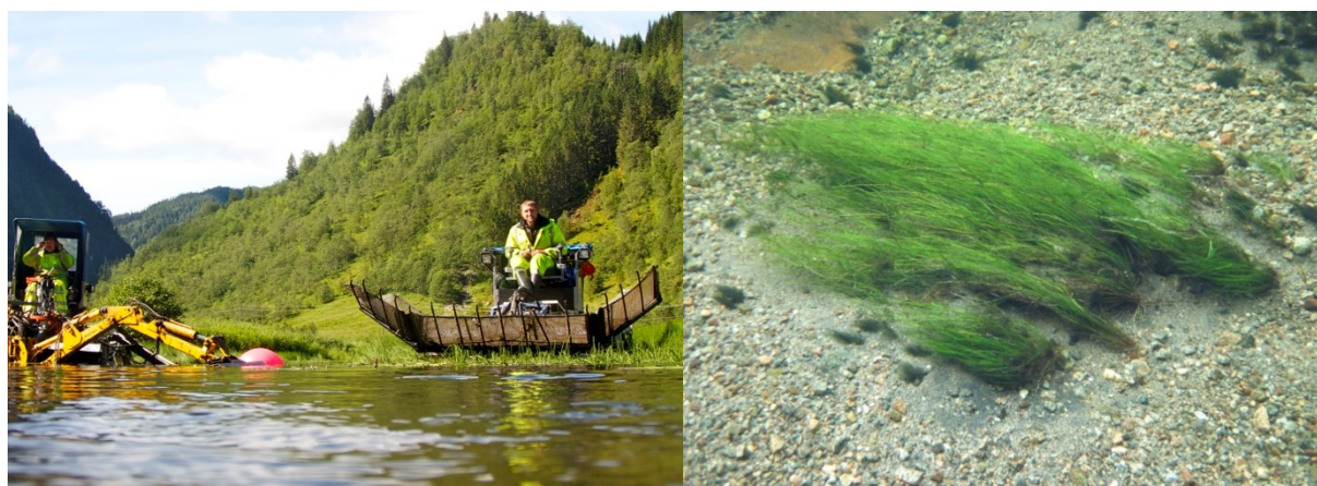
Fig. 60 Fjerning av krypsiv i Teigdalselva (venstre) ved hjelp av gravemaskin og spesialbygd fartøy. Finere sedimenter akkumuleres i og rundt ny tilvekst av krypsiv i Matreelven (høyre).
