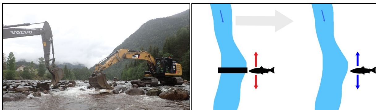
Fig. 22 Fjerning av kunstige vandringsbarrierer gir full konektivitet for fisk og bunndyr. Bildet til høyre viser fjerning av terskler i Tokkeåni.
