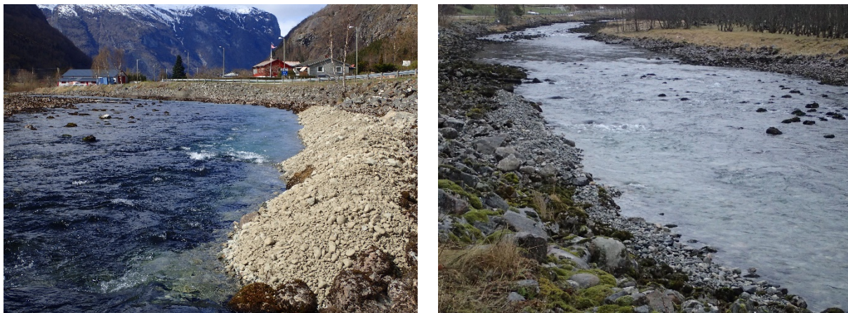
Fig. 57 100 m 3 grus og rullestein (32-200 mm) utlagt langs en erosjonssikret elvebredd i Aurlandselva (2016). Året etter (høyre bilde) var mesteparten av sedimentet erodert og fordelt nedstrøms utover elvebunnen, der det virker som gytesubstrat og ungfiskhabitat (E-Co Energi og Uni Research Miljø LFI).
