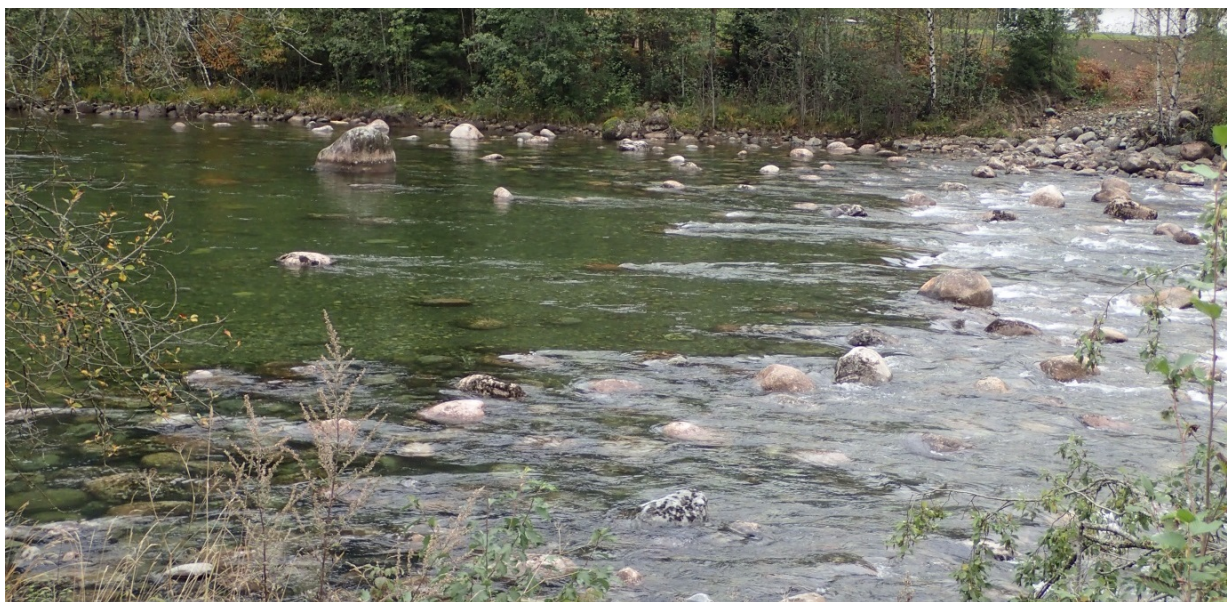
Fig. 28 Tidligere geometrisk terskelkant som ble fjernet. Nå finnes det et naturtypisk brekk med gyteplass på oversiden og stryk med dypål på nedsiden. Stabile steiner (egenvekt) er gravd ned i grunnen og lagt ut med høy variasjon og ruhet, samt med en lavvansrenne i midten. (2016, Tøkkeåni, Statkraft med Uni Miljø LFI).
