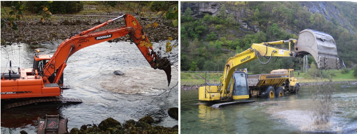
Fig. 132 Ripping (venstre) og utlegging av gytegrus (høyre)
