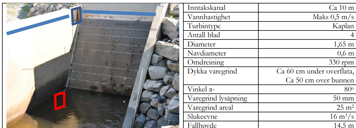
Fig. 107 Inntaksvaregrinda ved Fosstveit kraftverk. Varegrinda er dykka ca. 60 cm, og hevet ca. 50 cm over bunnen. Fluktrute for anadrom fisk er markert med blå firkant. Fluktrute for ål er ikke synlig på bildet, men markert med rød firkant. Vannspeilet ved normal drift av kraftverket er markert med blå strek. Karakteristiske data for kraftverket er gitt i tabell (høyre).
