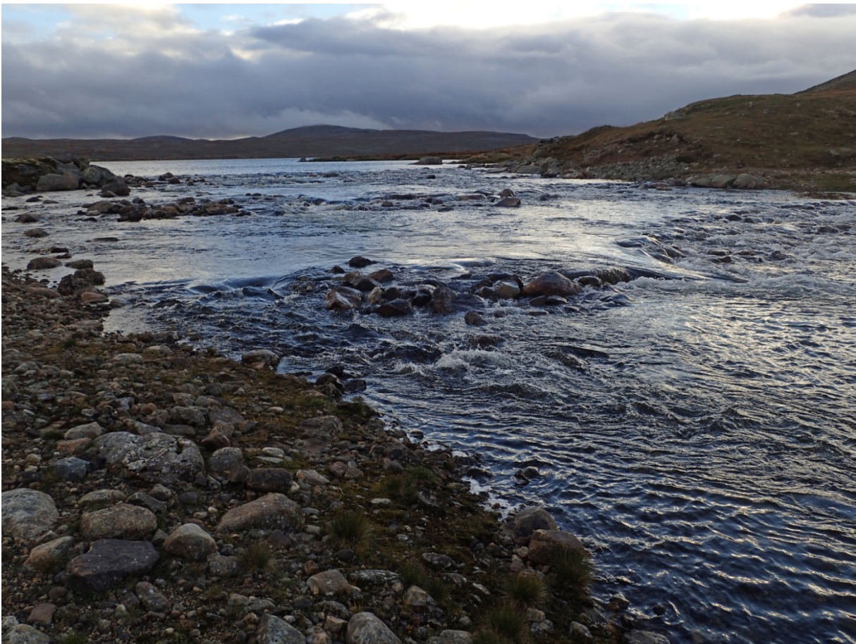
Fig. 23 Djupa, utløp fra Langesjøen på Hardangervidda 2015. En geometrisk terskel fra 1960-tallet ble ombygget til et naturtypisk stryk buner og lavvannsrenne. Høydeforskjell 2 m. (Statkraft, Uni Miljø LFI)
