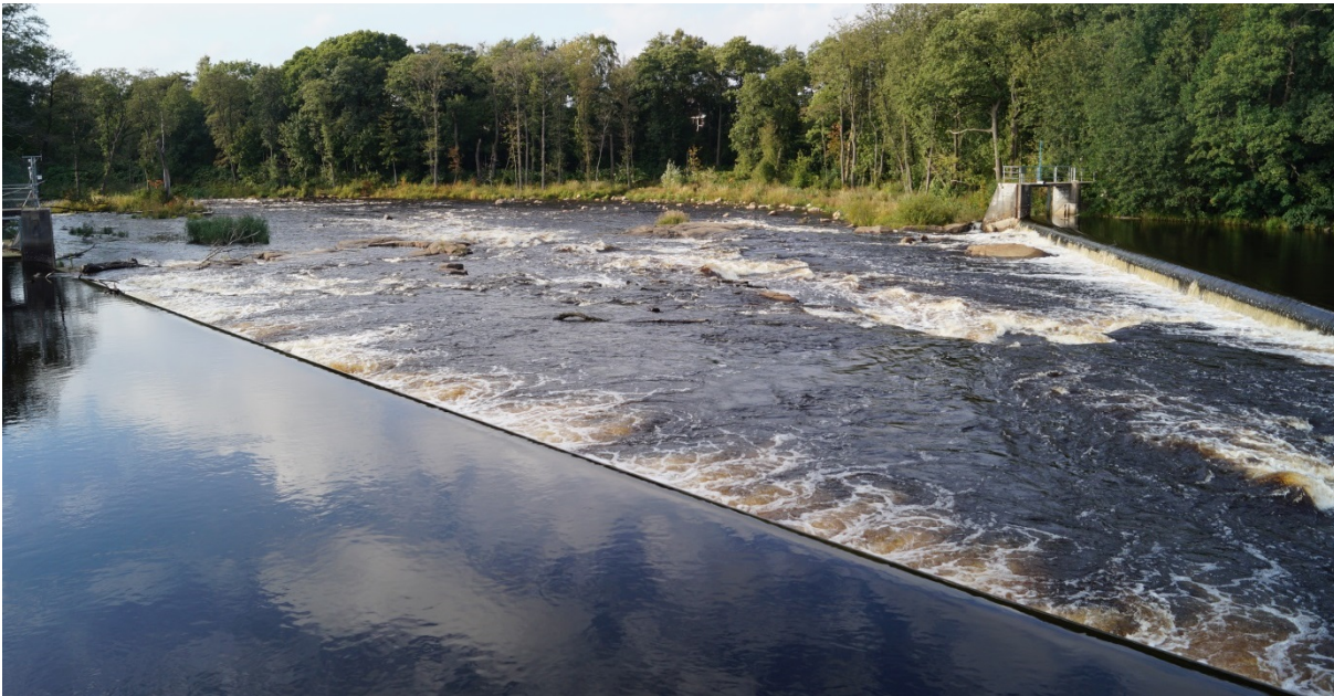
Fig. 140 Øvre del av det naturtypiske omløpet med V-formet demning (Foto: Olle Calles).
