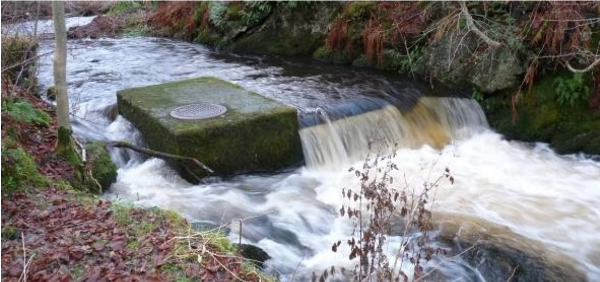
Fig. 36 Eksempel på et lite omløp ved terskel med vanninntak i Apeltunelva i Bergen. Sideløpet til venstre for vanninntaket ble åpnet og sikret med stein. Fisk kan nå vandre fritt ved de fleste vannføringer. Tidligere kunne fisk bare passere ved større flommer (vannføringsavhengig vandringshinder). Sideløpet ble lagt slik at vanninntaket fortsatt fungerer etter hensikten (bidrag til sirkulering av brakkvannspoll). Kostnader 4 timer dugnad (Bergen Sportsfiskere).
