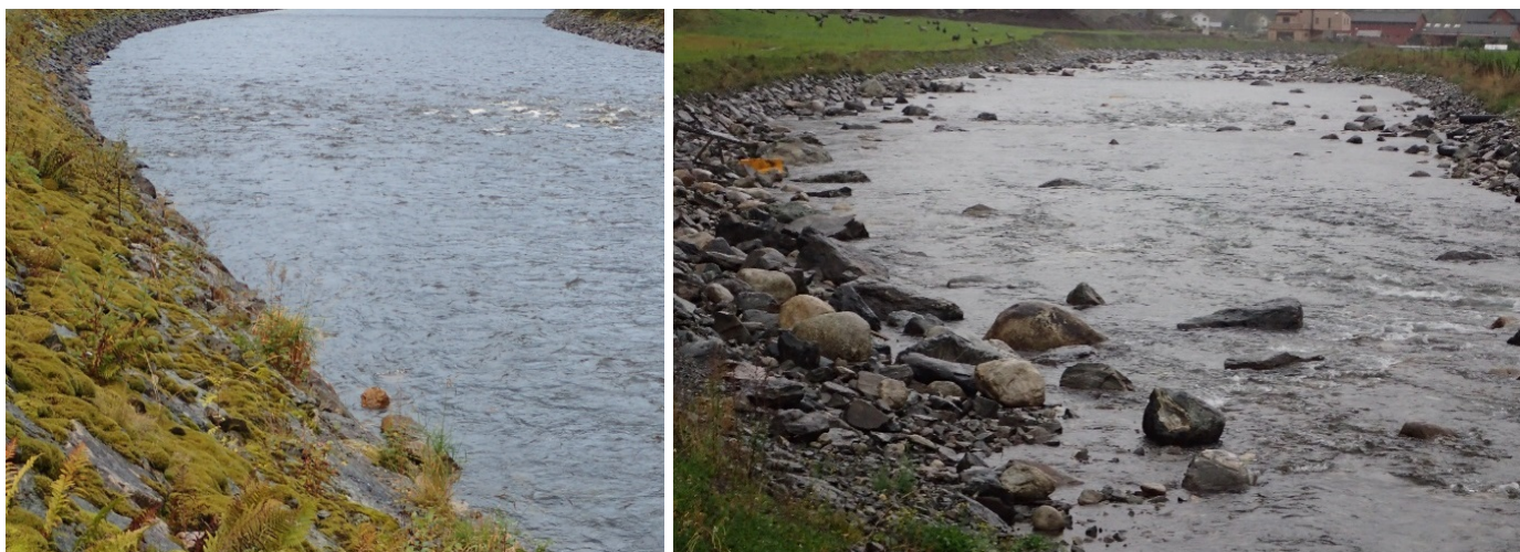
To måter å erosjonssikre en elv. Til venstre konvensjonell kanalisering med glatt plastring. Til høyre tilbakesatt ru erosjonssikring med mer naturtypiske bredder. Begge er hydraulisk tilstrekkelig dimensjonert, men høyre eksempel gir mer skjul for fisk og bedre ungfiskhabitat.
