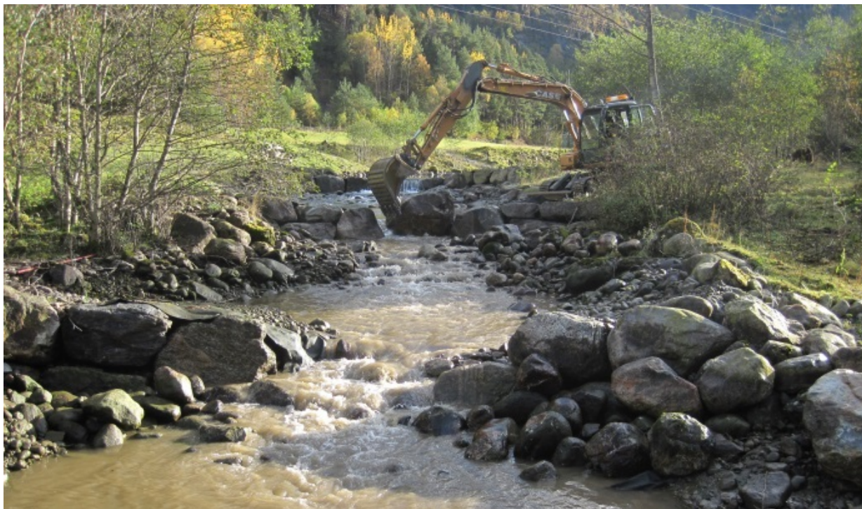
Fig. 16 Fjerning av terskler og reetablering av naturtypisk morfologi (trinn-kulp og stryk type) i sideløp til Aurlandselva (E-Co Energi, Melcon AS, Uni Research Miljø LFI, se også s. 128)
