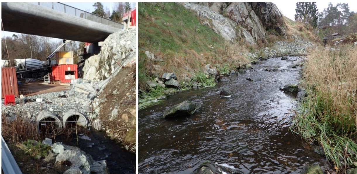
Fig. 12 Gjenåpning FØR-ETTER: Gjenåpnet strekning av Steinsvikbekken i Bergen med gyteplasser og produktivt ungfiskhabitat for sjørret. Ungfisktettheter av ørret og laks økte fra 6 individ/100 m 2 i og ved røret (2014), til 256 ind./100 m 2 (2016, Bybane Utbygging AS, Veidekke AS med Uni Miljø LFI).
