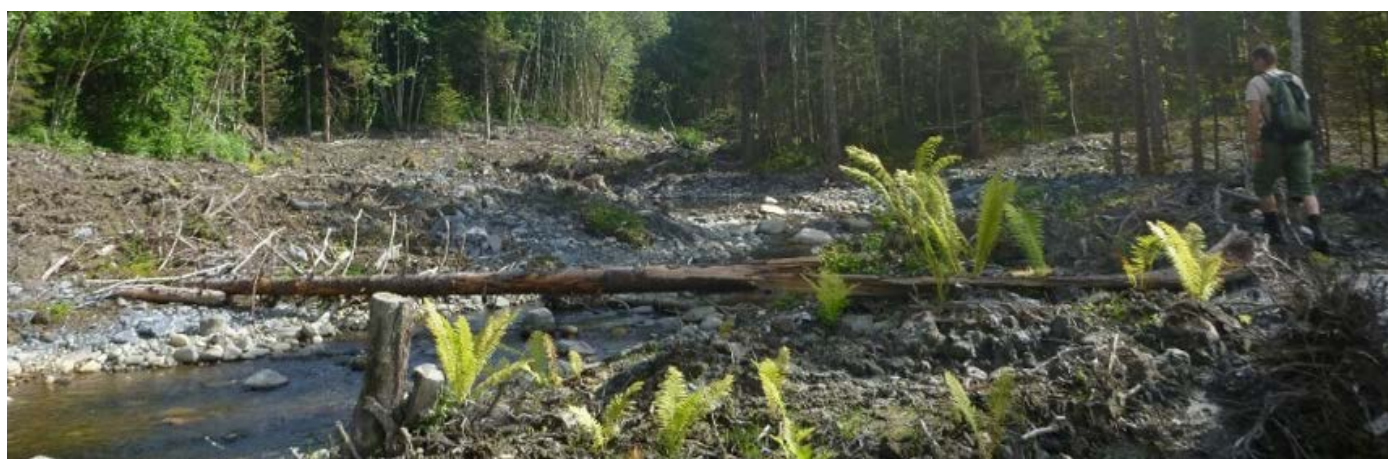
Fig. 121 Prinsippskisse som viser hvordan bekk og terrenget «heves». Bildet under er tatt på sensommeren 2015, og viser at det allerede samme sommer begynte å vokse på stedegne vekstmasser som ble lagt oppå sprengsteinen.
