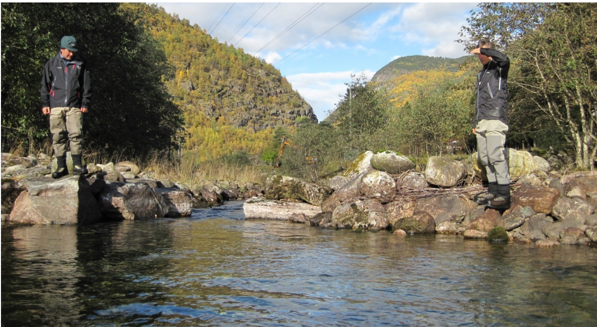
Fig. 19 Åpen grøft som leder vann i sideløpet ved klekkeribekken i Aurland. Vannføringen dimensjoneres av tverrsnittet i innløpet. Hele inntaket er tilgjengelig og enkelt å vedlikeholde, samt at det er passerbart for fisk og gir habitatareal. En slik utforming gir lignende vannføringsdynamikk i sideløpet som i hovedløpet.
