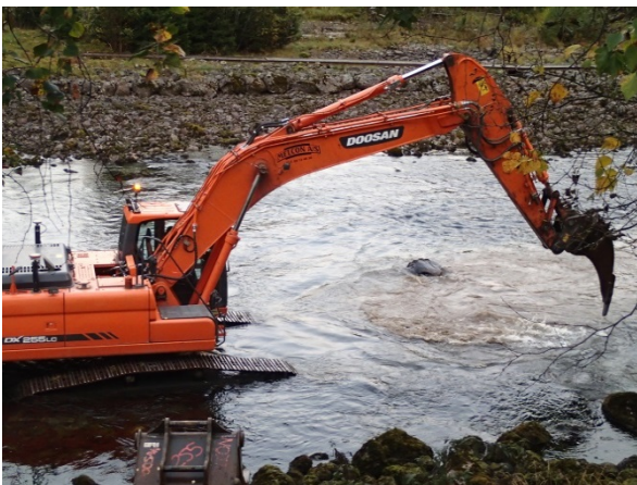
Fig. 55 Harving med ripper.
