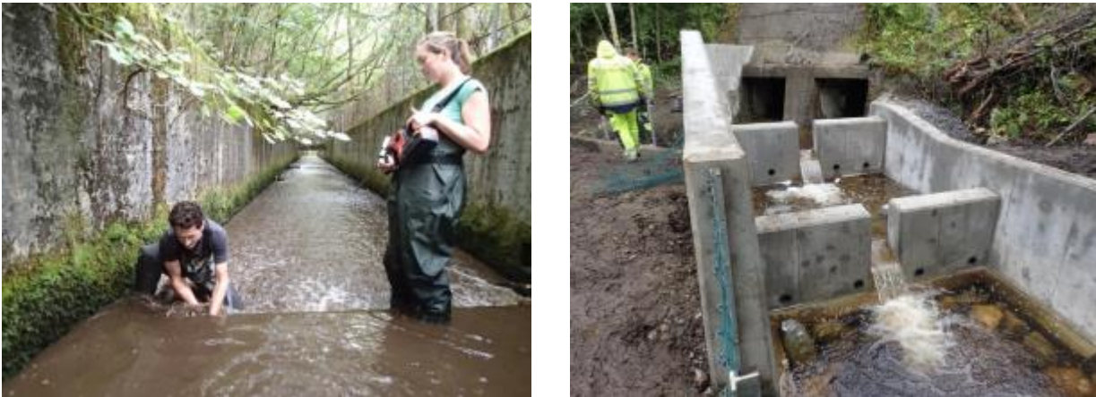
Fig. 74 Venstre: Montering av bunnelementer i en betongkanal som var vandringshindrende ved lav og middels vannføring. Høyre: Fra bygging av fisketrappen ved Osbanekulverten (hybridtrapp).
