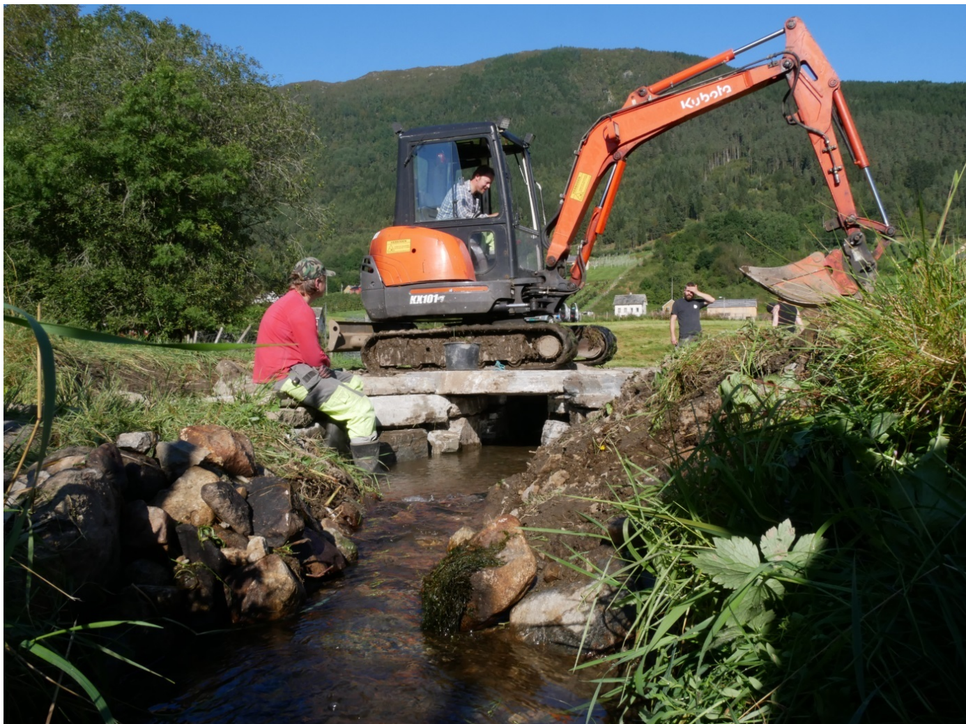
Ulvik Sportsfiskerlag har fjernet rørkulvert og bygget tradisjonell bro av steinheller med gjennomgående naturlig bunns substrat. Fisk kan vandre fritt igjen. (Foto: Hardangerfjord Villfisklag)
