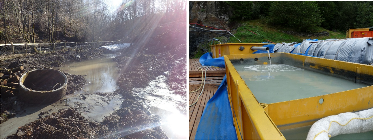
Fig. 59 Tiltak mot finsedimentutslipp fra anleggsområder: Venstre bilde viser en voll ved Apeltunelven som dannet et stort avsetningsbasseng for overvann fra et anleggsområde. Vann fra tunneldriving ble ledet direkte til kommunalt avløpsnett, slik at denne urbane sjørrretelven kunne skjermes mot forurensing. Høyre bilde viser et mobilt renseanlegg for tunneldrivingsvann i bruk for Statens Veivesen ved Granvinsvassdraget.
