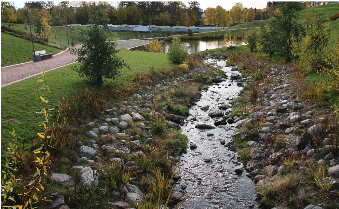
Fig. 13 Bjerkedalen park ble åpnet i oktober 2013. Hovinbekken er gjenåpnet gjennom parken over en strekning på 350 meter. Det er lagt til rette for vandring og opphold for ørret som naturlig hører til i vassdraget. Prosjektet har vunnet Oslo Bys Arkitekturpris i 2015 og pris for Norges beste uterom i 2016. Foto: VAV Etat Oslo.
