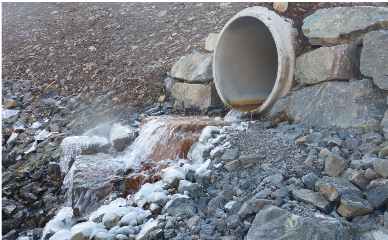
Fig. 7 Ny vandringsbarriere ved veikulvert bygget i 2016 ved munning av anadrom sjørretbekk ved Arefjordpollen, Hordaland.
