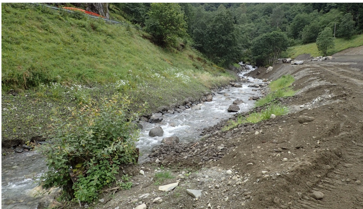
Fig. 66 Fra anleggsområdet Tverrelvi i Flåm 2016. Bekken ble fullstendig erosjonssikret med gjennomgående kant- og bunnplastring (se tegning ovenfor), noe som knapt er synlig. Plastringen er ru og uregelmessig, samt at den er satt ut til side og gravd ned i bakken. Med dette er det rom for naturtypiske elvbredder og substrat i bekken. Kantvegetasjon med stedegen selje og gråor er plantet.
