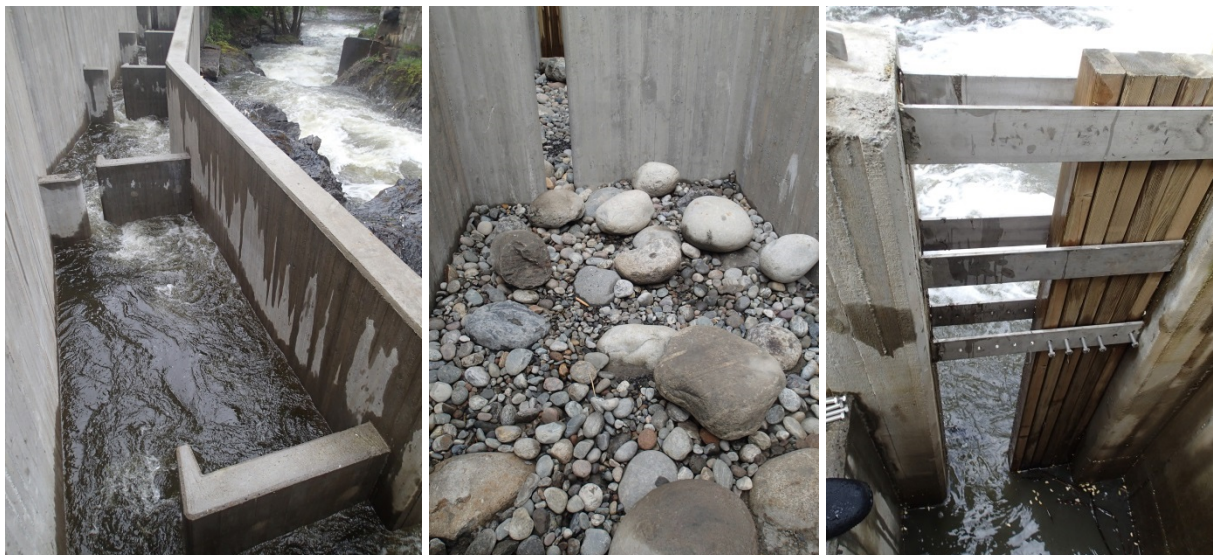
Fig. 37 Norges første spaltetrapp i Akerselva Oslo med typisk diagonalt strømningsmønster, gjennomgående bunnsbstrat og nålestengsel ved inntaket til finregulering av vannføring (Oslo kommune, Uni Research Miljø LFI, Norconsult, 2014).
