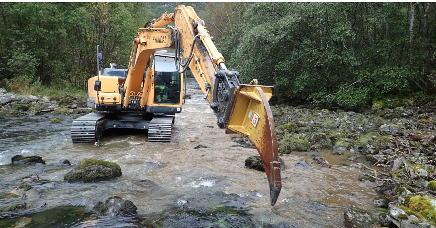
Ripper i aksjon.
